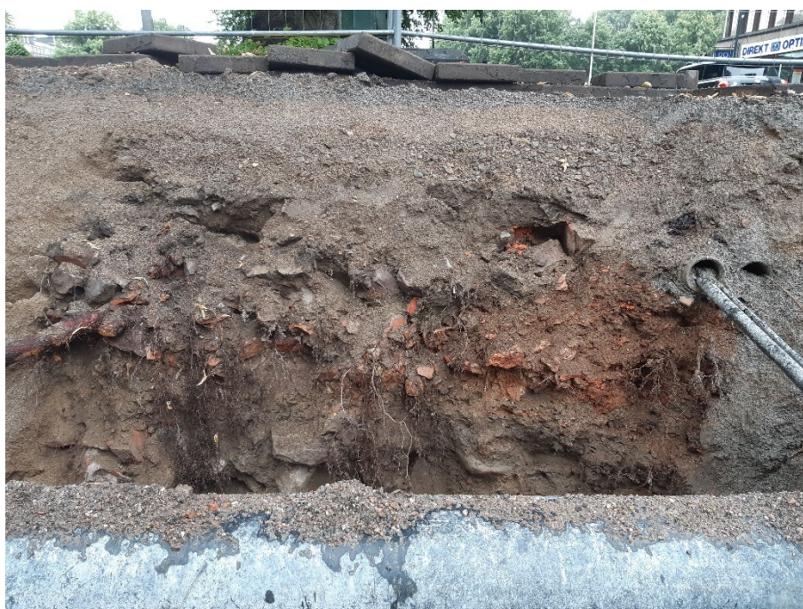
Figur 5. Rikligt med tegelkross och natursten framkom i profilen av schakt 5. Foto: Anders Altner, taget från nordöst.
