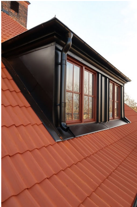
Figur 11 och 12. Takkupa mot norr respektive väster. Nya krönlister i trä fick tillverkas inför inklädnad av plåt på den norra takkupan, då de gamla var uttjänta. Mot väster var fönsterbågar och karmbottenstycket i dåligt skick, troligen på grund av att trädgrenar legat helt nära taket och fönstren. Flera fönsterdelar har bytts ut i takkupan mot väster, bland annat hela karmbottenstycket. Foto: Ulrika Olsson, Läns museet Gävleborg, 2019-10-23.
