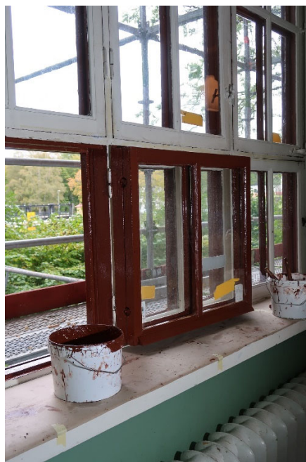
Figur 25 och 26. Fönsterrenovering pågår. Till vänster syns utbytt del i mittpost i fönsterparti beläget i en av takkuporna. Till höger båge i bottenplan mot söder. Foto: Ulrika Olsson, Läns museet Gävleborg, 2019-09-25.
