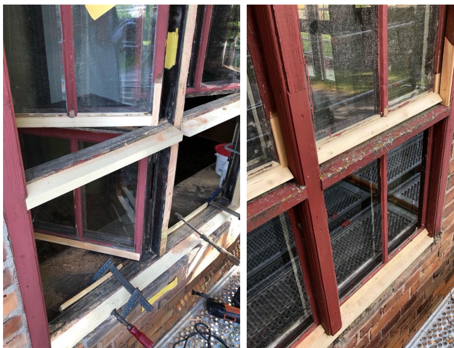
Figur 21 och 22. Fönsterrenovering pågår. Fönsterbågar mot öster. Till vänster en typ av lagning i mittposten, där den spruckna yttre delen har tagits ur för att lagas i med nytt virke, samma metod har använts vid ilagning av tvärposterna. Till höger syns ilagade delar i bågar och karmar. Här syns också att mittposten och tvärposterna är bytta tidigare, notera tvärposternas utskjutande läge mot mittposten. Foto: Ulrika Olsson, Läns museet Gävleborgs, 2019-09-26.
