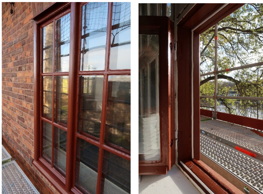
Figur 23 och 24. Fönsterbåge på bottenplan mot norr. Mittposten är bytt. Till höger fönsterbåge mot söder med nyttillkommen isolering. Foto: Ulrika Olsson, Länsmuseet Gävleborg, 2019-10-23.
