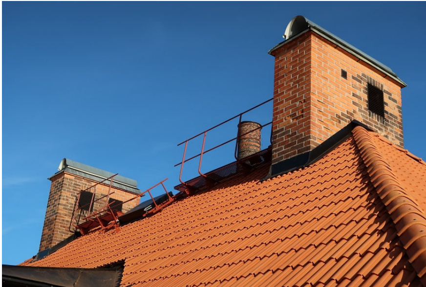
Figur 13. Takbrygga mellan skorstenarna samt taklucka. Foto: Ulrika Olsson, Länsmuseet Gävleborg, 2019-10-30.
