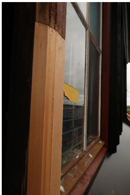
Figur 25 och 26. Fönsterrenovering pågår. Till vänster syns utbytt del i mittpost i fönsterparti beläget i en av takkuporna. Till höger båge i bottenplan mot söder. Foto: Ulrika Olsson, Läns museet Gävleborg, 2019-09-25.
