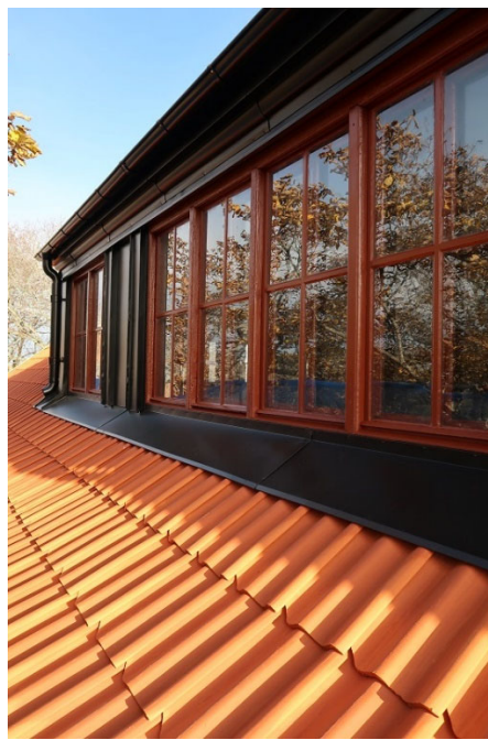
Figur 11 och 12. Takkupa mot norr respektive väster. Nya krönlister i trä fick tillverkas inför inklädnad av plåt på den norra takkupan, då de gamla var uttjänta. Mot väster var fönsterbågar och karmbottenstycket i dåligt skick, troligen på grund av att trädgrenar legat helt nära taket och fönstren. Flera fönsterdelar har bytts ut i takkupan mot väster, bland annat hela karmbottenstycket. Foto: Ulrika Olsson, Läns museet Gävleborg, 2019-10-23.
