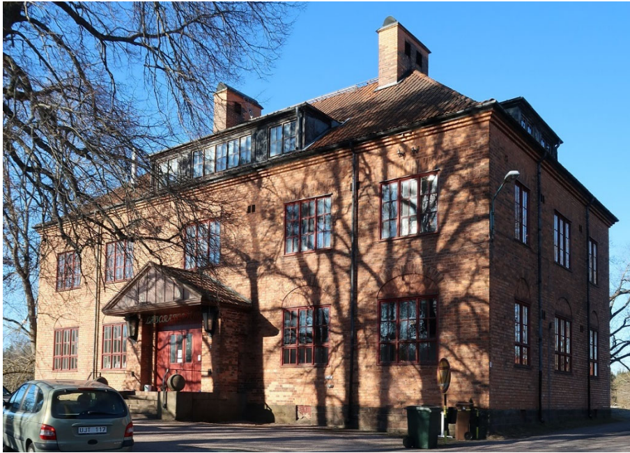
Figur 4. Labbis innan påbörjade arbeten. Byggnaden sedd från Stentorpsvägen. Entrépartiet vetter mot öster. Foto: Ulrika Olsson, Läns museet Gävleborg, 2019-04-15.
