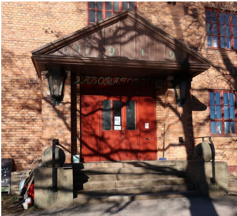
Figur 18. Entrépartiet innan påbörjade arbeten. Foto: Ulrika Olsson, Länsmuseet Gävleborg, 2019-04-15.
