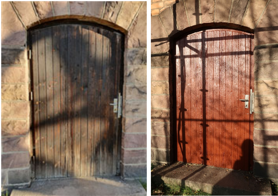
Figur 16 och 17. Källardörren före och efter renovering. Foto till vänster: Mac Nyberg, Maxim Arkitekter, 2019-04-15. Foto till höger: Ulrika Olsson, Länsmuseet Gävleborg, 2019-10-30.
