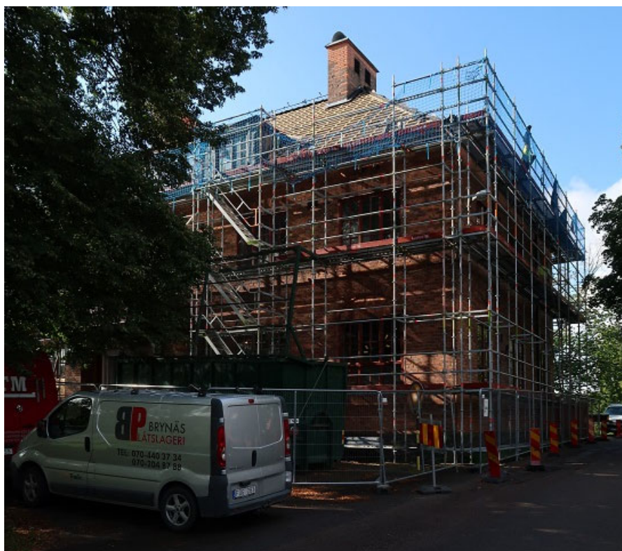
Figur 8. Renoveringsarbetena är igång. Det gamla takteglet är demonterat och fönsterrenovering pågår. Foto: Ulrika Olsson, Länsmuseet Gävleborg, 2019-09-11.
