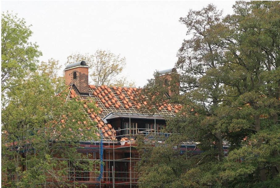
Figur 10. Takarbeten pågår. Skorstenarna har försetts med nya beslag, fotplåtarna är bytta och takkuporna har klätts in med ny plåt. Foto: Ulrika Olsson, Läns museet Gävleborg, 2019-10-09.
