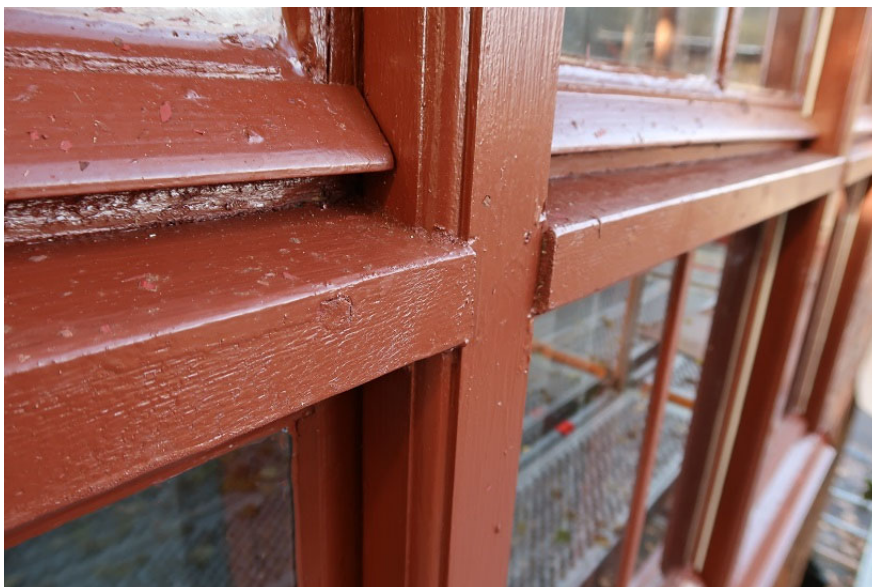
Figur 28. Exempel på hur tidigare ilagning/byte av tvärposter ser ut. Delarna är utskjutande i förhållande till mittposten. Droppnäsorna är bytta inom detta projekt. Foto: Ulrika Olsson, Läns museet Gävleborg, 2019-10-23.
