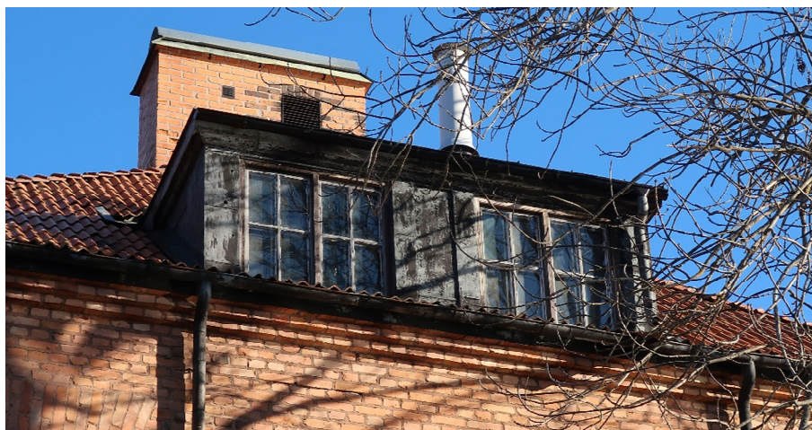
Figur 2 och 3. Labbis innan påbörjade arbeten. Nedre bilden visar takkupan som vetter mot söder. Ovan denna syns ventilationskanalen från dragskåpen. Denna har tagits bort inom detta projekt. Foto: Ulrika Olsson, Läns museet Gävleborg, 2019-04-15.
