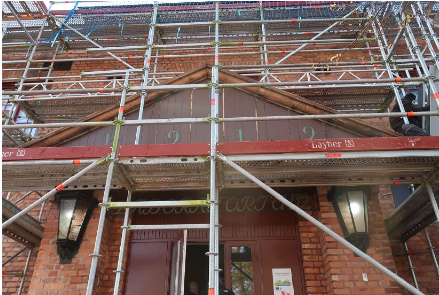
Figur 19. Entrépartiet vid slutbesiktningen. Plåtarbeten pågår. Här syns även det nymålade portpartiet. Foto: Ulrika Olsson, Läns museet Gävleborg, 2019-10-30.
