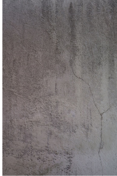
Figur 10 och 11. Urtagning av fönsterbågar samt skrapning av karmar på den västra långsidan. Exempel på putsens skick innan påbörjade arbeten. Kalkfärgen ströks ett lager vid den senaste renoveringen 1996. Tornets puts var kraftigt smutsad. Foto: Ulrika Olsson, Läns museet Gävleborg, 2019-05-15.
