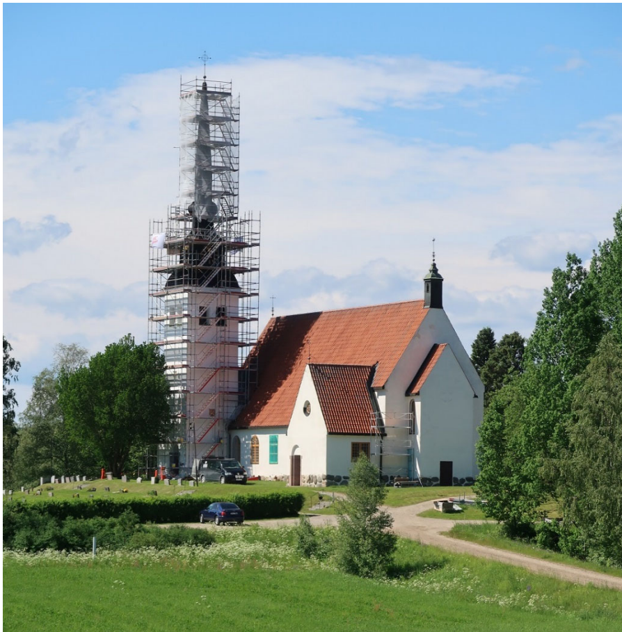
Figur 12. Arbeten pågår och ställningen är rest ända upp i tornspiran för att nå alla spånklädda ytor. Foto: Ulrika Olsson, Läns museet Gävleborg, 2019-06-18.
