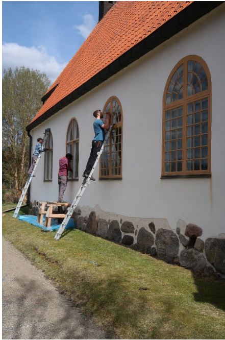
Figur 10 och 11. Urtagning av fönsterbågar samt skrapning av karmar på den västra långsidan. Exempel på putsens skick innan påbörjade arbeten. Kalkfärgen ströks ett lager vid den senaste renoveringen 1996. Tornets puts var kraftigt smutsad. Foto: Ulrika Olsson, Läns museet Gävleborg, 2019-05-15.
