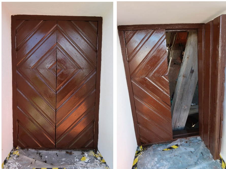
Figur 15 och 16. Ljudluckor efter avslutade arbeten. Foto: Ulrika Olsson, Länsmuseum Gävleborg, 2019-06-18.
