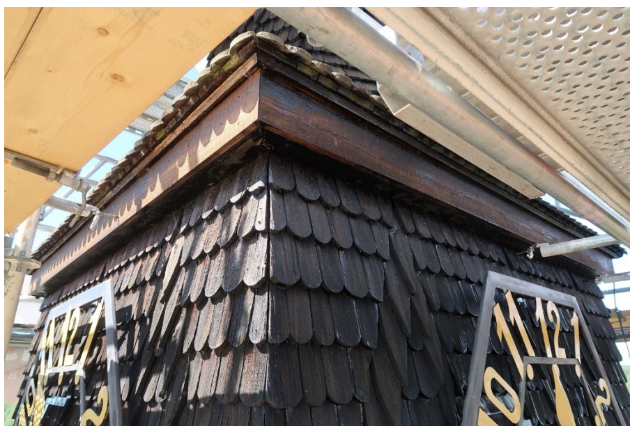
Figur 14. Nya vindskivor i takpartiet med tornuren, samt bytta spån ovanför dessa. Foto: Ulrika Olsson, Läns museet Gävleborg, 2019-06-18.
