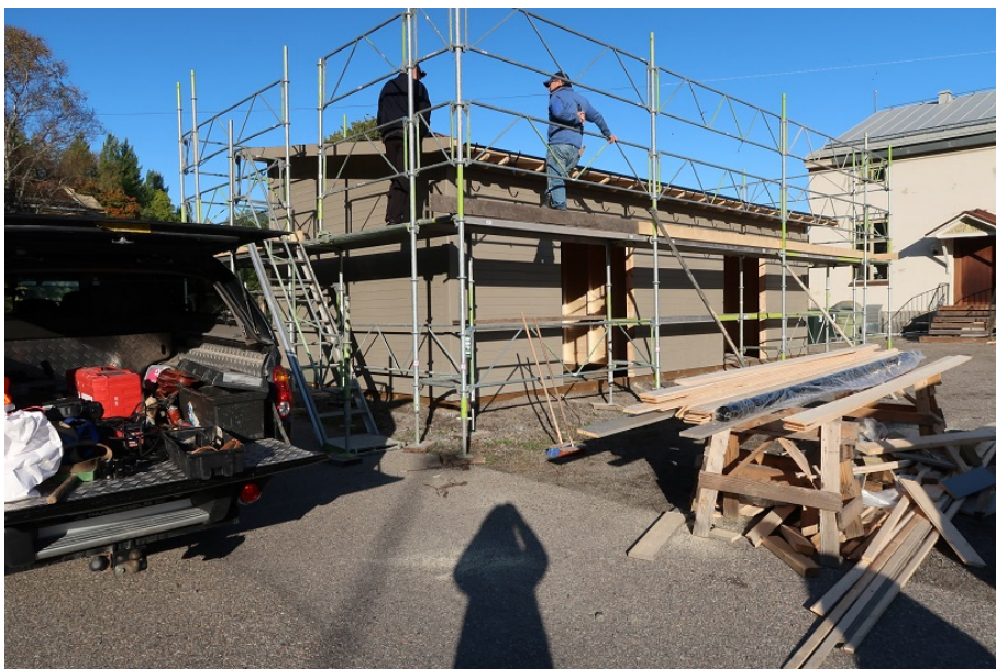
Figur 11. Förrådet sett från sydöst. Logerepresentanter monterar hängrännan. Portbladen är ännu inte upphängda. Foto: Ulrika Olsson, Länsmuseet Gävleborg, 2019-09-27.
