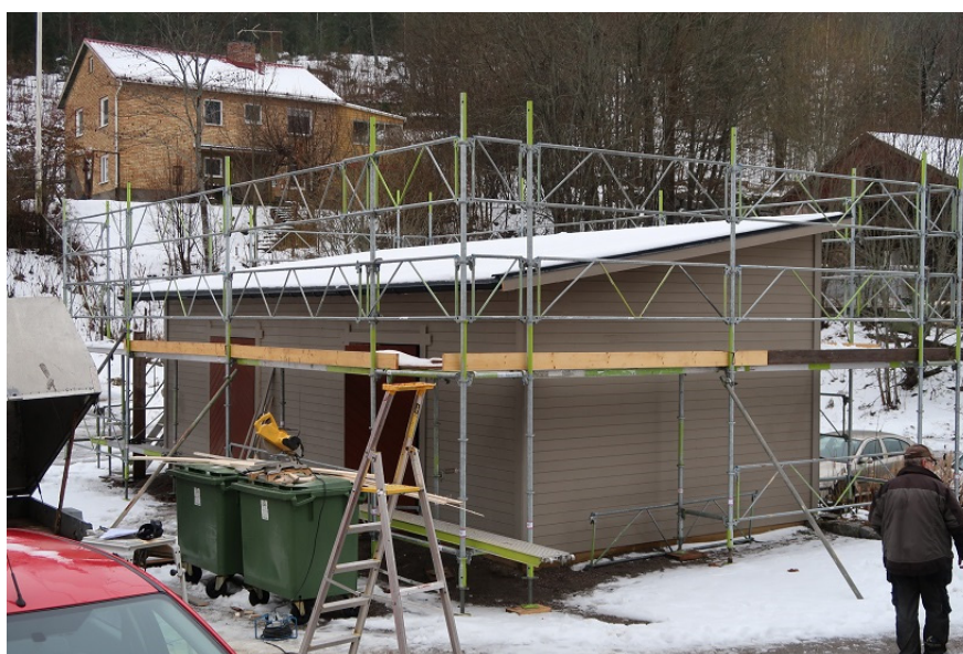
Figur 13. Förrådet sett från nordöst. Takpappen var täckt av snö vid slutbesiktningen. Sockelbrädan saknas ännu. Foto: Ulrika Olsson, Länsmuseet Gävleborg, 2019-11-13.
