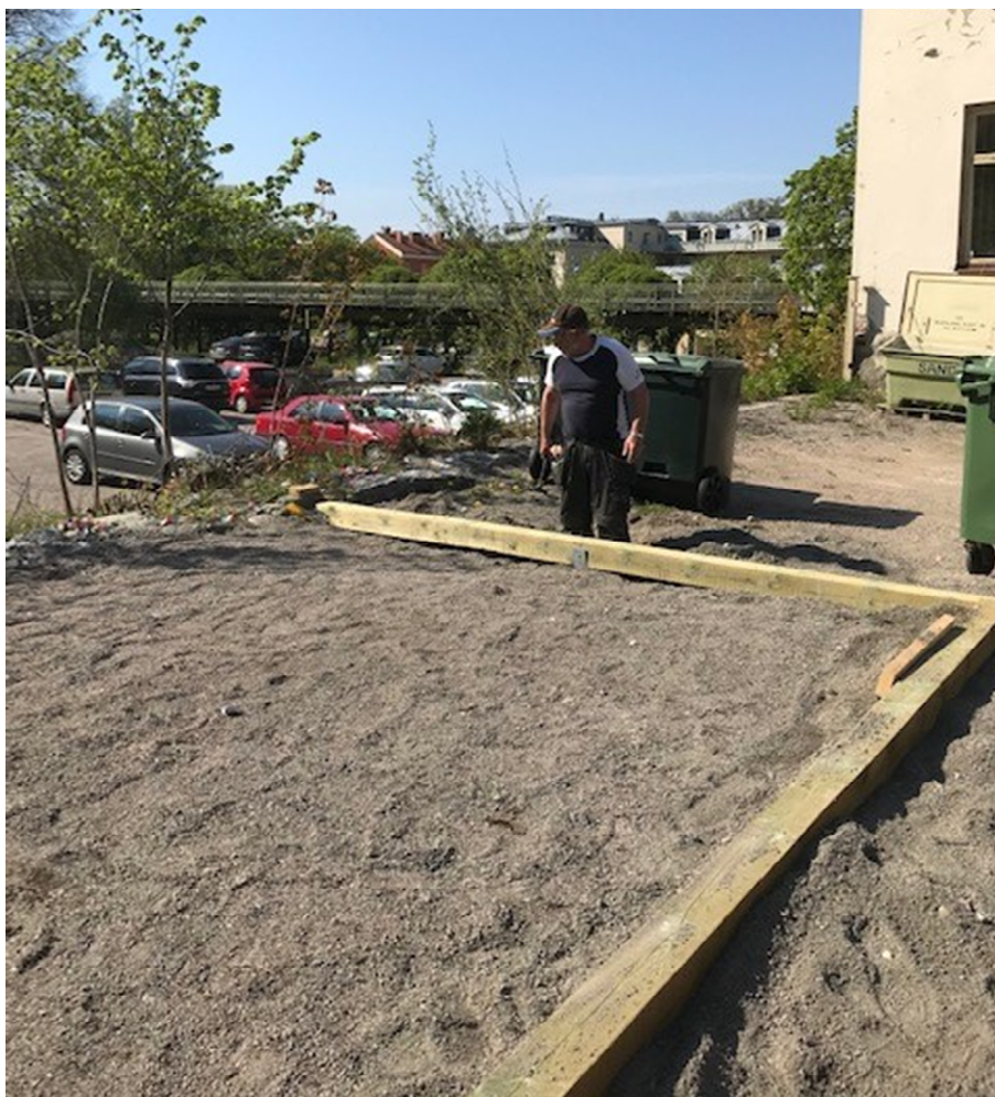
Figur 6. Logemedlemmar arbetar med grundläggningen. De ursprungliga grundstenarna har återanvänts. Foto: Björn Lindqvist, Odd Fellowlogen Helsingia, 2019-05-30.
