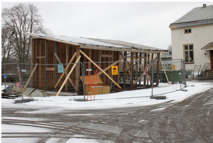
Figur 3. Rivningen av det tidigare förrådet, med ursprunglig funktion som vedbod, pågår. Foto: Ulrika Olsson, Länsmuseet Gävleborg, 2016-04-01.
