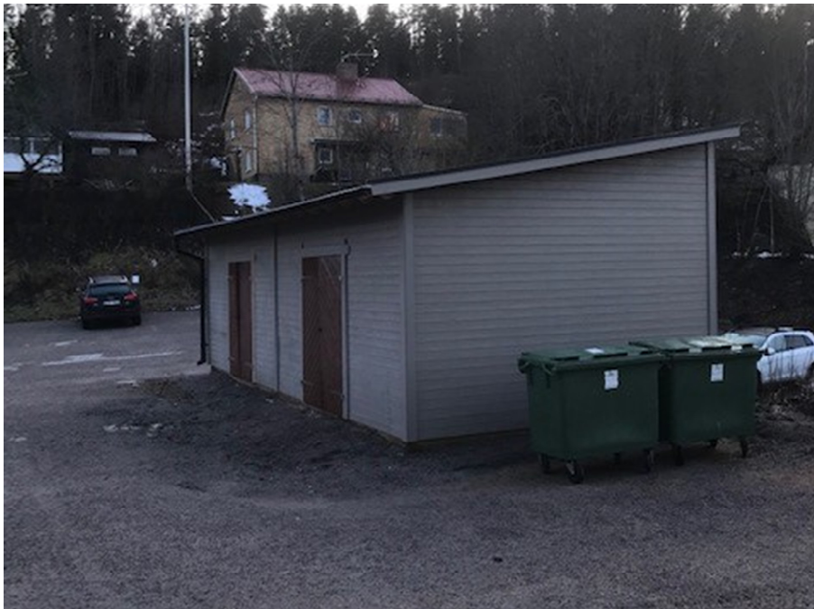
Figur 16. Ställningen är borta och stupröret är på plats. Förrådet sett från nordöst. Foto: Björn Lindqvist, Odd Fellowlogen Helsingia, 2019-12-16.
