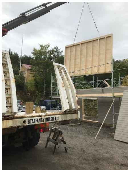
Figur 7 och 8. Monteringen av förrådsbyggnadens väggar och tak pågår. Elementerna från byggprogrammet på Staffangymnasiet har både byggts och monterats. Foto: Björn Lindqvist, Odd Fellowlogen Helsingia, 2019-09-24.
