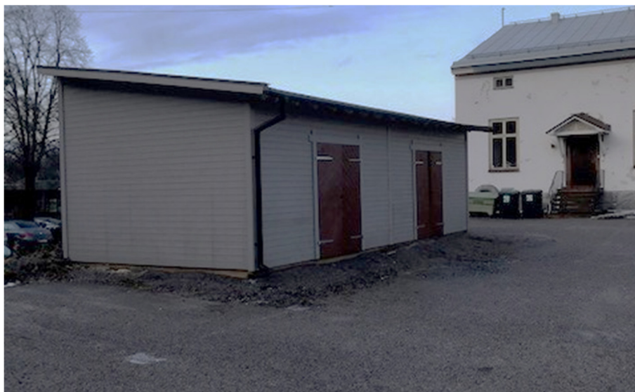
Figur 17. Förrådsbyggnaden sedd från sydöst. Stupröret har skarpa vinklar. Här syns täckbrädan över skarven i panelen mellan portarna. Foto: Björn Lindqvist, Odd Fellowlogen Helsingia, 2019-12-16.
