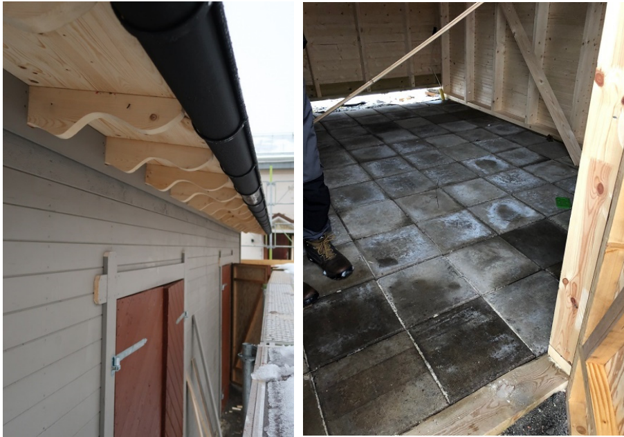
Figur 14 och 15. Slutbesiktning. Portbladen är på plats. Visst målningsjobb återstår. Det högra utrymmet ska användas som soprum, varför marken där har täckts med betongplattor. Det vänstra utrymmet saknar golvbeläggning. Foto: Ulrika Olsson, Länsmuseet Gävleborg, 2019-11-13.
