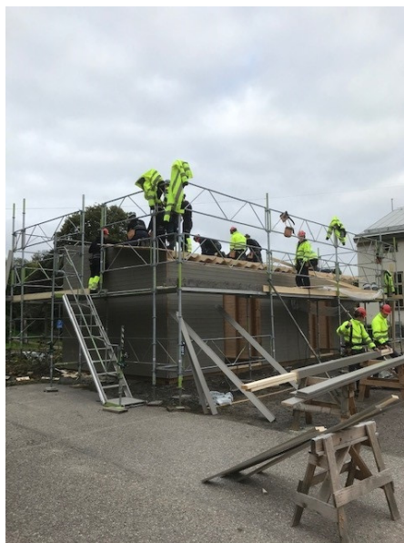
Figur 7 och 8. Monteringen av förrådsbyggnadens väggar och tak pågår. Elementerna från byggprogrammet på Staffangymnasiet har både byggts och monterats. Foto: Björn Lindqvist, Odd Fellowlogen Helsingia, 2019-09-24.
