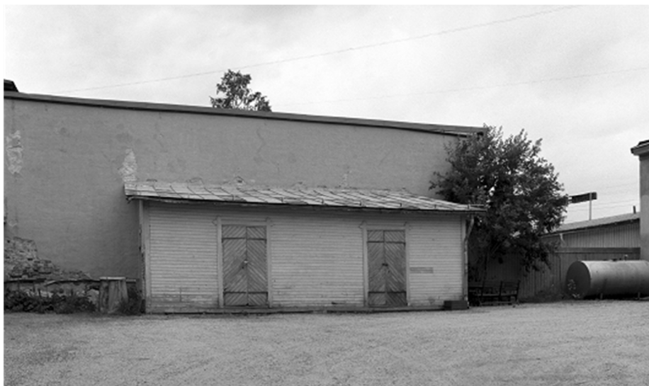
Figur 2. Förrådsbyggnaden 1982. Fotot ingår i Länsmuseet Gävleborgs fotosamling.
