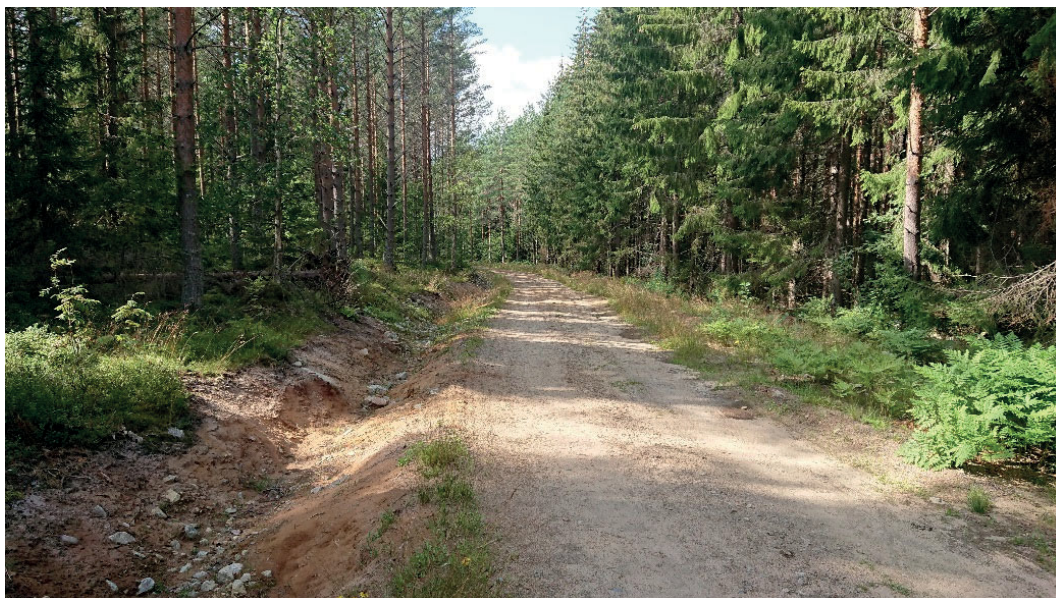
Figur 3. Skogsbilvägen skär genom boplaten Harmånger 110:1. Dikningsarbetet har skett på södra sidan av vägen (till vänster i bild). Bilden tagen från öster. Foto. Inga Blennå.
