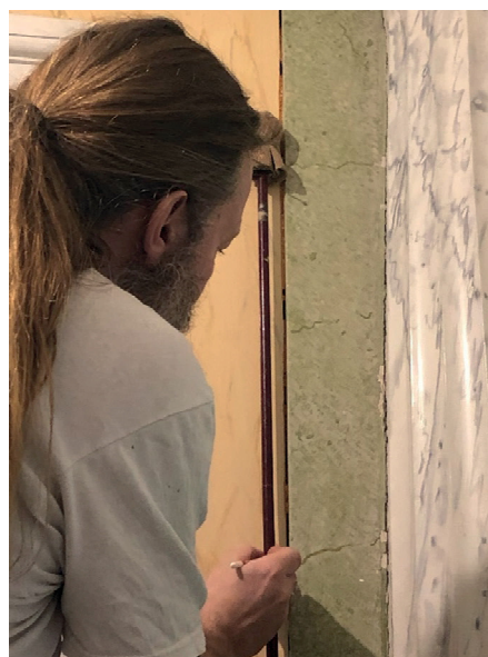
Figur 5 och 6. Målningsarbete pågår i vindfånget. Kaj Halminen drar den röda linjen mellan det gula och gröna fältet med hjälp av en målarkäpp, ett hjälpmedel som använts vid dekorationsmåleri sedan oljemåleriets start, enligt Halminen. Foto: Ulrika Olsson, Läns museet Gävleborg, 2019-12-20.
