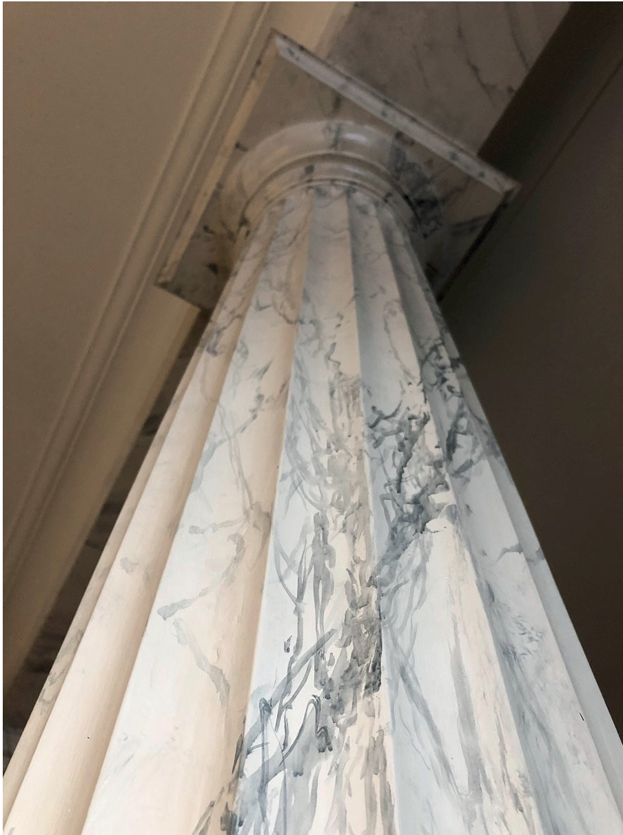
Figur 10. Rekonstruerad marmorering på en av pelarna. Foto: Ulrika Olsson, Läns museet Gävleborg, 2020-01-22.
