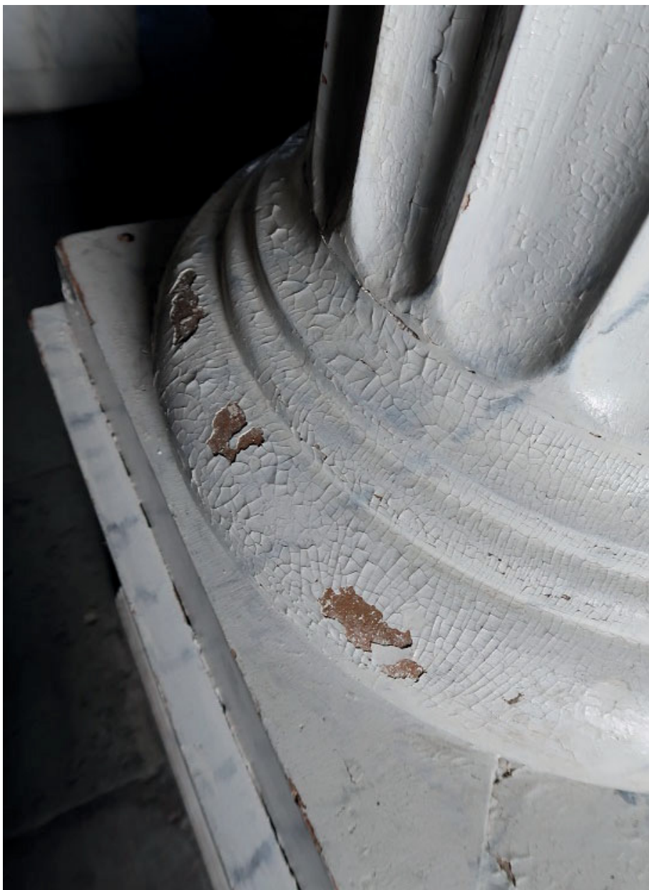
Figur 16. Pelarbas med underliggande brunt färgsikt. Bilden är tagen innan skrapning av ytorna påbörjades. Foto: Ulrika Olsson, Läns museet Gävleborg, 2019-11-05.
