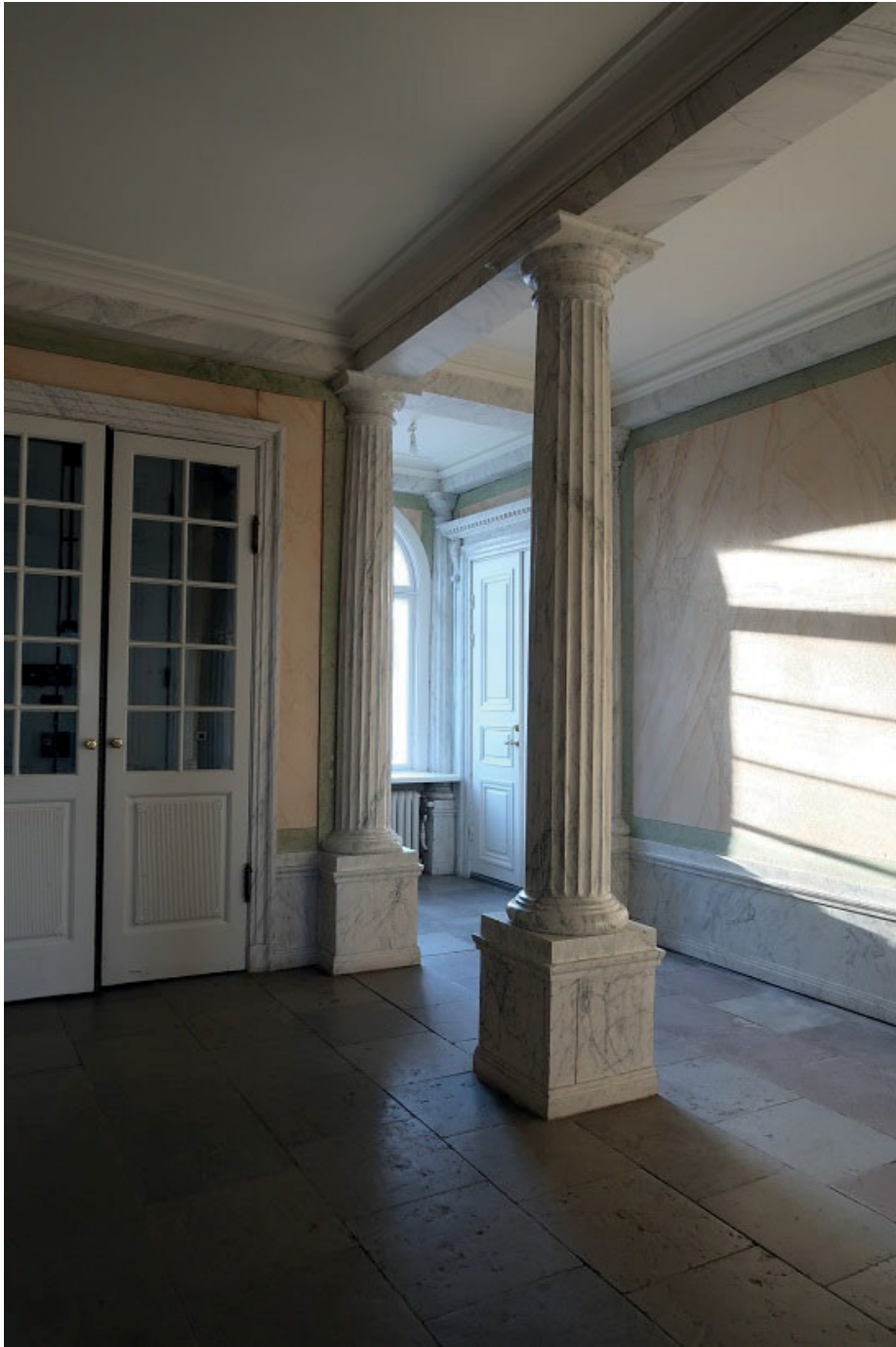
Figur 11. Entréhallens pelarrad där målningsarbetena varit mest omfattande. Foto: Ulrika Olsson, Länsmuseum Gävleborg, 2020-01-22.
