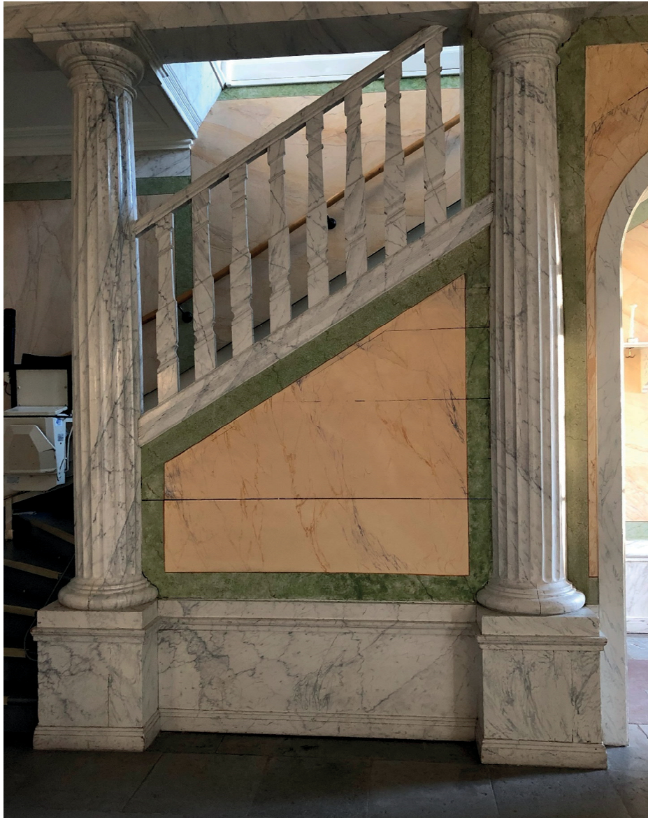
Figur 9. Entréhallen vid slutbesiktningen. Den träklädda ytan nedanför trappan har till största del helt marmorerats om inom detta projekt. Foto: Ulrika Olsson, Länsmuseet Gävleborg, 2020-01-22.
