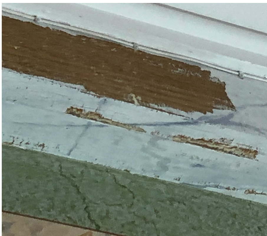
Figur 13. List inne i kapprummet med underliggande färgskikt med ekådring. Foto: Ulrika Olsson, Läns museet Gävleborg, 2019-11-28.
