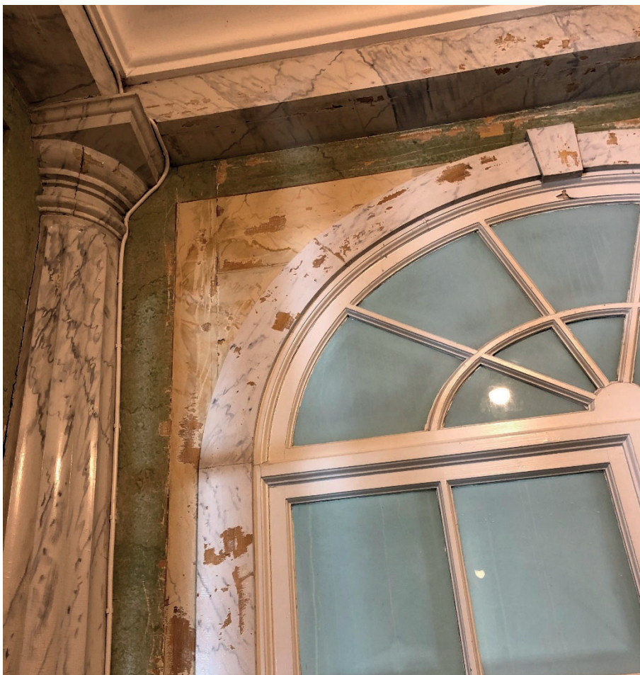
Figur 4. Skrapning pågår i vindfånget. Foto: Ulrika Olsson, Läns museet Gävleborg, 2019-11-28.
