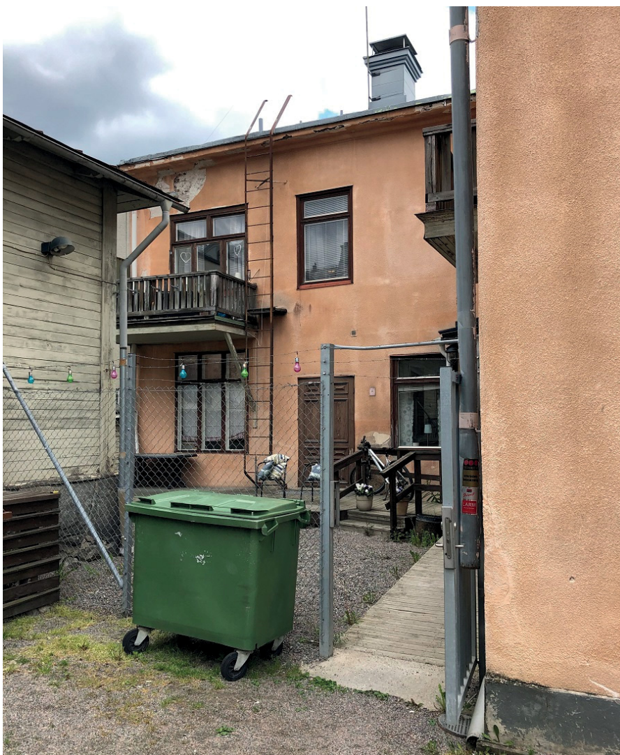
Figur 40. Fotografi in mot gården. Det nedre fönstret till vänster har sannolikt de ursprungliga bågarna bevarade. Övriga är bytta. Porten är belägen i ursprungligt läge, men hade på 1926 års ritningar ett överljus med lika höjd som fönstret till vänster. Foto: Ulrika Olsson, Läns museet Gävleborg, 2020-06-08.
