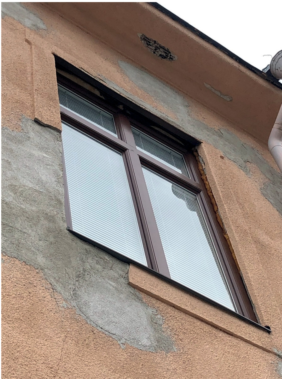
Figur 44. En i sen tid bytt fönsterbåge på första våningen mot Källgatan. Den ursprungliga formen har återtagits men materialet utgörs av aluminium. Foto: Ulrika Olsson, Länsmuseet Gävleborg, 2020-06-08.
