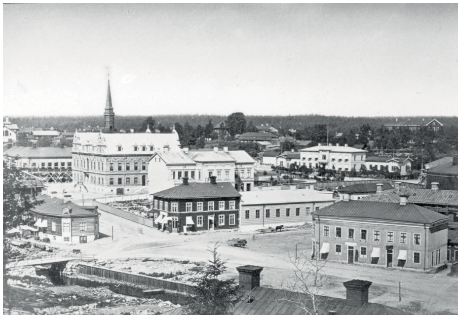
Figur 13. Den mörka byggnaden i bildens mitt är Elefanten 2 bara några år efter brandens ödeläggelse. Söderhamns rådhus syns till vänster. Uppbyggnaden kring rådhuset går snabbt. Som synes är ännu inte Elefanten 1, Rådhuskonditoriet, uppfört. Elefanten 4, Gamla posten, syns i kvarterets nordvästra del. Byggnaden utbrändes vid stadsbranden men kunde senare återuppbyggas. Elefanten 3 är också färdigställd. Byggställningar skymtar vid Oxen, väster om rådhuset.
