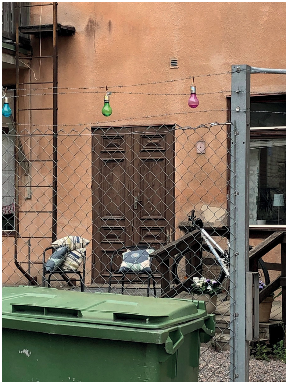
Figur 41. Porten på husets västra sida är från byggåret eller möjligen från 1926 då huset genomgick en exteriör förändring och alla entrépartier ut mot gatorna gavs en ny utformning. Dock har detta parti haft ett överljus längre tillbaka, jämför med ritningarna från 1926. Foto: Ulrika Olsson, Länsmuseet Gävleborg, 2020-06-08.
