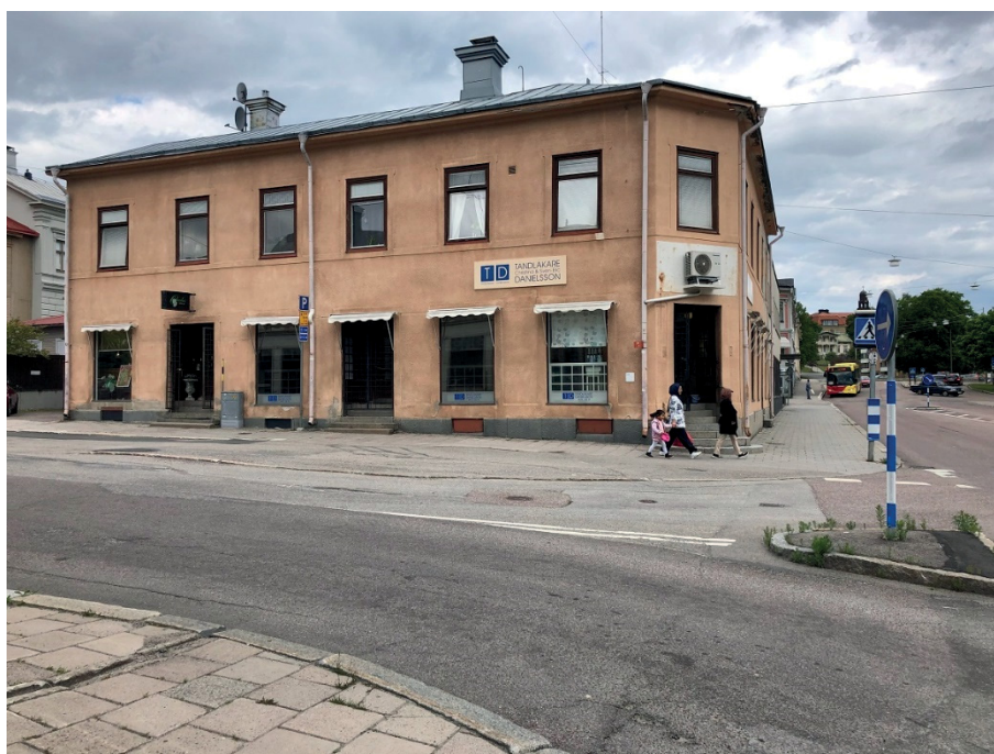
Figur 35. Från söder, Oxtorgsgatan i förgrunden. Huset byggdes till 1926 med delen till vänster om stupröret mitt på fasaden. Foto: Ulrika Olsson, Läns museet Gävleborg, 2020-06-08.
