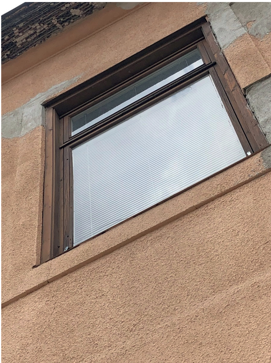
Figur 43. Fönsterbåge av trä på första våningen mot Källgatan. Våningsplanets ursprungliga fönsterbågar med T-post byttes 1967 till denna form. Foto: Ulrika Olsson, Läns museet Gävleborg, 2020-06-08.
