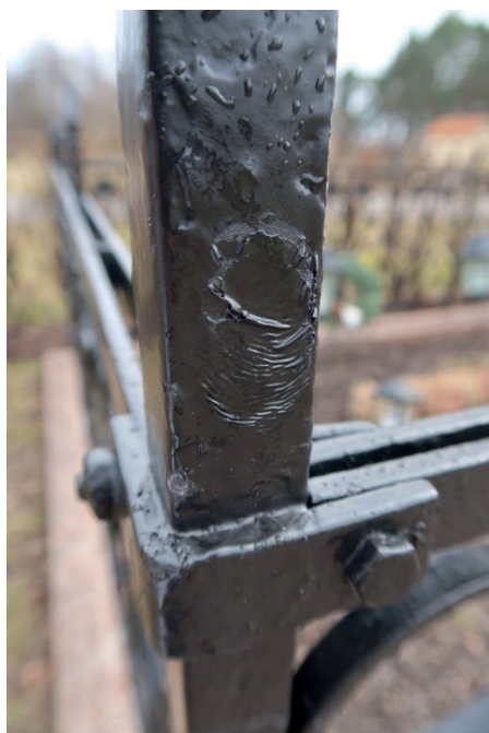
Figur 19–20. K7:0042 med staket i smide, efter avslutade arbeten. Här syns lite skador på färgskikt. Foto: Ulrika Olsson, Länsmuseet Gävleborg, 2020-03-18.
