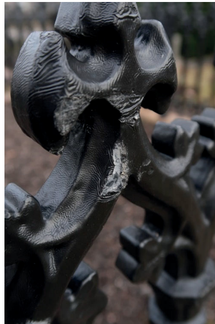
Figur 24–26. K7:0125 med staket i gjutjärn, efter avslutade arbeten. Här syns några missar i målningsarbetet, samt skador tillkomna på grund av att färgen förmodligen inte torkar riktigt innan återmontering. Möjligen är färgen påförd för tjockt med följd att endast det yttersta lagret torkat men inte de underliggande. Foto: Ulrika Olsson, Läns museet Gävleborg, 2020-03-18.
