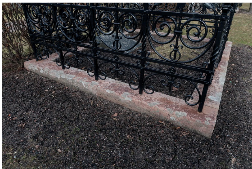
Figur 15–16. K7:0035 med staket i smide, efter avslutade arbeten. Foto: Ulrika Olsson, Länsmuseet Gävleborg, 2020-03-18.
