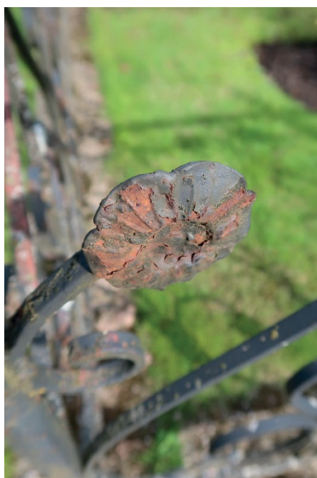
Figur 17–18. K7:0042 med staket i smide, innan påbörjade arbeten. Staketet uppvisade kraftiga rostangrepp och biologisk påväxt. Foto: Ulrika Olsson, Läns museet Gävleborg, 2019-05-20.
