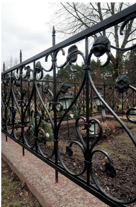
Figur 19–20. K7:0042 med staket i smide, efter avslutade arbeten. Här syns lite skador på färgskikt. Foto: Ulrika Olsson, Länsmuseet Gävleborg, 2020-03-18.
