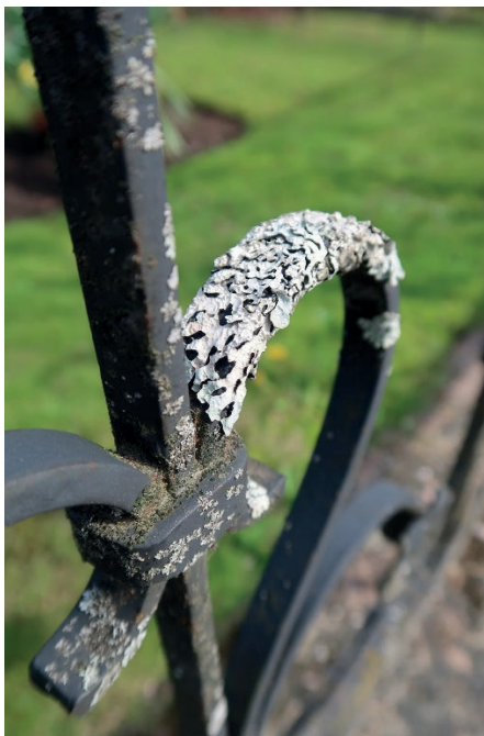
Figur 17–18. K7:0042 med staket i smide, innan påbörjade arbeten. Staketet uppvisade kraftiga rostangrepp och biologisk påväxt. Foto: Ulrika Olsson, Läns museet Gävleborg, 2019-05-20.
