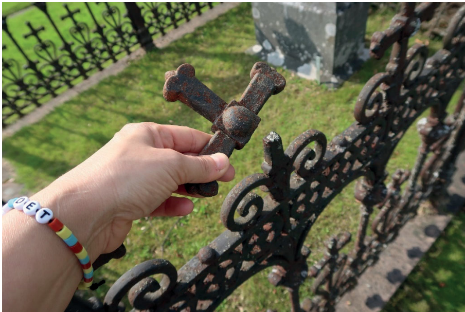
Figur 36–37. K7:0142 med staket av gjutjärn, innan påbörjade arbeten. Staketet uppvisade kraftiga rostangrepp samt flera lösa materialdelar. Foto: Ulrika Olsson, Länsmuseet Gävleborg, 2019-05-20.
