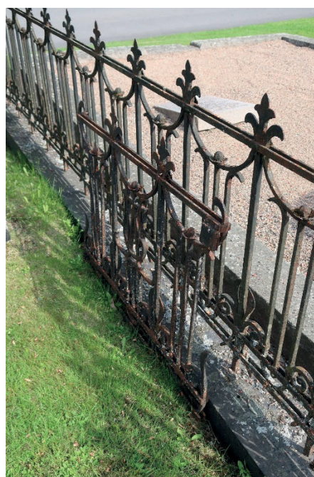
Figur 2–4. K7:0017+0019 med staket i smide, innan påbörjade arbeten. Staketet uppvisade kraftiga rostangrepp och lösa delar. Foto: Ulrika Olsson, Läns museet Gävleborg, 2019-05-20.
