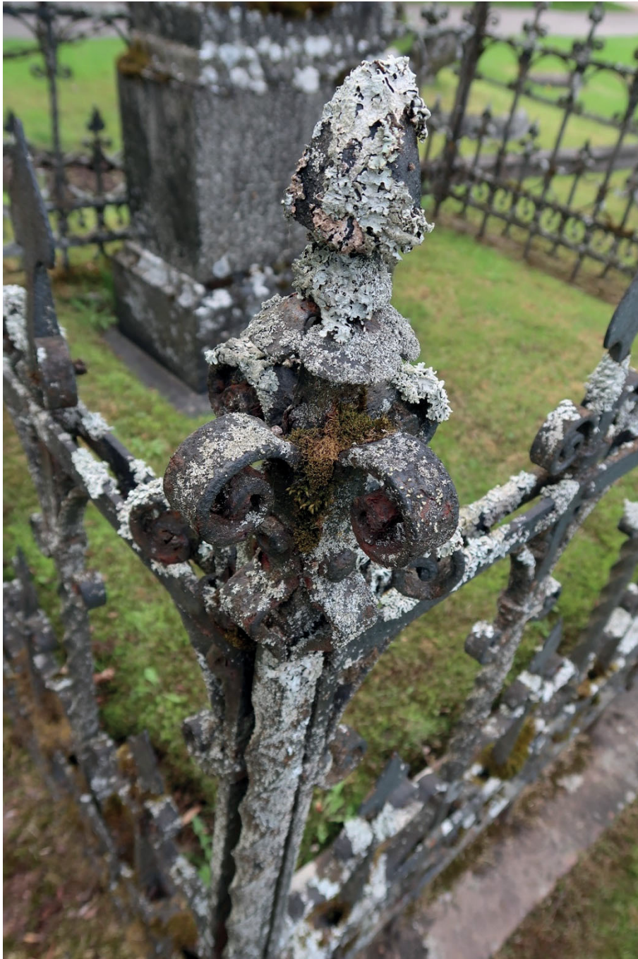
Figur 47. K7:0197 med staket i smide, innan påbörjade arbeten. Foto: Ulrika Olsson, Länsmuseet Gävleborg, 2019-05-20.
