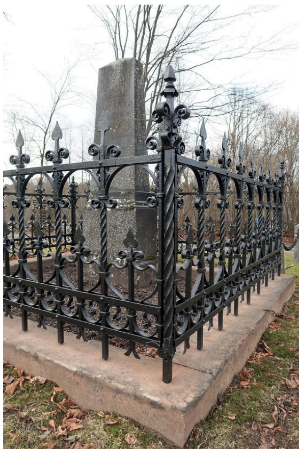
Figur 50–51. K7:0197 med staket i smide, efter avslutade arbeten. Foto: Ulrika Olsson, Länsmuseum Gävleborg, 2020-03-18.
