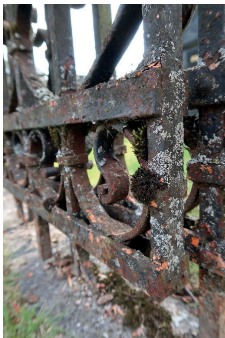
Figur 7–9. K7:0027 med staket i smide, innan påbörjade arbeten. Staketet uppvisade kraftiga rostangrepp och lösa delar. Foto: Ulrika Olsson, Läns museet Gävleborg, 2019-05-20.
