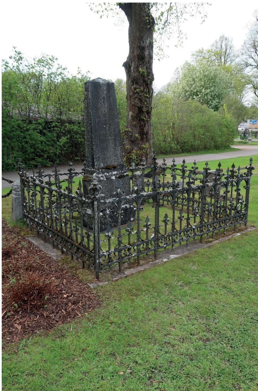
Figur 46. K7:0197 med staket i smide, innan påbörjade arbeten. Staketet uppvisade kraftiga rostangrepp och biologisk påväxt. Som synes har sockeln också sjunkit. Foto: Ulrika Olsson, Läns museet Gävleborg, 2019-05-20.
