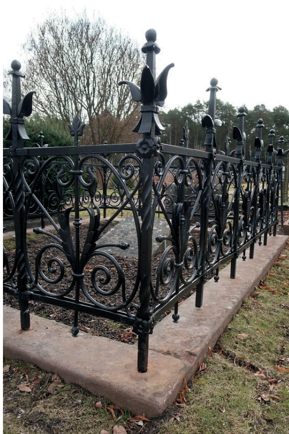
Figur 29–30. K7:0128 med staket i smide, efter avslutade arbeten. Foto: Ulrika Olsson, Länsmuseum Gävleborg, 2020-03-18.
