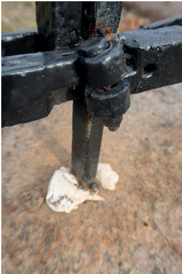
Figur 33–34. K7:0132 med staket i smide, efter avslutade arbeten. På det undre fotografiet syns några rostangrepp där målningen inte har utförts fullt ut. Kring dubbnig mot stensockel kvarstår kalkbruksrester. Foto: Ulrika Olsson, Länsmuseet Gävleborg, 2020-03-18.
