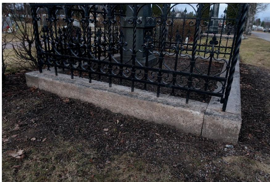
Figur 10–11. K7:0027 med staket i smide, efter avslutade arbeten. Foto: Ulrika Olsson, Länsmuseet Gävleborg, 2020-03-18.
