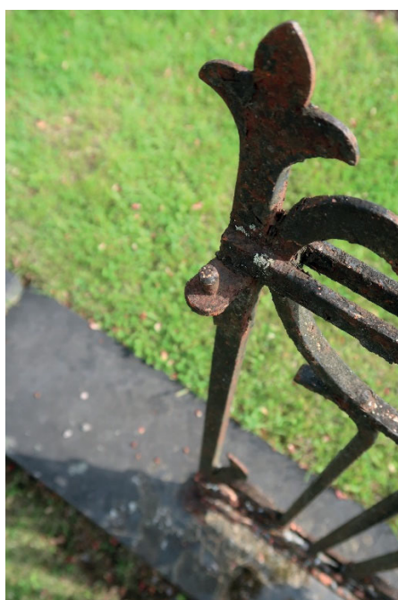
Figur 2–4. K7:0017+0019 med staket i smide, innan påbörjade arbeten. Staketet uppvisade kraftiga rostangrepp och lösa delar. Foto: Ulrika Olsson, Läns museet Gävleborg, 2019-05-20.
