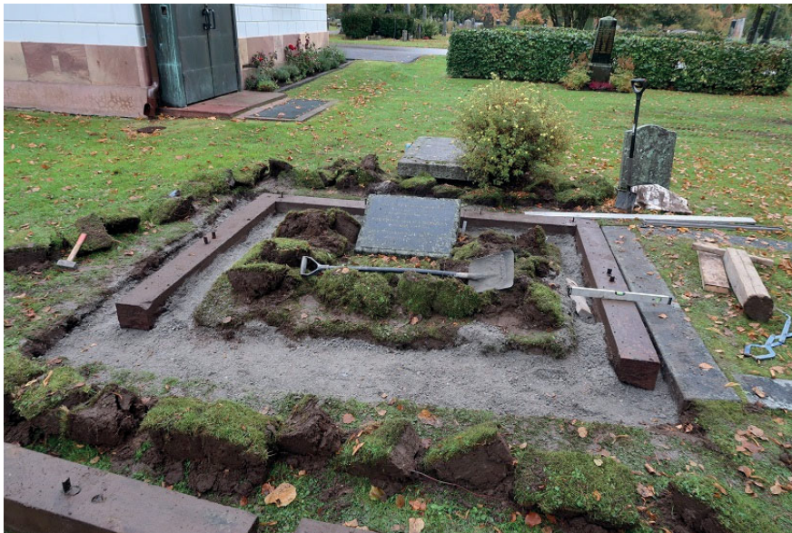
Figur 44. K7:0142 under pågående arbeten. Här syns grundläggning och arbete med återmontering av stenramen. Foto: Ulrika Olsson, Läns museet Gävleborg, 2019-10-09.
