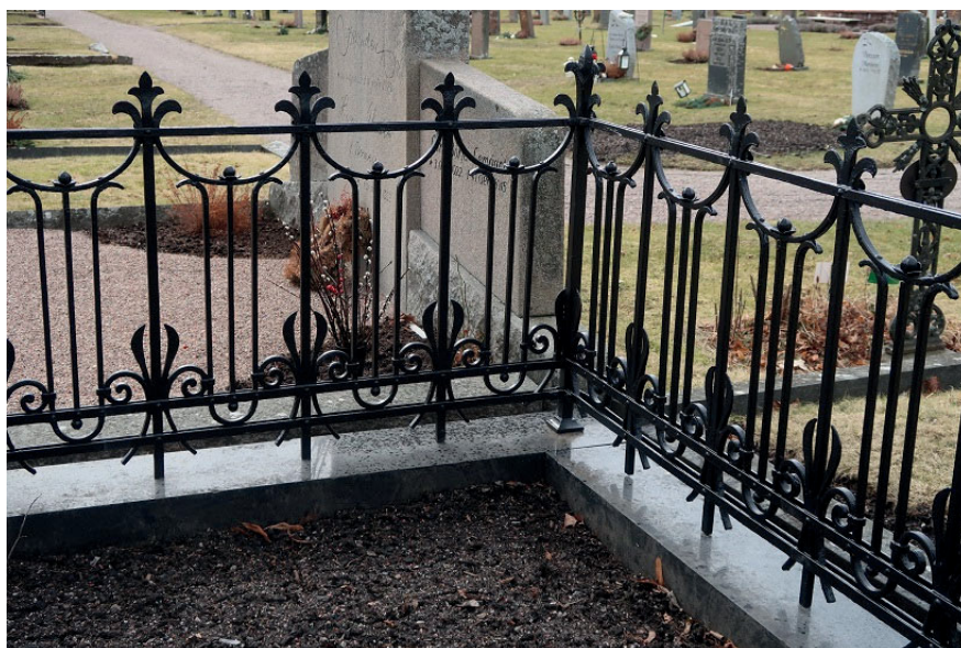
Figur 5–6. K7:0017+0019 med staket i smide, efter avslutade arbeten. Foto: Ulrika Olsson, Länsmuseet Gävleborg, 2020-03-18
