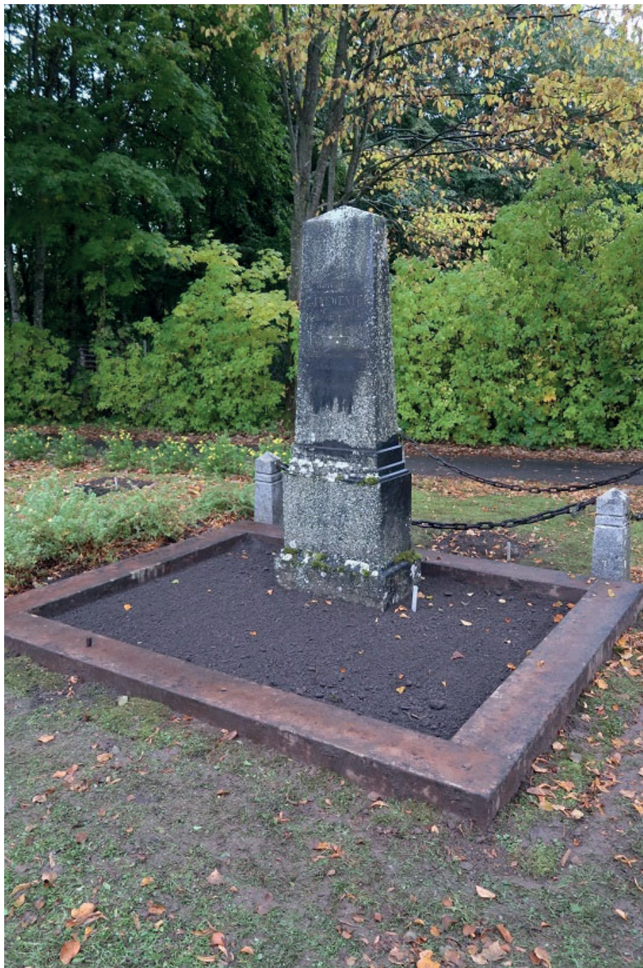
Figur 49. K7:0197 under pågående arbeten. Arbetet med stenramen är slutfört. Smidesstaketet är inne på verkstad för målningsbehandling. Foto: Ulrika Olsson, Länsmuseet Gävleborg, 2019-10-09.
