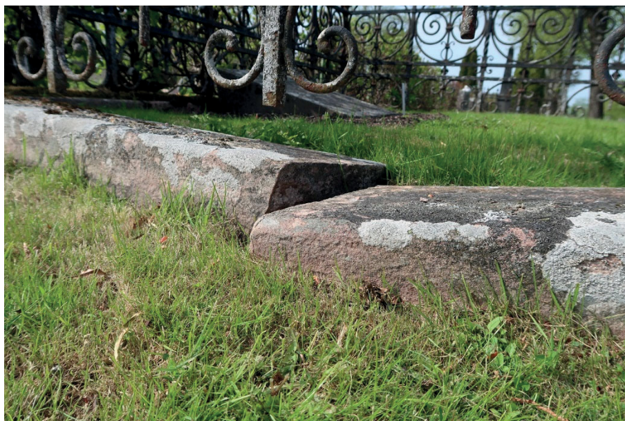
Figur 12–13. K7:0035 med staket i smide, innan påbörjade arbeten. Staketet uppvisade kraftiga rostangrepp. Notera även kraftiga sättningar i stenramen. Foto: Ulrika Olsson, Läns museet Gävleborg, 2019-05-20.
