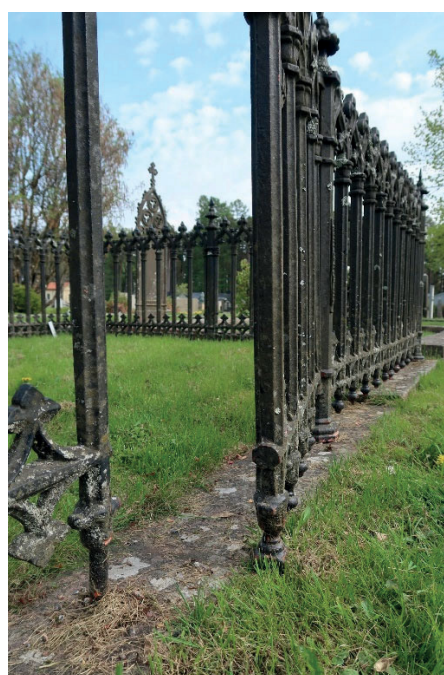
Figur 21–23. K7:0125 med staket i gjutjärn, innan påbörjade arbeten. Staketet uppvisade kraftiga rostangrepp och lösa delar. Foto: Ulrika Olsson, Läns museet Gävleborg, 2019-05-20.
