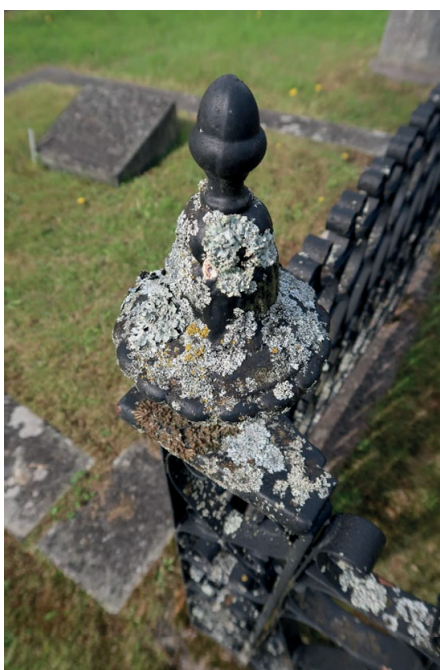
Figur 41–43. K7:0190 med staket i smide, innan påbörjade arbeten. Staketet uppvisade kraftiga rostangrepp och biologisk påväxt. Foto: Ulrika Olsson, Läns museet Gävleborg, 2019-05-20.
