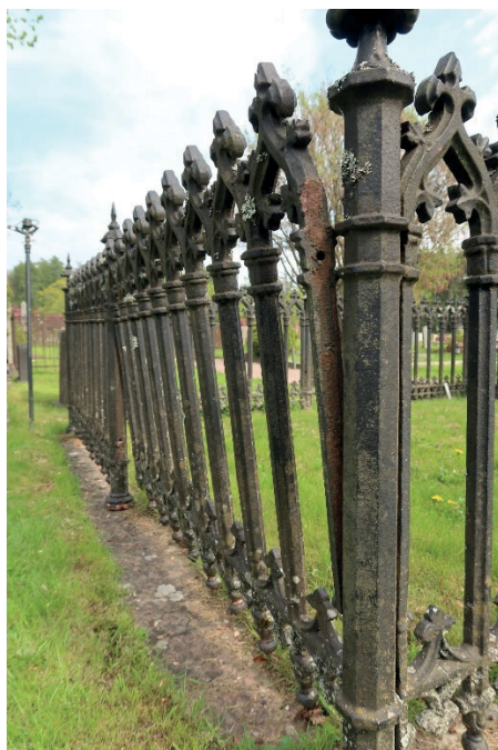
Figur 21–23. K7:0125 med staket i gjutjärn, innan påbörjade arbeten. Staketet uppvisade kraftiga rostangrepp och lösa delar. Foto: Ulrika Olsson, Läns museet Gävleborg, 2019-05-20.
