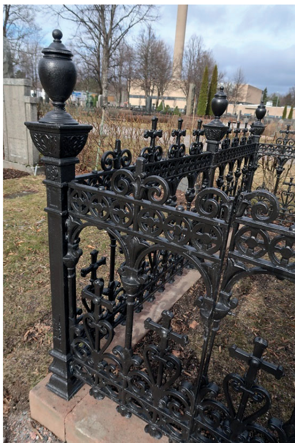
Figur 38–39. K7:0142 med staket av gjutjärn, efter avslutade arbeten. Foto: Ulrika Olsson, Länsmuseum Gävleborg, 2020-03-18.
