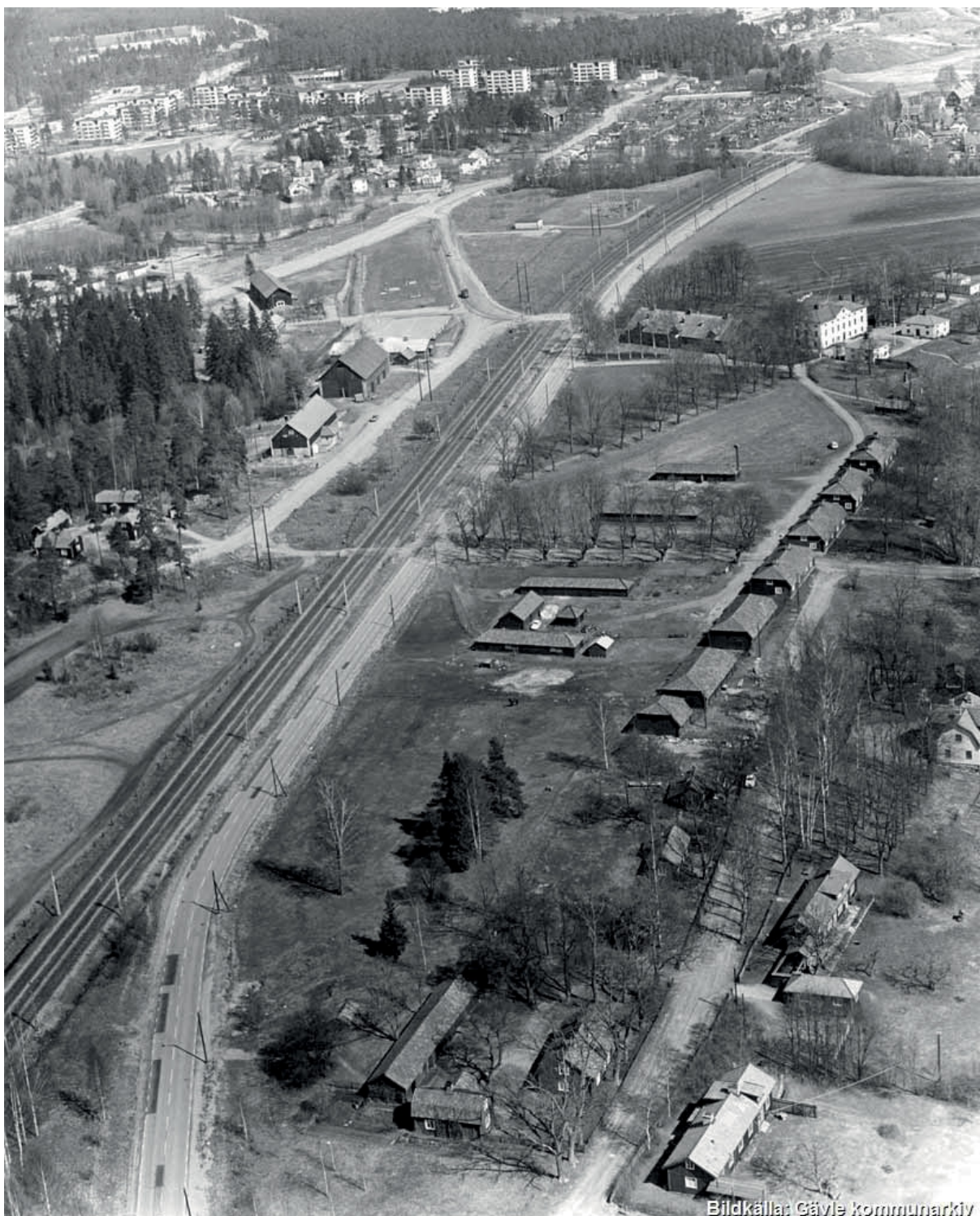
Figur 19. Flygfoto från väster 1969. Rättarbostället i mitten på bild till vänster, ridskolans byggnader strax ovanför. Vid talldungen i mitten på bilden högst upp, framför de nybyggda flerfamiljshusen i Sättra, skymtar Bäckebo skola. Framför skolan sträcker sig villaområdet och koloniområdet i utredningsområdets östra del. Notera även allésystemen inom bruksområdet. Allén väster ut från herrgården mötte tidigare allén som går genom bruksgatan genom en mjuk kurva. Mötet försvagades i och med järnvägens ankomst under slutet av 1850-talet och suddades ut ytterligare då Lexevägen drogs fram i mitten på 1900-talet. Foto: Gävle Kommunarkiv.
