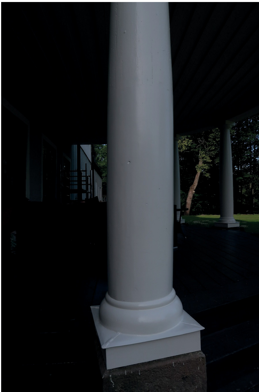
Figur 6. Pelare 1 efter avslutade arbeten. Pelarpanelen består av nytt virke längst ner och upp till en höjd av cirka 1,50 meter. De rundade delarna, liksom den kvadratiska lådbasen, består av nytt virke. Plåtavtäckningen är ny. Alla pelare, utom nummer 7, har nytt trä i rundande delar och lådbas. Foto: Ulrika Olsson, Läns museet Gävleborg, 2020-06-30.
