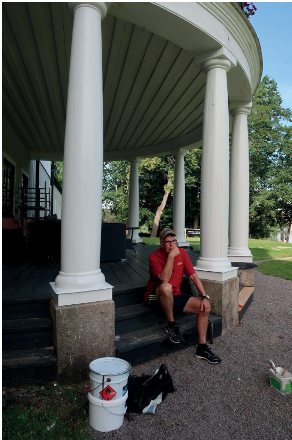
Figur 7. Lennart Bryngelsson från Bostadsrättsföreningen Forsbacka herrgård vid slutbesiktningen. Pelare 1 närmast i bild. Foto: Ulrika Olsson, Läns museet Gävleborg, 2020-06-30.
