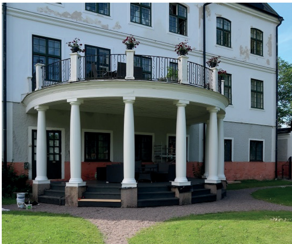
Figur 10. Balkongpelarna efter avslutade arbeten. Pelare nummer 1 till vänster. Foto: Ulrika Olsson, Länsmuseet Gävleborg, 2020-06-30.
