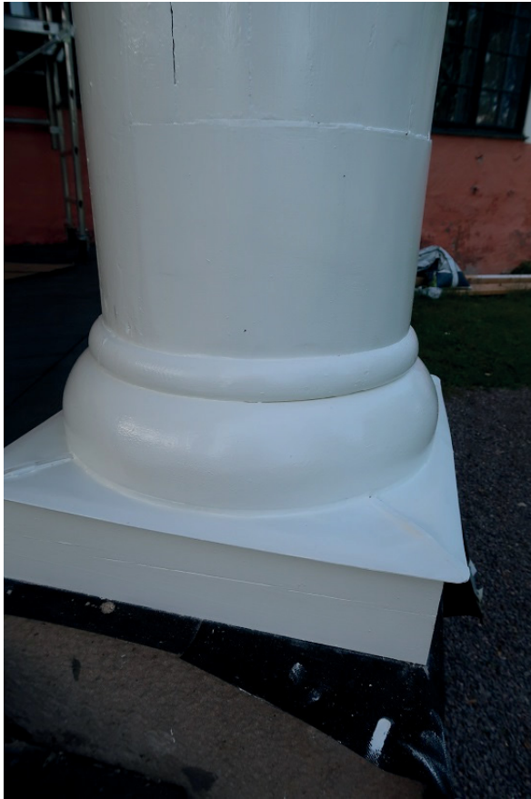
Figur 8. Pelare 6 efter avslutade arbeten. Panelen har lagats i med nytt virke cirka 2 dm. Rundande delar samt lådbas består av nytt virke. Foto: Ulrika Olsson, Läns museet Gävleborg. 2020-06-30.
