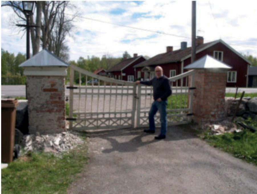
Figur 3. Foto från arbetet med renovering av grindstolparna 2019. Här har de två äldre grindarna provats mellan stolparna. Notera att stolparna inte är färdigställda med puts och listverk. Foto: Mimmi Göllas, MiGo:byggnadsvård, 2019-05-27.
