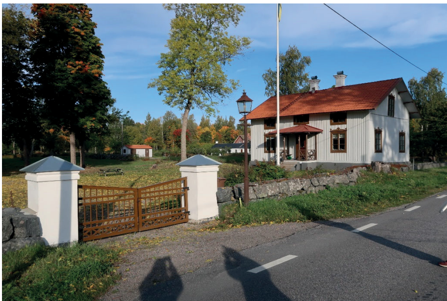
Figur 7. Renoverade grindstolpar 2019 och renoverade grindar 2020. Foto: Ulrika Olsson, Länsmuseet Gävleborg, 2020-09-25.
