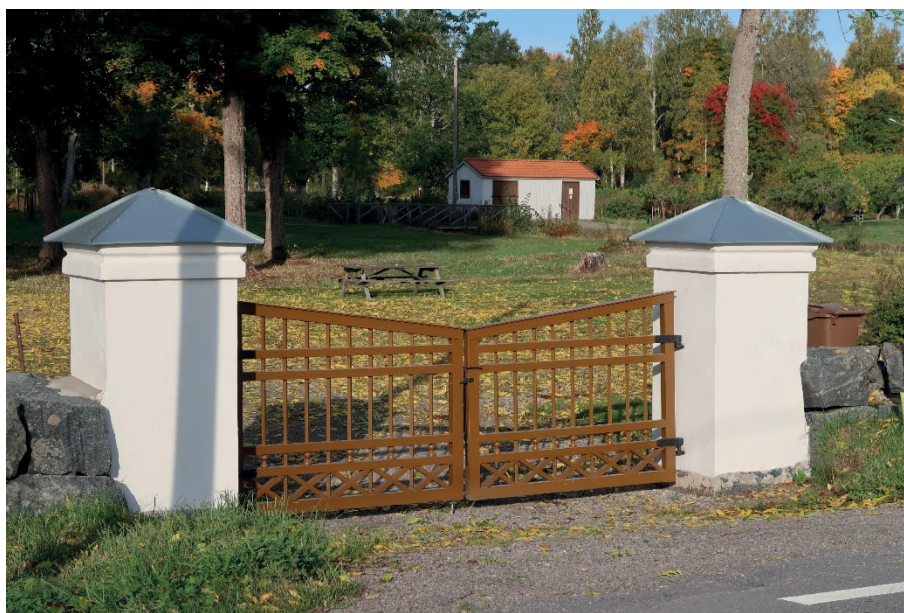
Figur 5. De färdiga grindarna vid slutbesiktningen. Foto: Ulrika Olsson, Länsmuseet Gävleborg, 2020-09-25.
