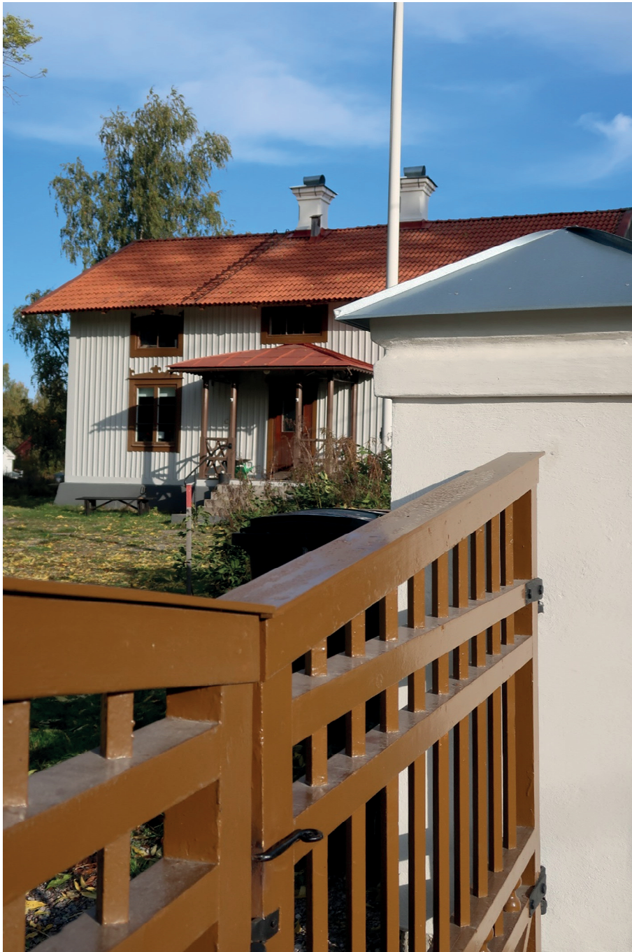
Figur 6. Grindarna är målade i samma kulör som fönsterfodren på kontoret. Foto: Ulrika Olsson, Läns museet Gävleborg, 2020-09-25.
