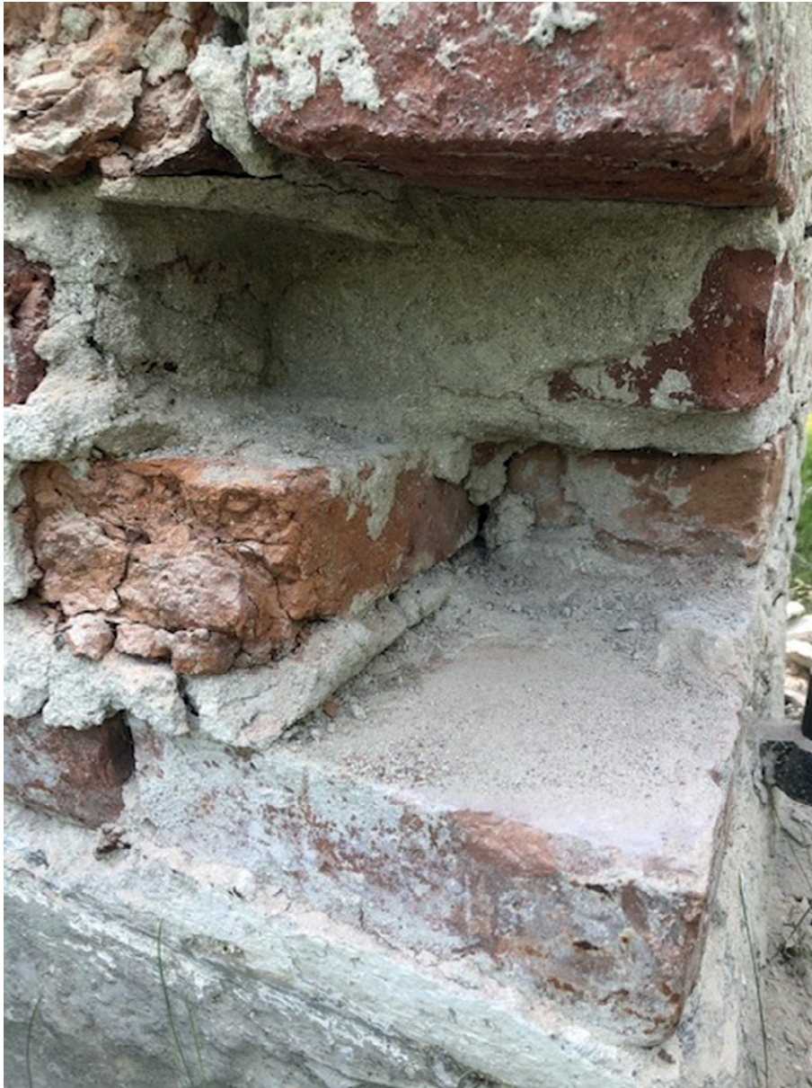
Figur 9. Den högra mittstolpen under arbetets gång. Stolpen har huggits ren på puts och lösa och skadade tegelstenar har tagits bort. Foto: Johan Berg, sommaren 2020.
