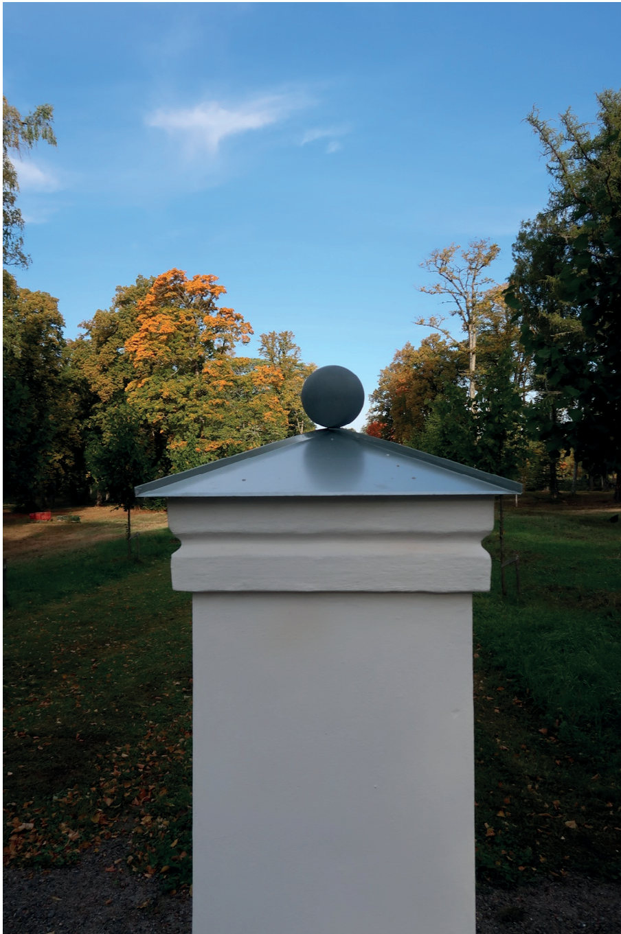
Figur 12. Det äldre odaterade fotografiet har använts som förlaga vid tillverkningen av huvarna och valet av kulornas storlek. Foto: Ulrika Olsson, Läns museet Gävleborg, 2020-09-25.
