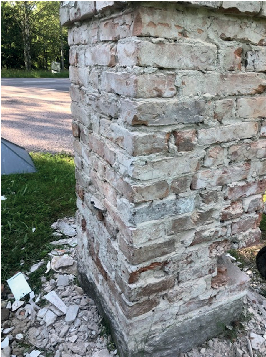
Figur 8. Den högra mittstolpen under arbetets gång. Stolpen har huggits ren på puts och lösa och skadade tegelstenar har tagits bort. Foto: Johan Berg, sommaren 2020.
