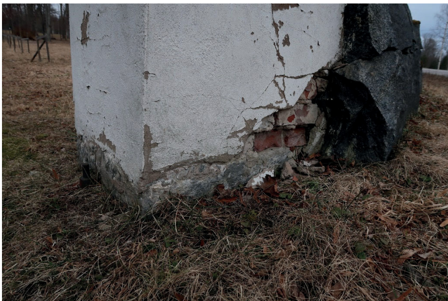
Figur 3. Marken har genom åren fyllts upp mot stolparnas socklar. Detta är den högra stolpen som är uppmurad i anslutning till muren som ramar in parken. Foto: Ulrika Olsson, Läns museet Gävleborg, 2020-03-31.
