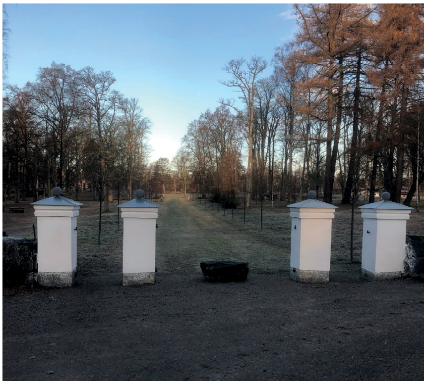
Figur 10. Arbetet med de fyra grindstolparna är färdigt. Foto: Johan Berg, JB CORE AB, 2020-11-10.
