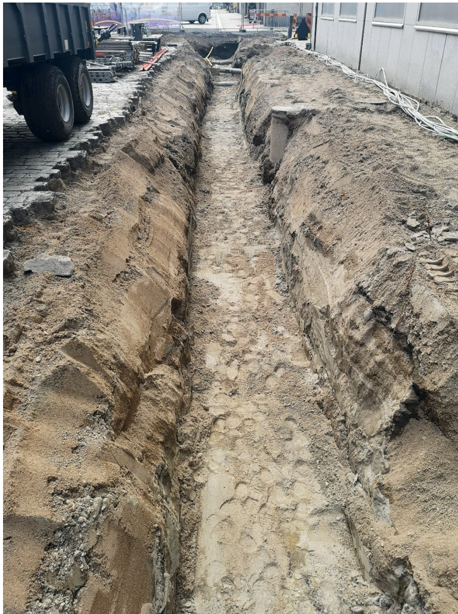
Figur 4. Detaljfoto över schakt 5 inom Drottninggatan, mot väst-sydväst. Foto: Frida Löjdström.
