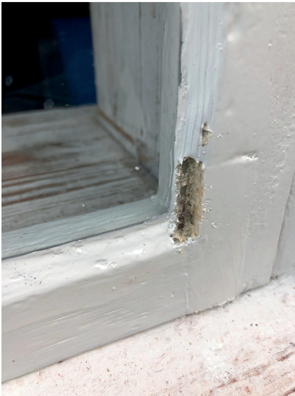
Figur 8. Exempel på skada på kittet orsakat av fåglar. Foto: Ulrika Olsson, Läns museet Gävleborg, 2020-11-05.
