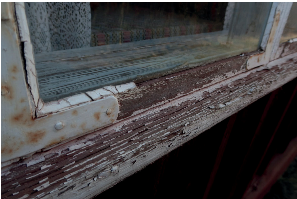
Figur 2. Exempel på fönster och omfattningars skick innan påbörjade arbeten. Foto: Ulrika Olsson, Länsmuseet Gävleborg, 2020-04-02.
