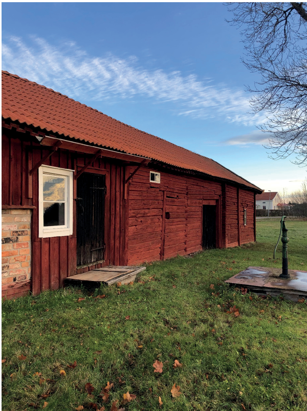
Figur 6. Fönster mot söder efter avslutade arbeten. Foto: Ulrika Olsson, Länsmuseet Gävleborg, 2020-11-05.
