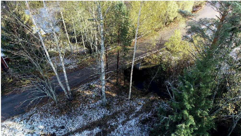
Figur 23. Centralt i bild är nuvarande väg. Nederst i bild är äldre vägbank och till höger vid granen är äldre brofäste L1950:4757. Foto: Anders Altnér.
