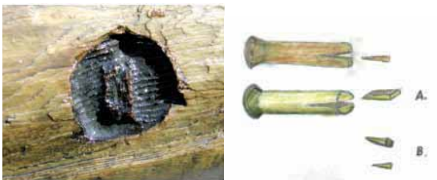
Bild 10a. Dymling med central kil genom ett av de dokumenterade spanten. Foto: Ulf Carneland. Bild 10b. Principskiss för kilning. Illustration: Harry Alopaeus, Läns museet Gävleborg.
