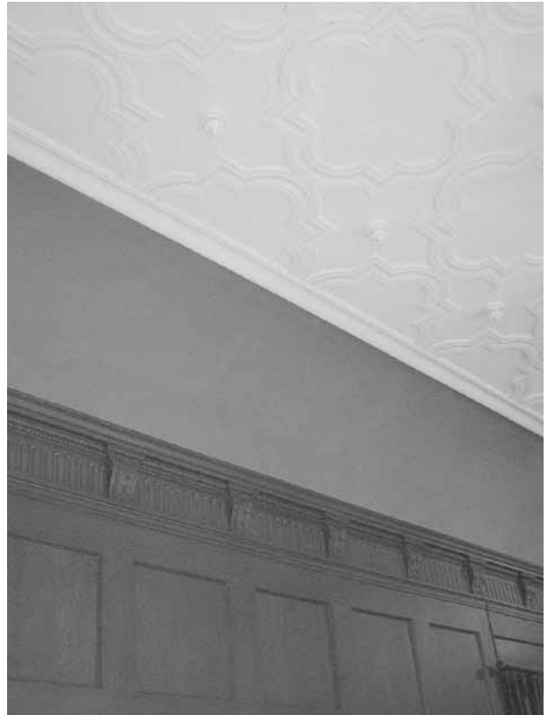
Detalj av väggpanel samt tak. Hallen, paradlägenheten, 1 trappa upp.
