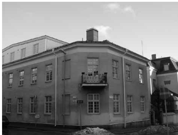
Ekonomibyggnad från nordväst.
