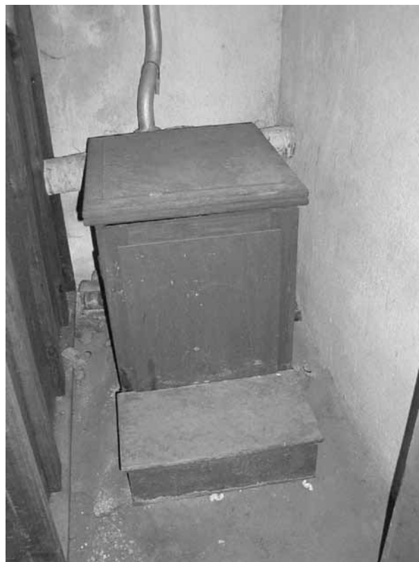
Torrklosett i källarvåningen.
