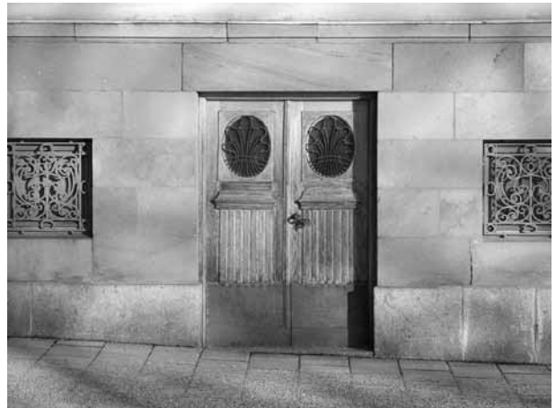
Huvudbyggnaden, fönster samt källardörr.
