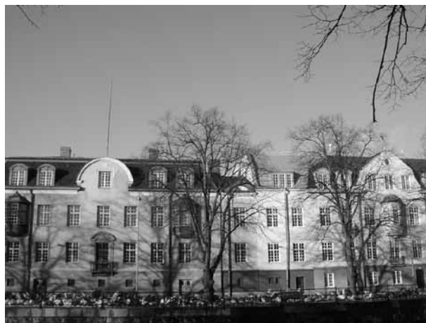
Riksdrotsen 1 och 2, södra fasaderna.
