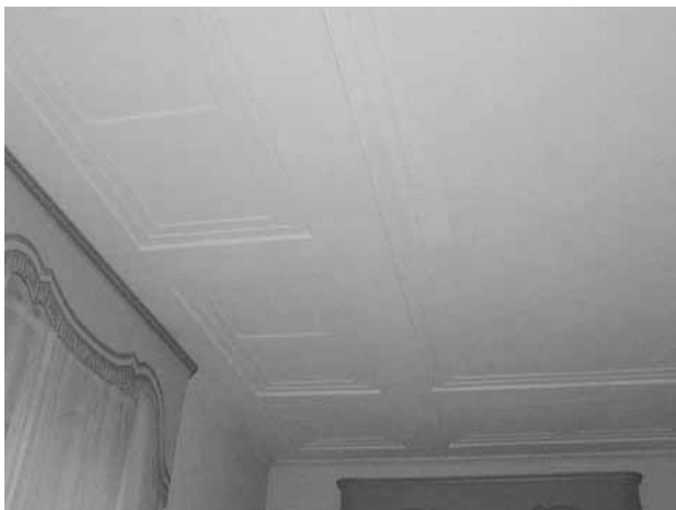
Taket i biljardrummet, f.d. paradjägenheten, bottenvåningen.
