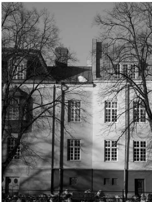
Detaljbild av fasadövergången. Riksdrotsen 1 och 2.
