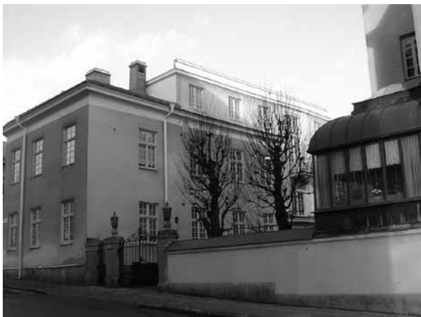
Ekonomibyggnaden från sydväst.
