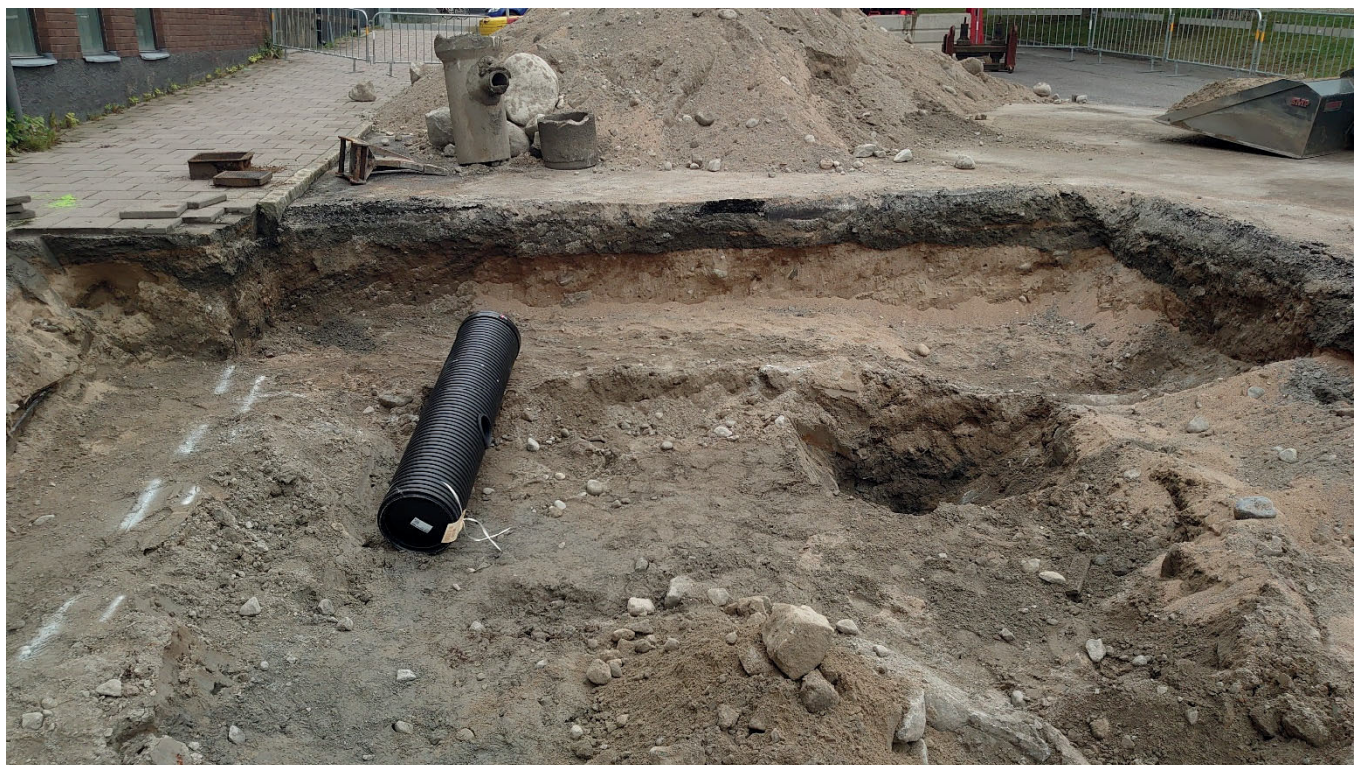
Figur 10. Översiktsbild över schaktet mot sydväst. Visar endast utfyllnadslager. Foto: Anders Altner
