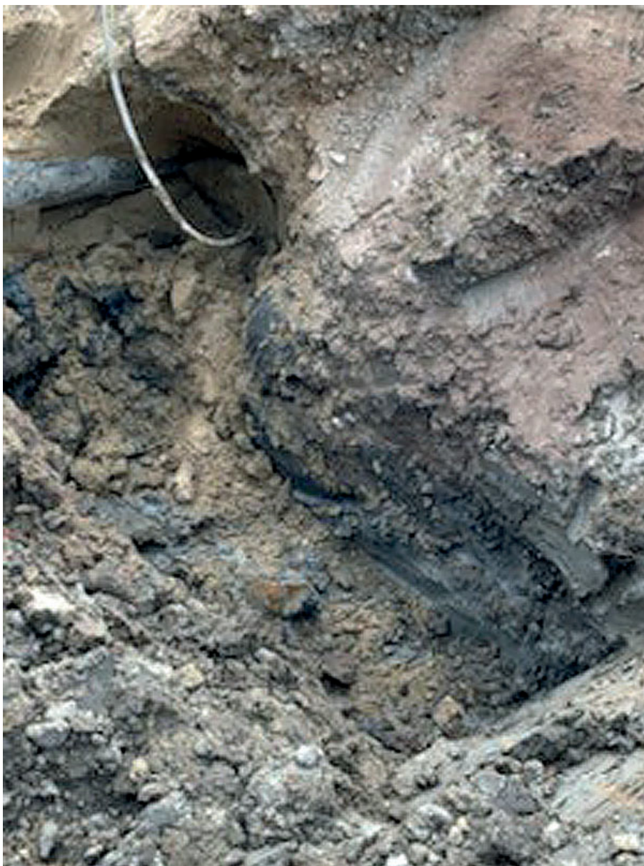
Figur 4. Detaljfoto över schaktets djupare del. Visar ledningsdragning, utfyllnadslager och den naturligt förekommande moränen. Foto: Agneta Svensson, Söderhamns kommun.
