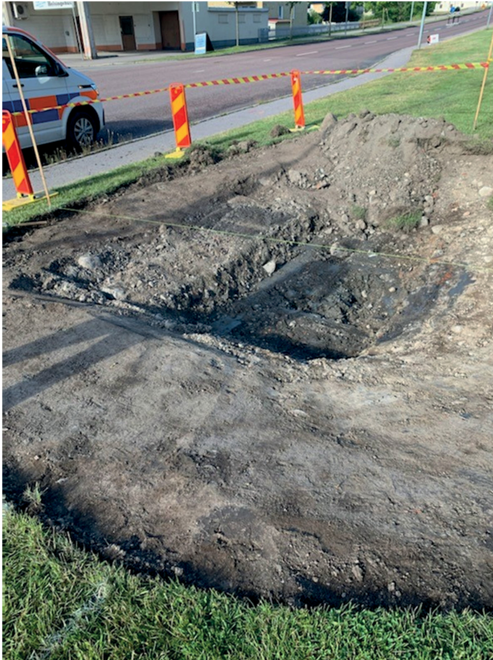
Figur 10. Arbetsbild över schaktningsarbetet vid Brädgårdsgatan. Foto: Agneta Svensson, Söderhamns kommun.
