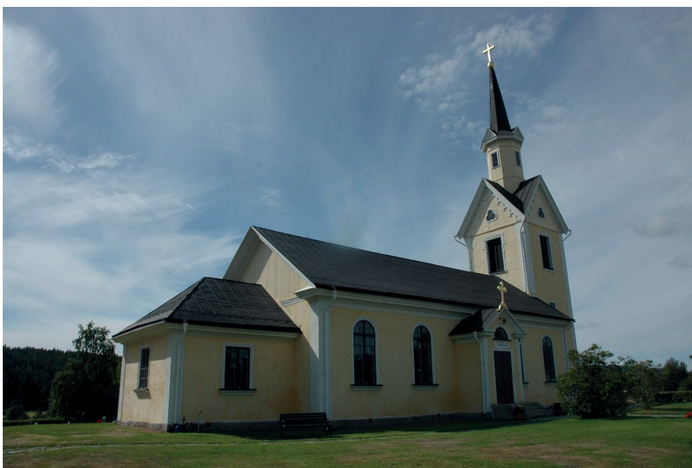
Figur 6. Kyrkan från nordöst innan renoveringen inleddes. Foto: Daniel Olsson, Läns museet 2018-08-14.
