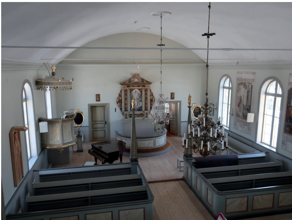
Figur 13. Kyrkorummet sett från läktaren efter slutförd installation av två nya dragstag. Foto från nordväst. Foto. Daniel Olsson, Länsmuseet Gävleborg 2019-04-15.
