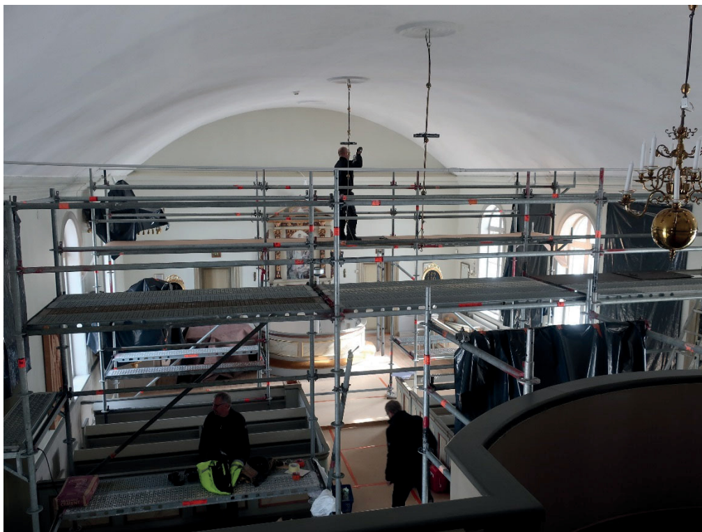
Figur 10. Kyrkorummet sett från läktarens norra del efter skyddstäckning av golv och inventarier samt uppsättning av byggnadsställningar. Foto: Daniel Olsson, Länsmuseet Gävleborg 2019-04-05.
