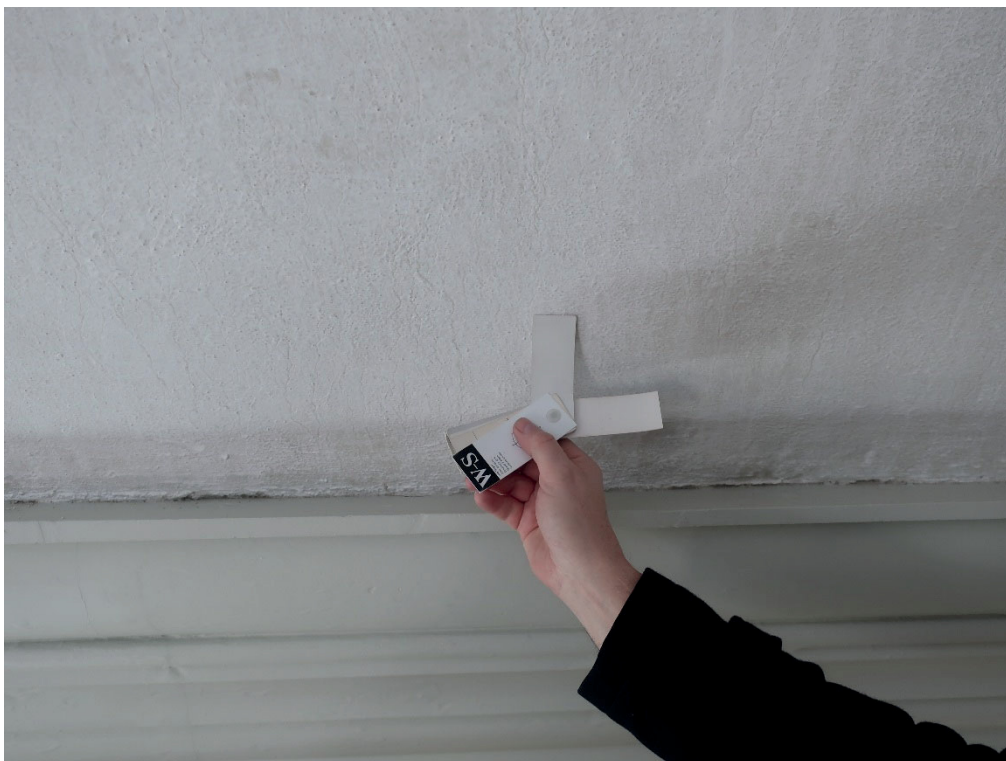
Figur 11. Jämförelse mellan den av Per Mattsson framtagna kulören på det vertikalt placerade NCS-bladet och valvets färgsättning. Foto: Daniel Olsson, Länsmuseet Gävleborg 2019-03-06.
