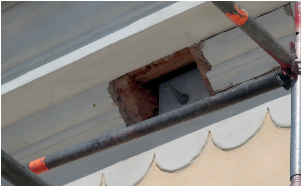
Figur 8. Detalj av håltagning i den södra fasaden för att möjliggöra dragning av dragstag vid kor. Foto från sydöst. Foto: Daniel Olsson, Läns museet Gävleborg 2019-04-02.
