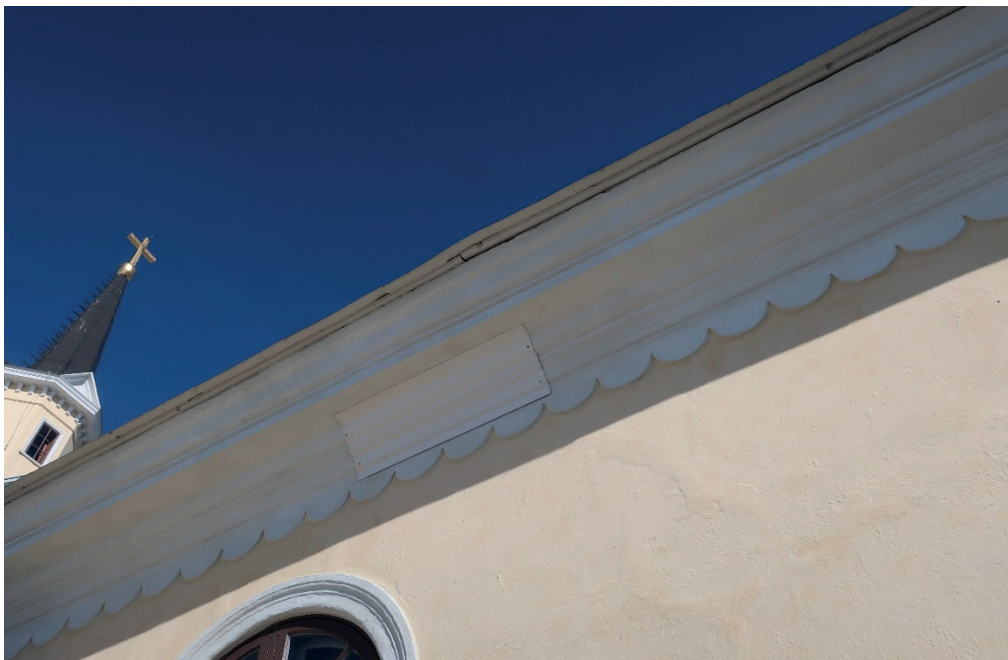
Figur 9. Håltagningen i den södra fasadens takfot dold med en vitmålad plåt med samma profilering som takfoten. Foto: Daniel Olsson, Läns museet Gävleborg 2019-04-15.
