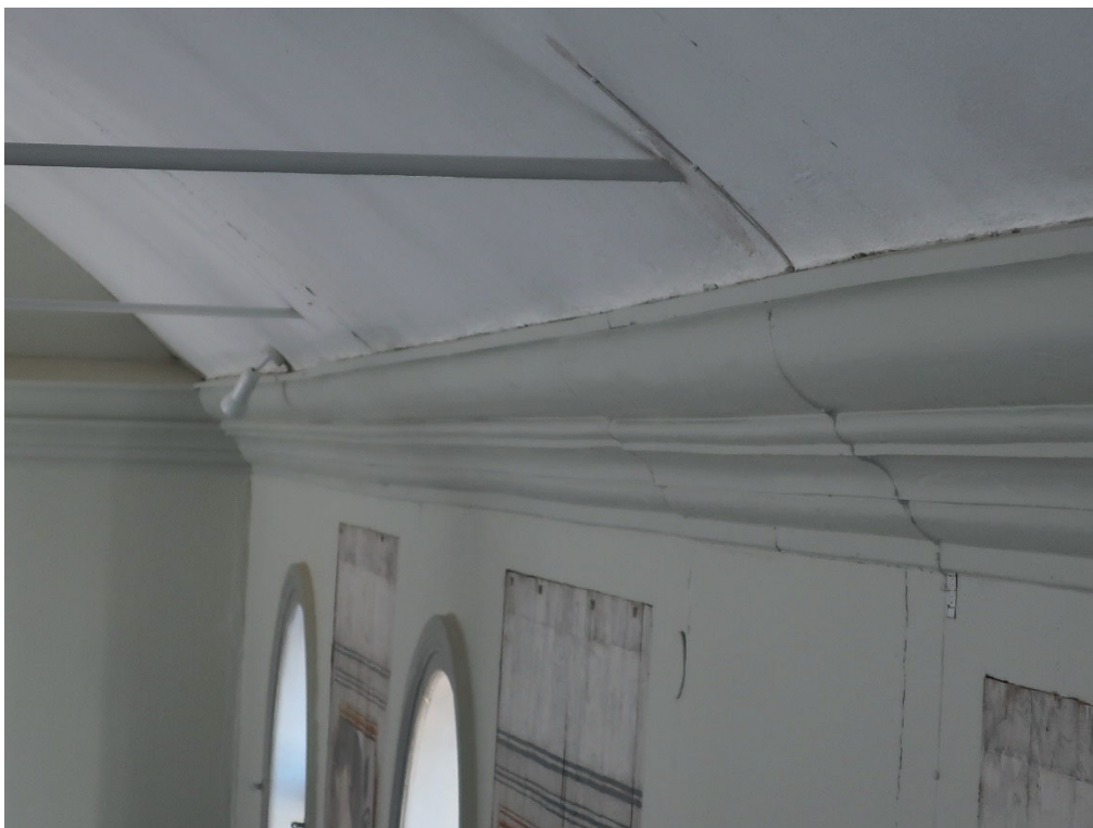
Figur 12. Detalj av de båda nya dragstagens infästningar i valvet. Foto från nordväst. Foto: Daniel Olsson, Länsmuseet Gävleborg 2019-04-15.
