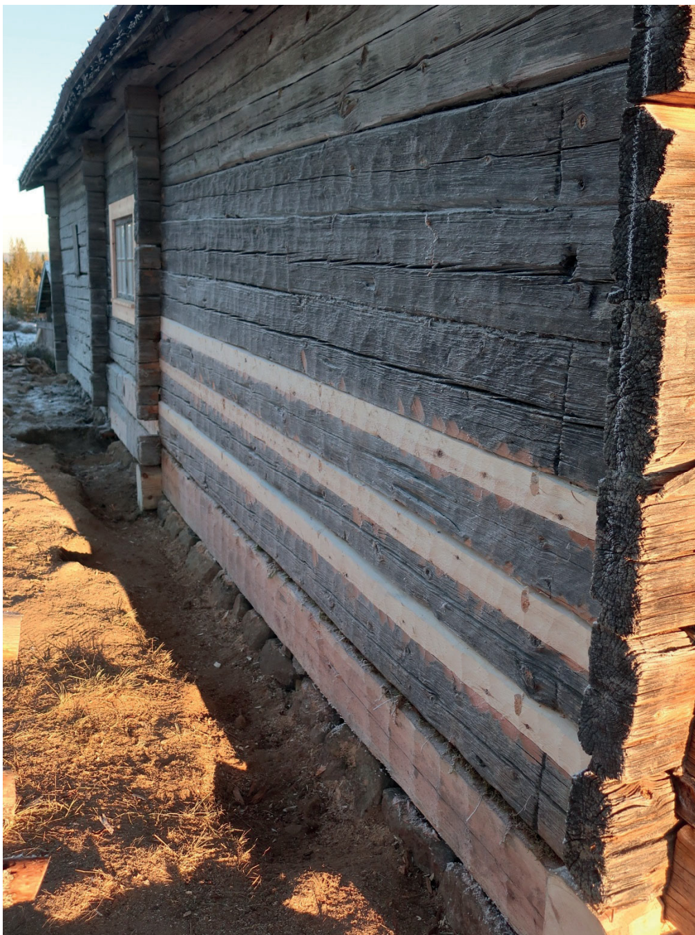
Figur 18. Vallstugans nordvästra fasad – sida C – efter avslutad renovering av timmervägg samt sänkning av mark. Foto från väster. Foto: Daniel Olsson, Länsmuseet Gävleborg 2018-11-23.
