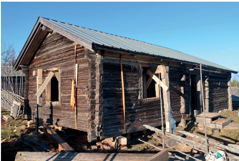
Figur 12. Vallstugan från söder under pågående renovering. Byggnadens sydvästra del har lyfts och de skadade understa stockarna har plockats bort. Foto: Daniel Olsson, Länsmuseet Gävleborg 2018-10-26.
