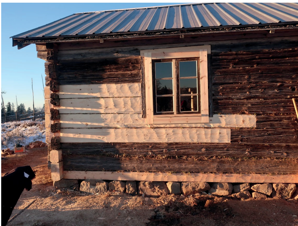
Figur 14. Den sydvästra delen av den sydöstra fasaden efter timmerbyten och fönsterrenovering. Foto: Daniel Olsson, Länsmuseet Gävleborg 2018-11-23.
