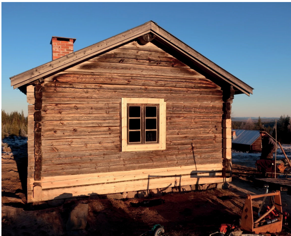
Figur 16. Fasaden mot sydväst efter timmerbyten och fönsterrenovering. Foto: Daniel Olsson, Länsmuseet Gävleborg 2018-11-23.
