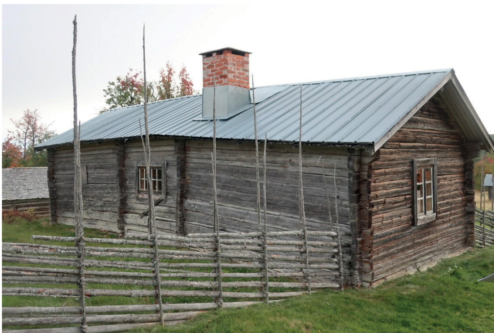
Figur 5. Vallstugan från väster innan renoveringen. Foto: Daniel Olsson, Länsmuseum Gävleborg 2018-09-25.
