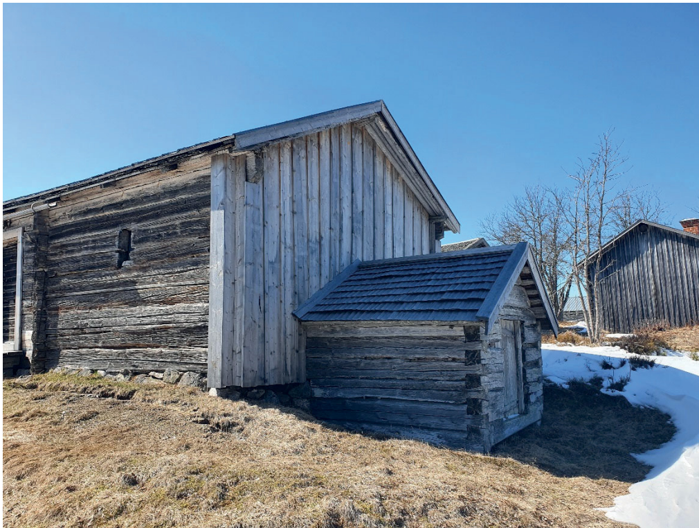
Figur 23. Vallstugans nordöstra gavel från öster med ny panel och nya knutlådor samt nytt spåntak på källarsvalen. Foto: Daniel Åkerman, Gamla Trähus 2021-04-26.
