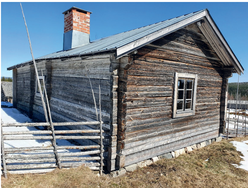
Figur 26. Vallstugan från väster efter att det utbytta timret och virket fått gråna naturligt. Foto: Daniel Åkerman, Gamla Trähus 2021-04-26.
