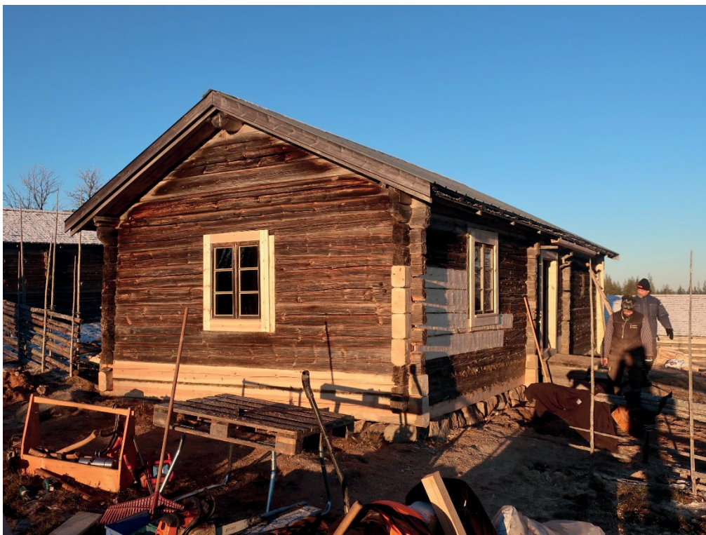
Figur 24. Vallstugan från söder vid slutbesiktningen. Foto: Daniel Olsson, Länsmuseet Gävleborg 2018-11-23.
