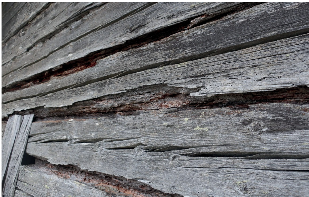
Figur10. Detalj av horisontella skador i vallstugans nordöstra timmervägg. Foto från norr. Foto: Daniel Olsson, Läns museet Gävleborg 2018-09-25.
