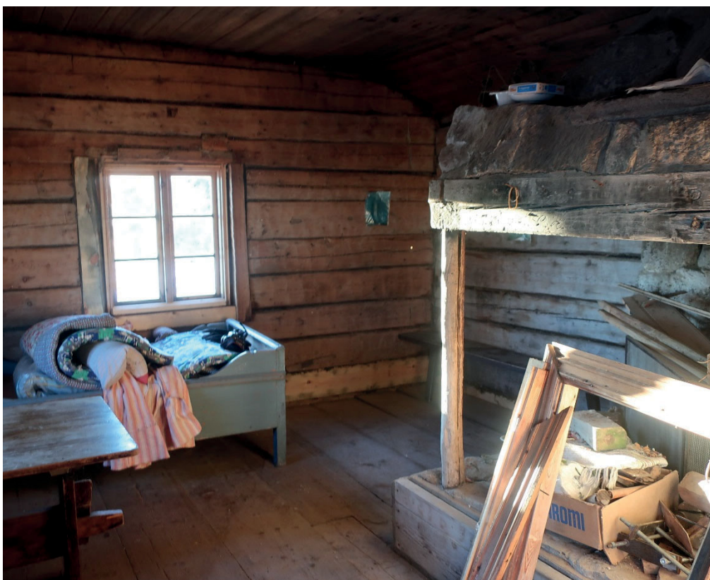
Figur 17. Vallstugans stora stuga från öster efter avslutad renovering och återställning av golv. Foto: Daniel Olsson, Länsmuseet Gävleborg 2018-11-23.
