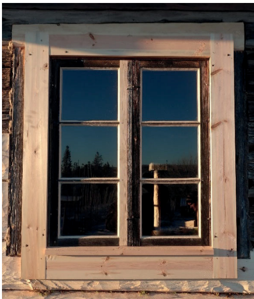
Figur 21. Detalj av fönstret mot sydöst efter renovering. Foto: Daniel Olsson, Läns museet Gävleborg 2018-11-23.
