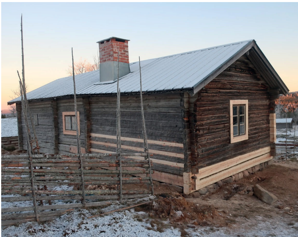
Figur 25. Vallstugan från väster vid slutbesiktningen. Foto: Daniel Olsson, Länsmuseet Gävleborg 2018-11-23.
