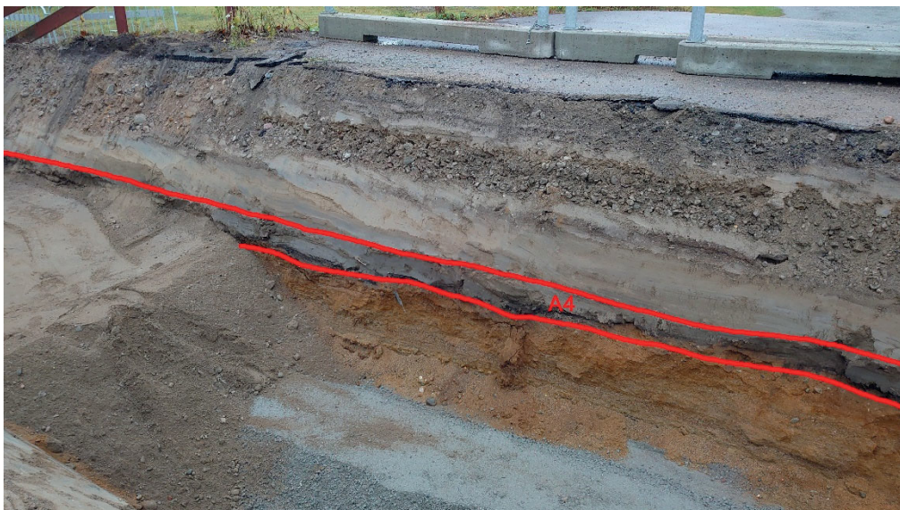
Figur 6. Detaljbild av schaktet OS1 i Valbovägen, samt äldre markhorisont A4. I överkant ligger utfyllnadslager A3 och bärlager A4. Foto: Anders Altner, mot öster.
