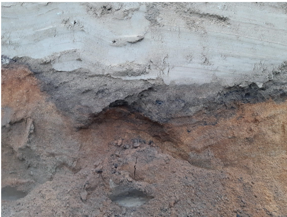
Figur 14. Schaktet OSI i Valbovägen med nedgrävning/stenspar? A6, på motsatt sida av nedgrävning A5. Foto: Anders Altnér, mot norr.
