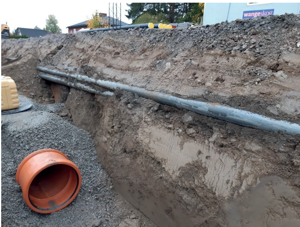
Figur 15. Schaktet OSI i Valbovägen med nedgrävning A5 under ledningarna. Foto: Anders Altnér, mot sydöst.
