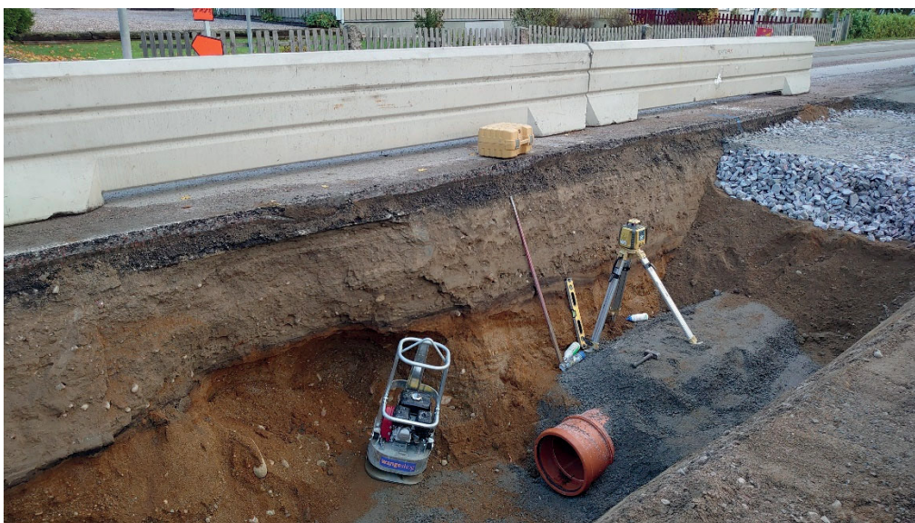
Figur 11. Schaktet OS1 i Valbovägen, antydan till äldre markhorisont A4. Foto: Anders Altner, mot nordöst.
