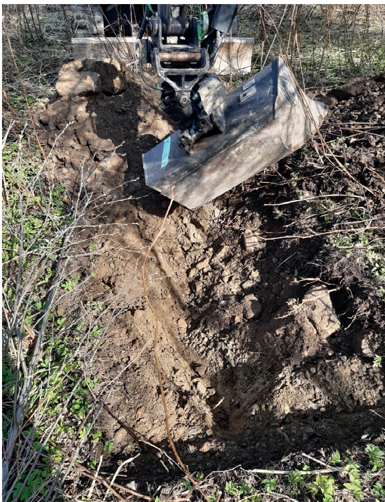
Figur 8. Vissa schakt kunde ej grävas till botten på grund av stora massor av bland annat asfalt.
