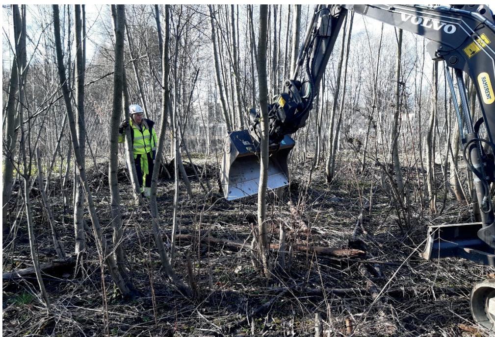
Figur 4. Arbetsbild från yta 2. Schakten varierade i storlek och täthet beroende på bland annat vegetationen. Foto från nordost av Frida Löjdström.
