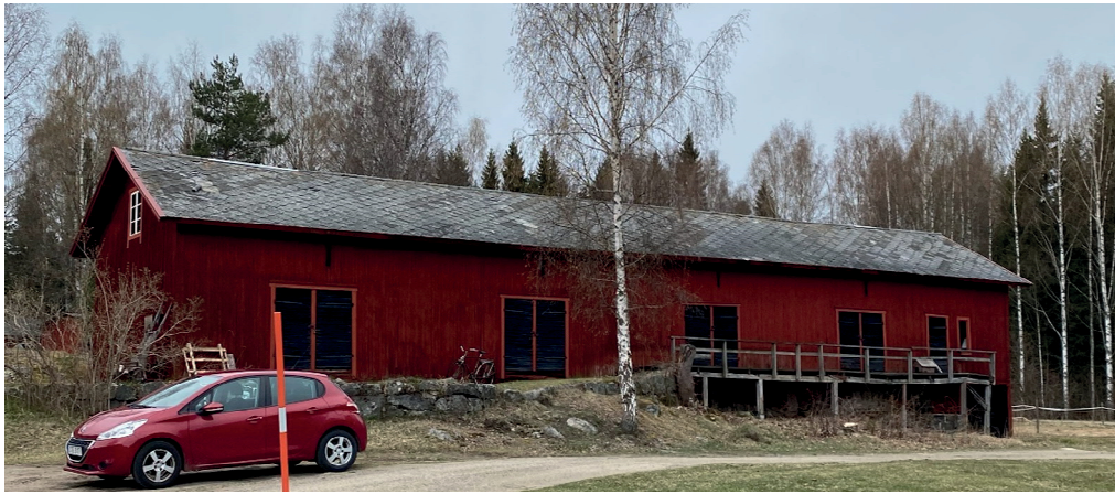
Figur 3. Den västra förrådslängan innan påbörjade arbeten. Foto: Ulrika Olsson, Länsmuseum Gävleborg, 2021-04-27.
