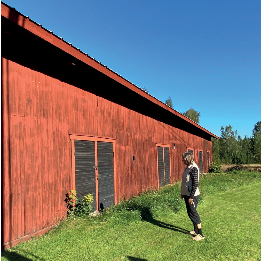
Figur 10. Den östra längans östra sida. Vid portarna närmast i bild har längan lyfts. Foto: Ulrika Olsson, Länsmuseet Gävleborg, 2021-08-31.
