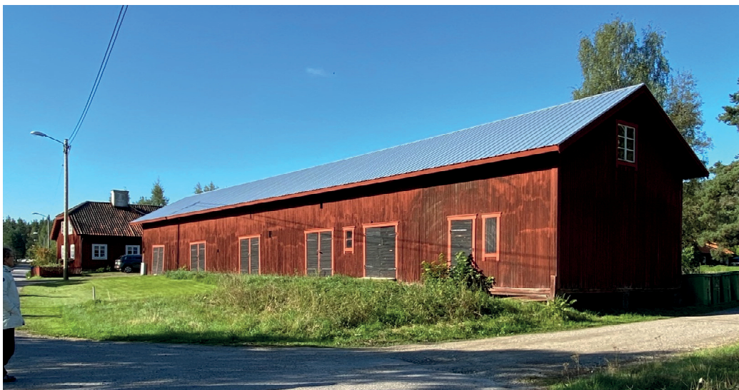
Figur 8. Den östra längan efter avslutade arbeten. Foto: Ulrika Olsson, Länsmuseet Gävleborg, 2021-08-31.
