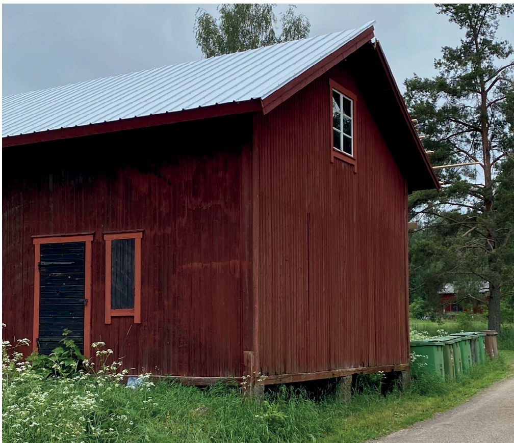
Figur 6. Under pågående arbeten med takbytet på den östra förrådslängan. På den östra sidan har plåten, inklusive vindskivor och vindskiveplåt monterats. Foto: Ulrika Olsson, Läns museet Gävleborg, 2021-06-23.
