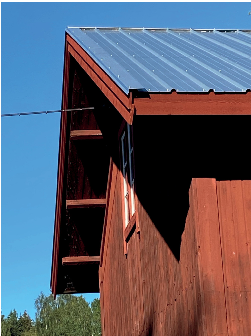
Figur 7. Närbild på gavelavslut med vindskivor, vindskiveplåt i aluzink samt takfotsbräda. Foto: Ulrika Olsson, Läns museet Gävleborg, 2021-08-31.
