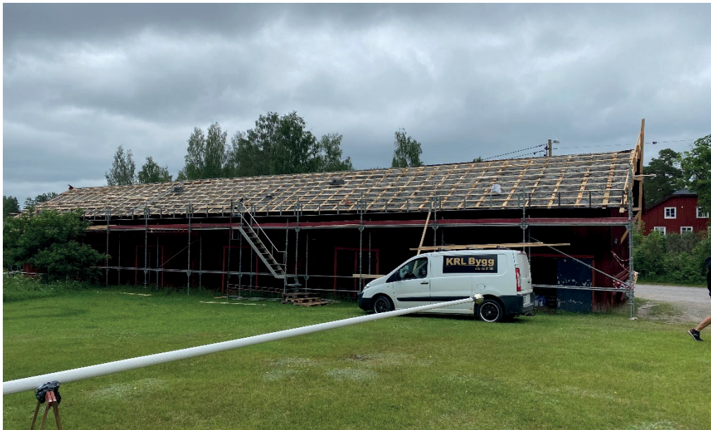
Figur 5. Under pågående arbeten med takbytet på den östra förrådslängan. Läkt har lagts på hela det västra takfallet. Genom klossning/shimsning har taket riktats upp inför montering av pannplåten. Foto: Ulrika Olsson, Länsmuseet Gävleborg, 2021-06-23.
