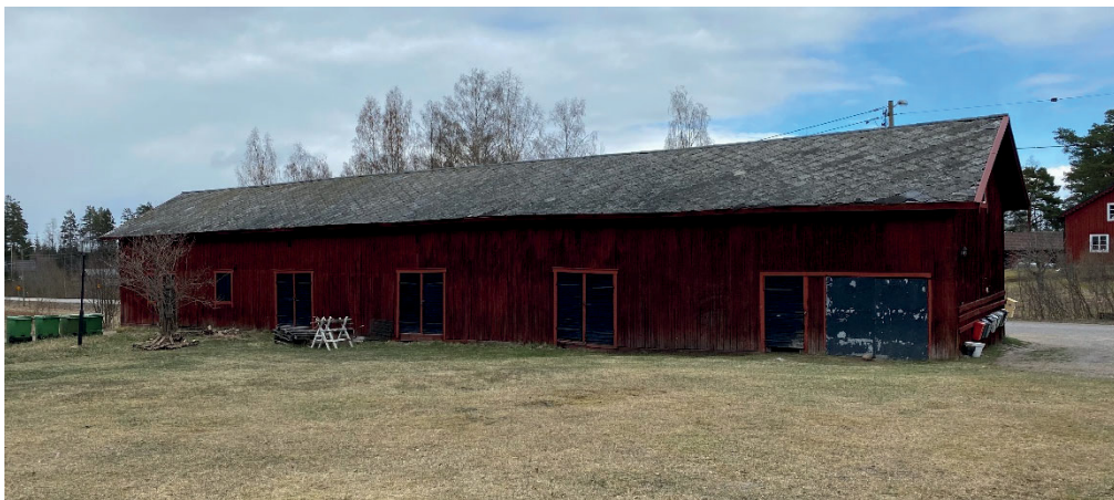
Figur 2. Den östra förrådslängan innan påbörjade arbeten. Foto: Ulrika Olsson, Läns museet Gävleborg, 2021-04-27.
