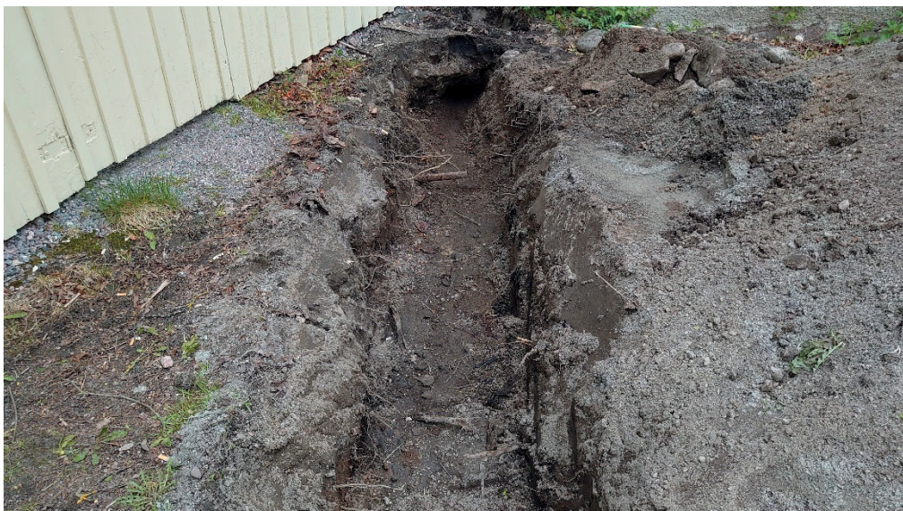
Figur 19. Foto över anslutningsschakt i grönyta vid korsningen Kyrkogatan och Lilla Vattugränd. Foto: mot sydväst av Anders Altner.
