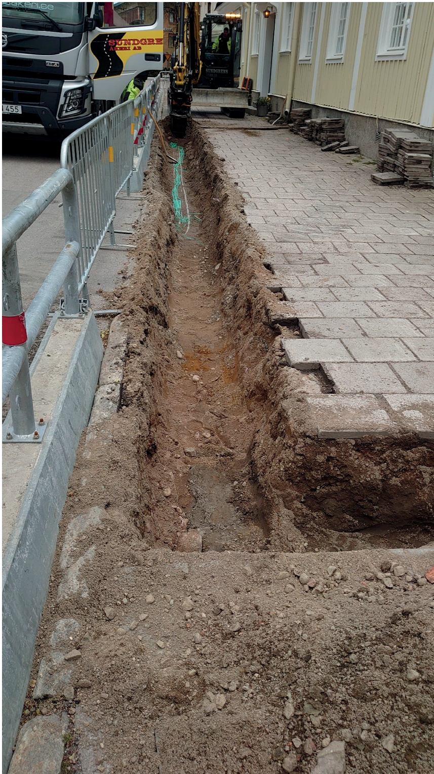
Figur 14. Schaktet i Kyrkogatan. Foto: mot östnordöst av Anders Altnér.
