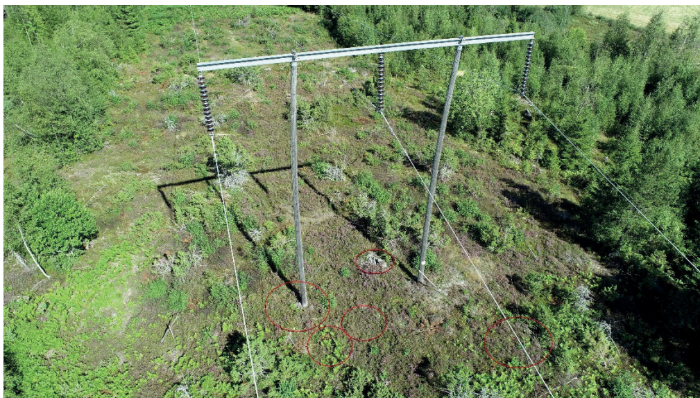
Figur 8. Undersökningsområdet före avbaning. Anläggningarna markerade med röd cirkel. Foto: Maria Björck, från sydsydväst. Spridningstillstånd LM2121/028211.
