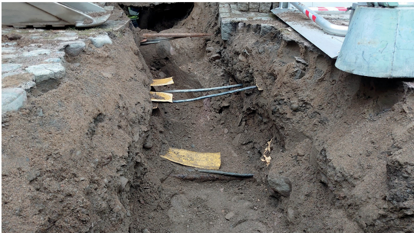
Figur 12. Detaljfoto av schaktet mot huskroppen. Foto: mot syd, av Anders Altner.
