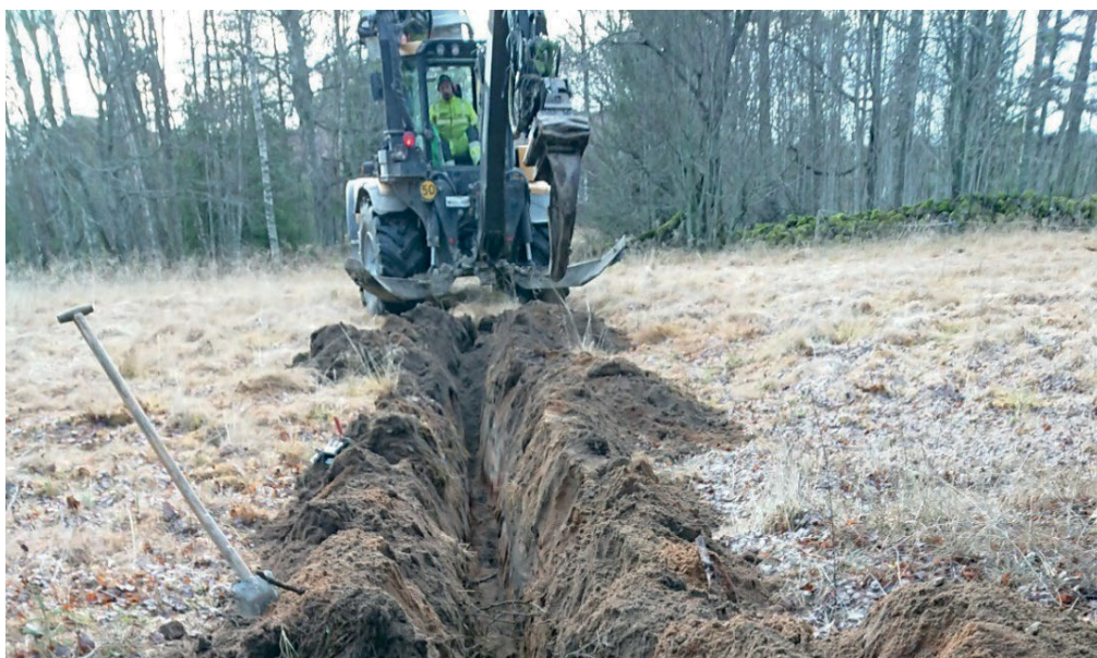
Figur 2. Pågående schaktning i Hälsingtuna socken. Schakten var i snitt bara 0,7 meter breda, vilket försvårade sikten. Foto: Inga Blennå.
