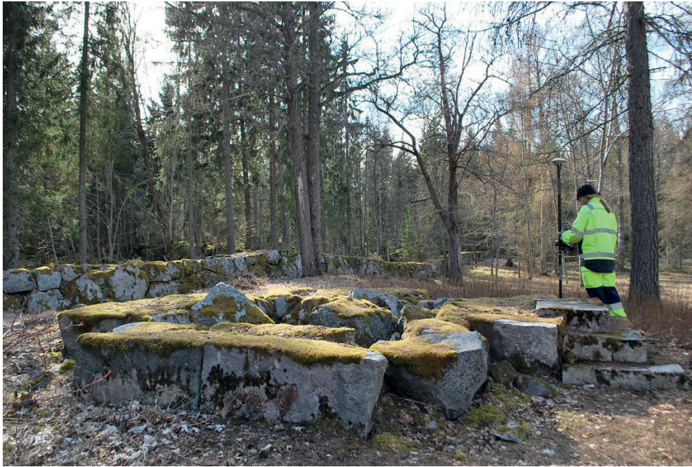
Figur 8. I södra delen av parken finns grunden till utsiktstornet bevarad (4152), som Inga Blennå mäter in. Grunden är kallmurad med tre trappsteg mot norr, till höger i bild. I bakgrunden syns muren som omger parken och trädgårdarna. Foto: Karin Lindeblad, Arkeologerna.
