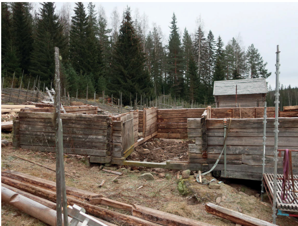
Figur 14. Byggnadens norra del från nordväst efter demontering av timmerstommens övre del. Foto: Daniel Olsson 2019-11-06.
