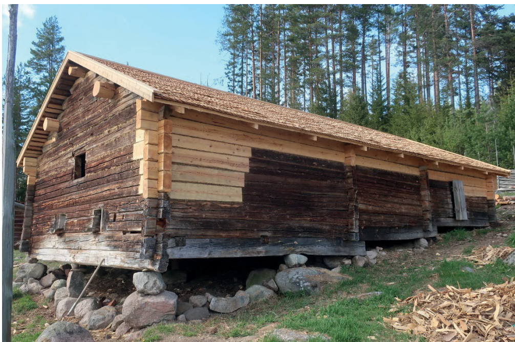
Figur 21. Fäxet från söder efter avslutad renovering. Foto: Daniel Olsson 2020-05-28.
