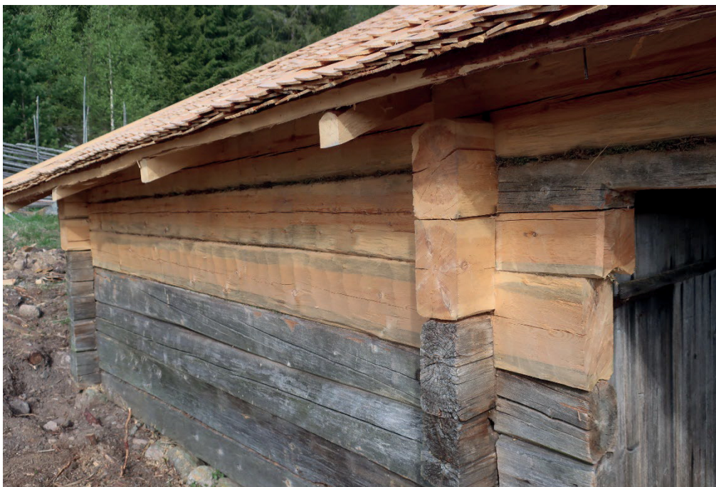
Figur 22. Detalj av timmerbyten i fäxets nordvästra fasad. Foto: Daniel Olsson 2020-05-28.
