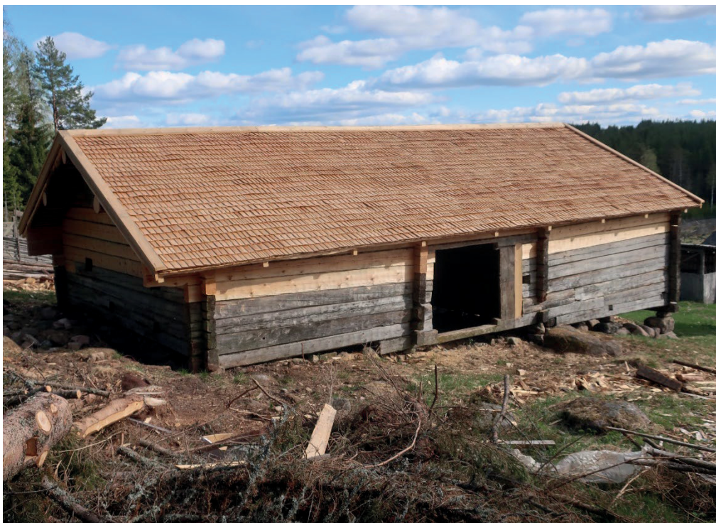
Figur 20. Fäxet från norr efter avslutad renovering. Foto: Daniel Olsson 2020-05-28.
