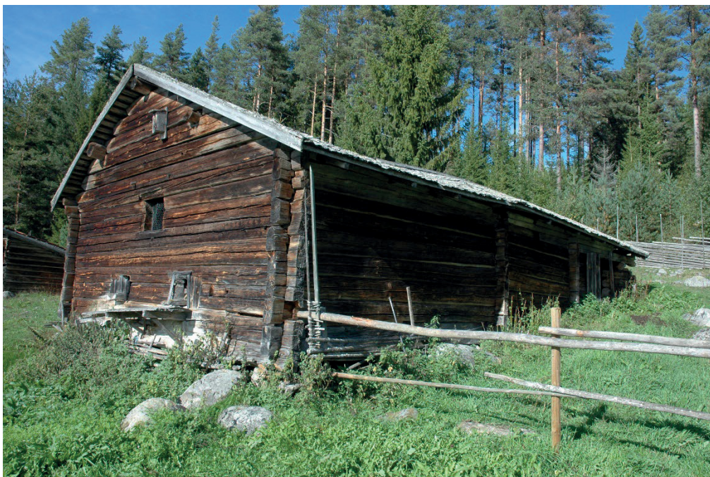
Figur 9. Fäxet från söder med utåtlutande gavelröste på den sydvästra gaveln. Foto: Daniel Olsson 2018-09-06.
