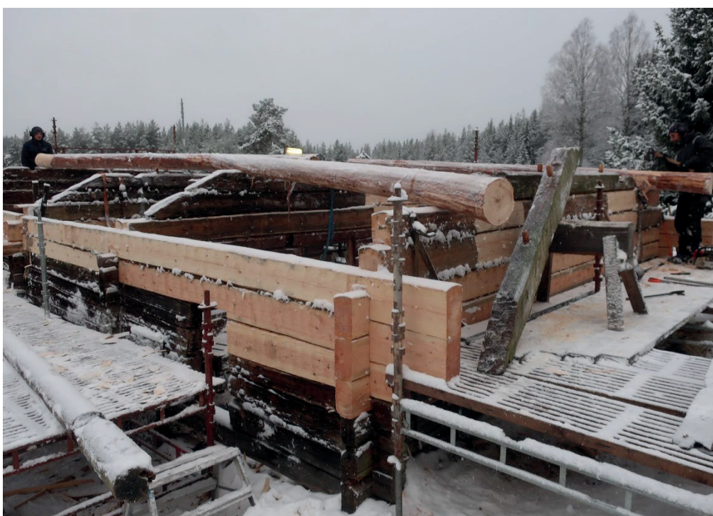
Figur 18. Uppsättning av nya sidoåsar vid upptimring av timmerstommen. Foto från öster. Foto: Daniel Olsson 2019-11-27.
