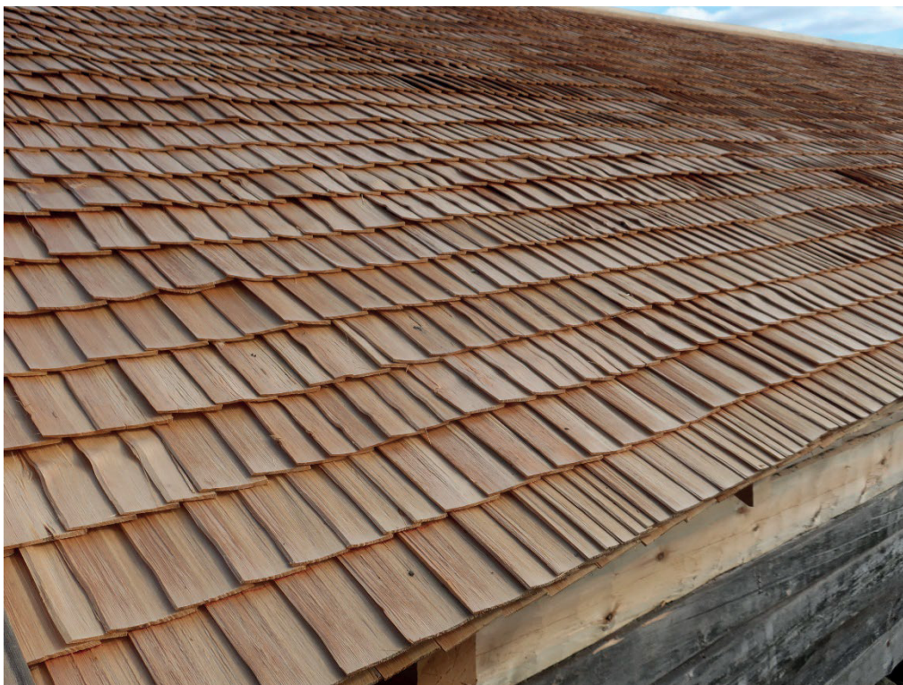
Figur 19. Detalj av takfallet mot nordväst efter omläggning med nykluvna takspån. Foto: Daniel Olsson 2020-05-28.
