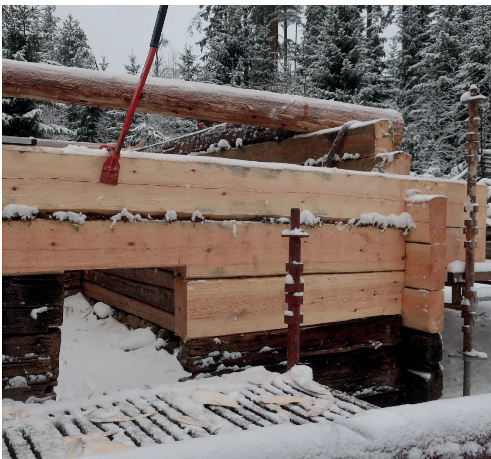
Figur 16. Detalj av byggnadens sydöstra vägg från söder. Jämför med figur 8 som är tagen ur samma vinkel. Foto: Daniel Olsson 2019-11-27.
