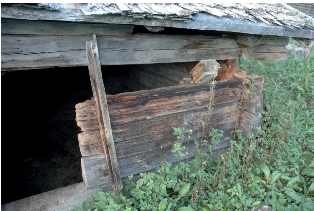
Figur 8. Detalj av den sydöstra fasadens norra del med inrasad stock och mycket vegetation kring byggnaden. Foto: Daniel Olsson 2018-09-06.
