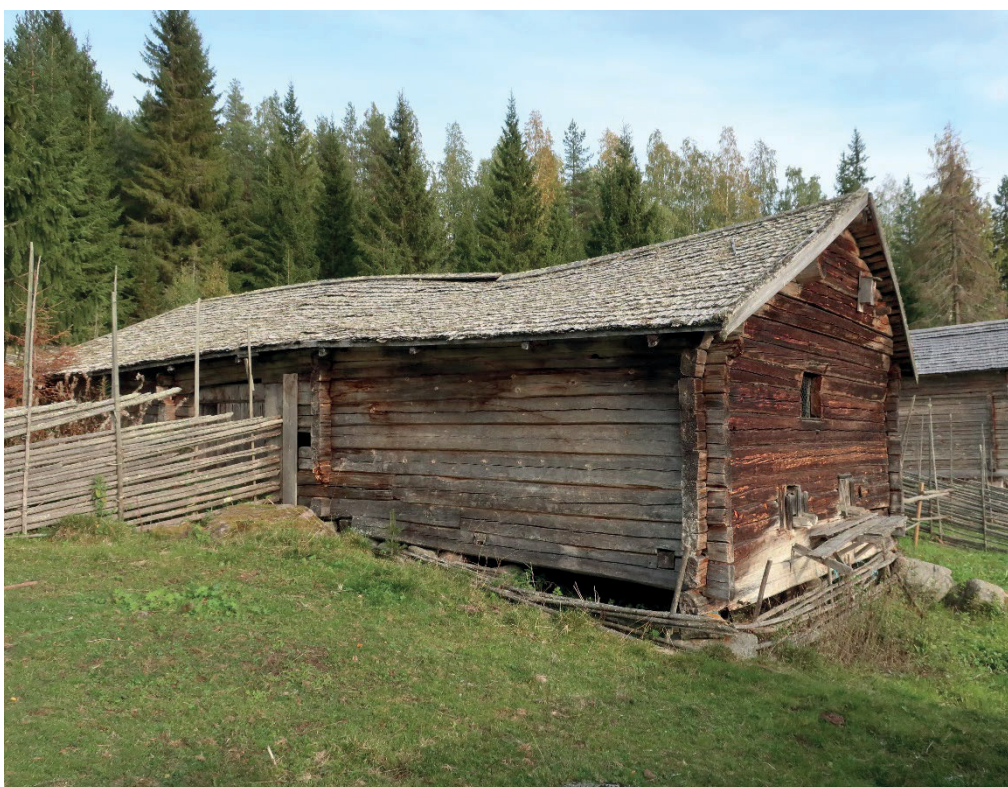
Figur 6. Fäxet från väster innan renoveringen. Foto: Daniel Olsson 2018-09-06.
