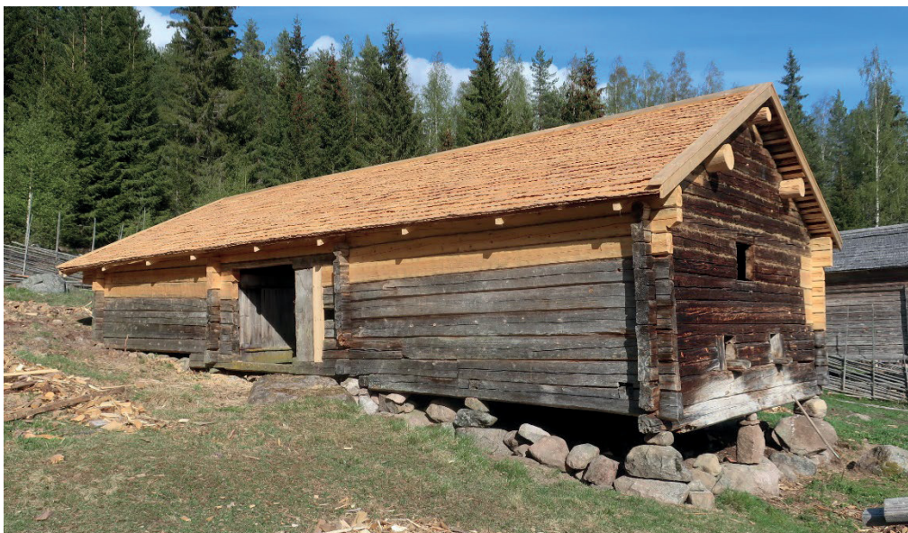
Figur 24. Fäxet från väster efter avslutad renovering. Foto: Daniel Olsson 2020-05-28.
