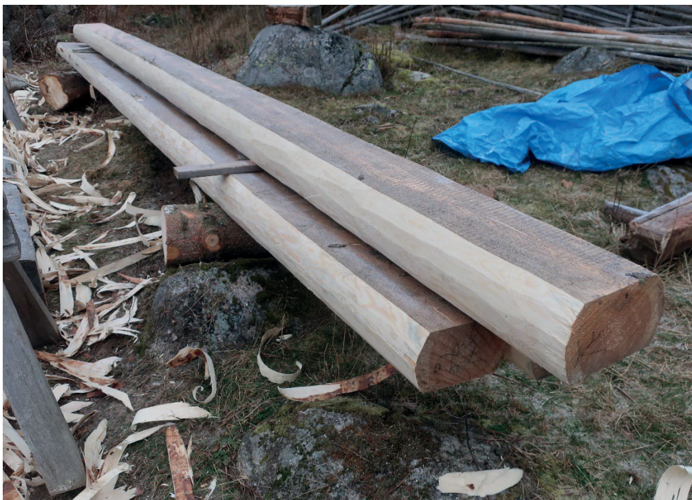
Figur 13. Tillverkning av nya stockar till fäxet. Foto: Daniel Olsson 2019-11-06.
