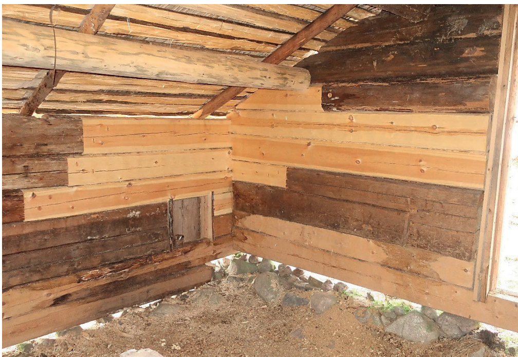
Figur 13. Stallets norra hörn från söder efter timmerlagningar i vägg C och D. Foto: Daniel Olsson 2020-10-19.
