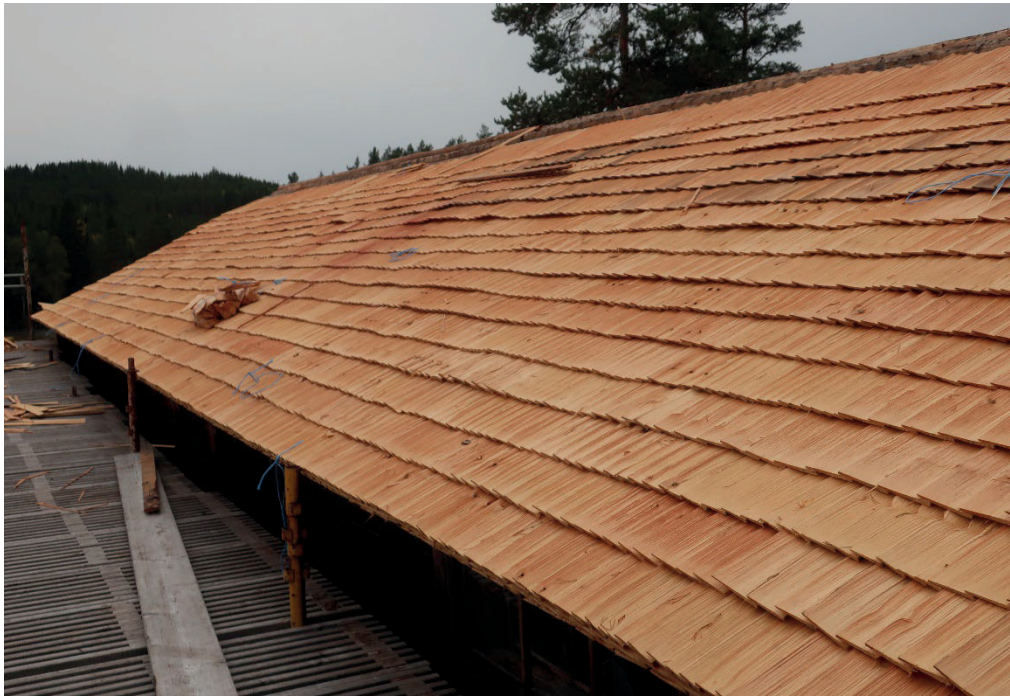
Figur 20. Spåntaket på takfallet mot sydöst under pågående läggning. Foto: Daniel Olsson 2020-09-21.
