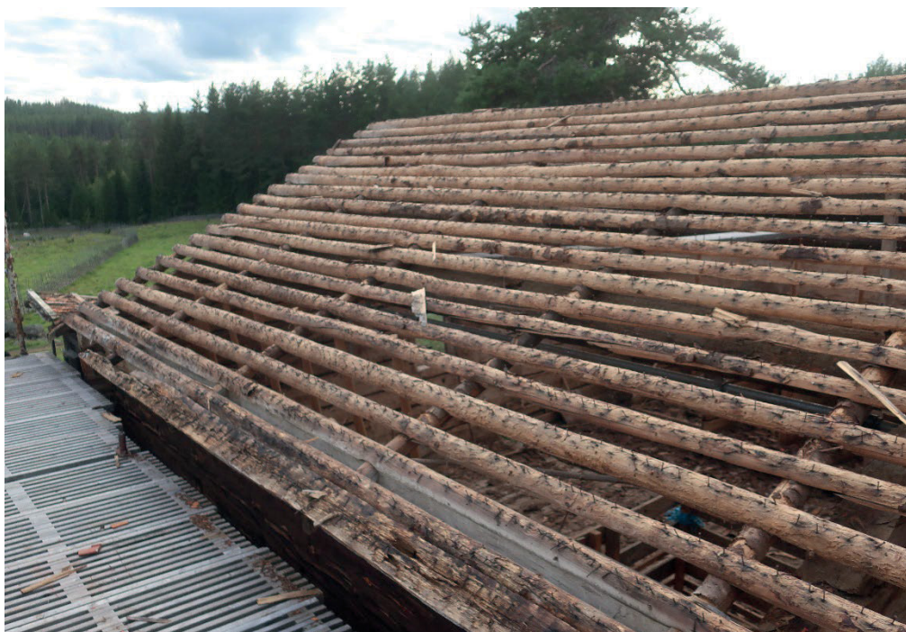
Figur 19. De äldre sparrarna och trovirket på takfallet mot sydöst efter demontering av spåntaket. Foto: Daniel Olsson 2020-08-28.
