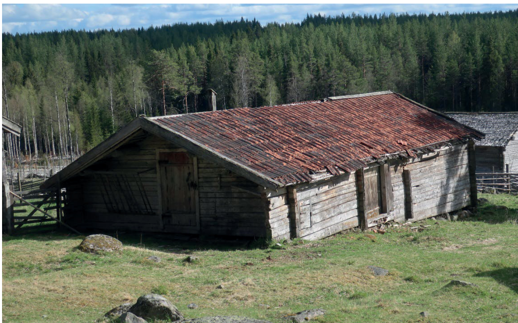
Figur 8. Fäxbyggnaden från norr innan reoveringen. Foto: Daniel Olsson 2020-05-28.
