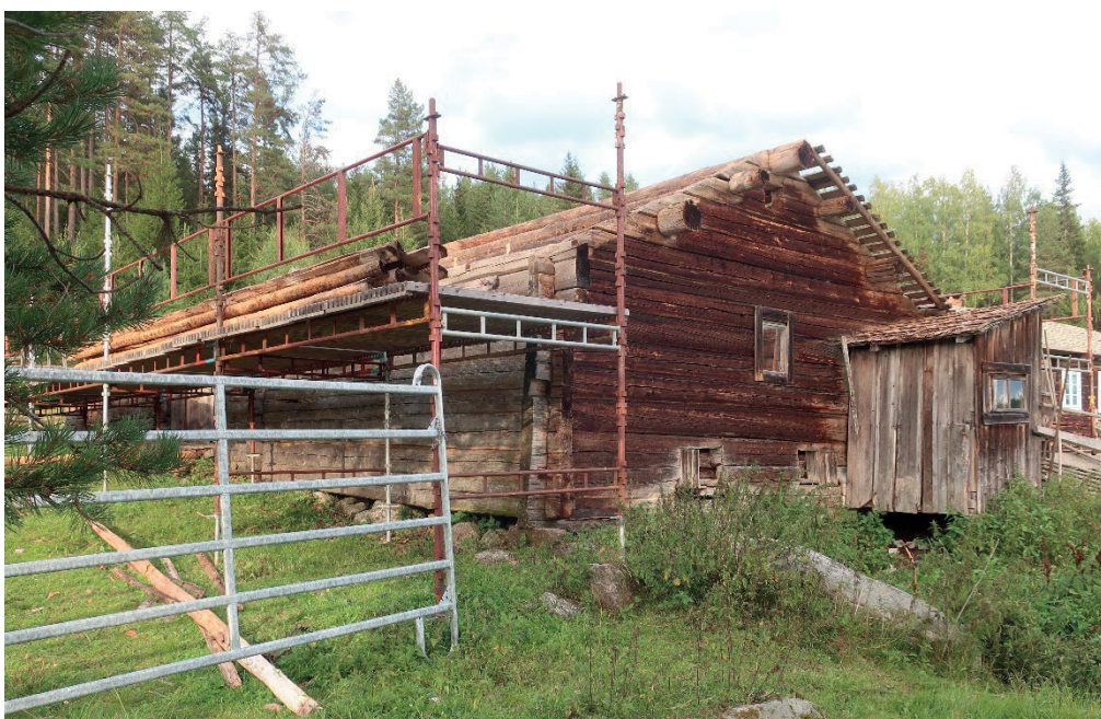
Figur 12. Fäxet från väst under renoveringen. Foto: Daniel Olsson 2020-08-28.
