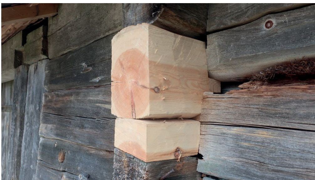
Figur 16. Detalj av lagade knutskallar i vägg C. Foto: Daniel Olsson 2020-10-19.
