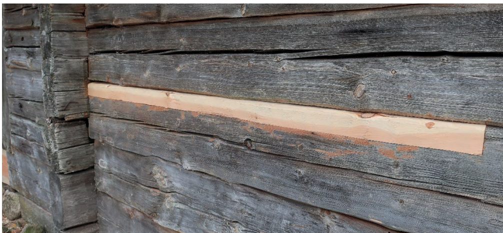
Figur 15. Detalj av timmerlagning i vägg C. Foto: Daniel Olsson 2020-10-19.
