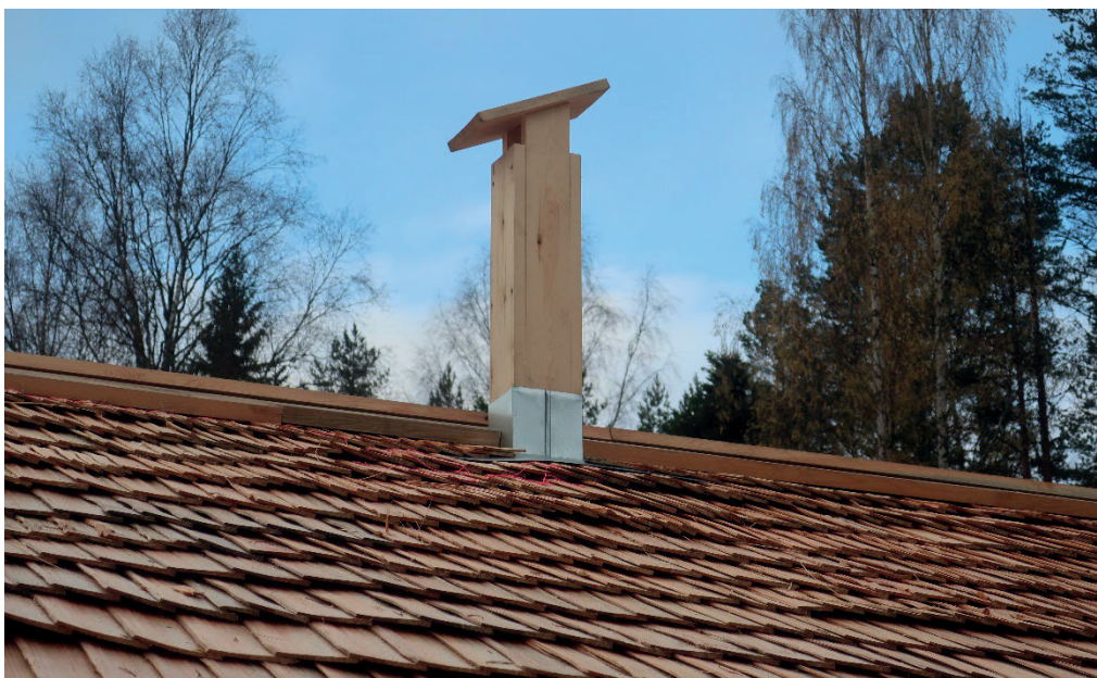
Figur 21. Detalj av ventilationsskorstenen på fäxets tak från söder. Foto: Daniel Olsson 2020-10-19.
