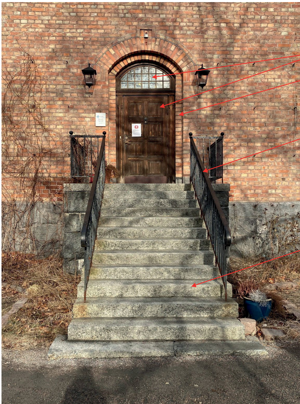
Figur 22. Entrétrappan mot söder. Foto: 2022-03-07.
