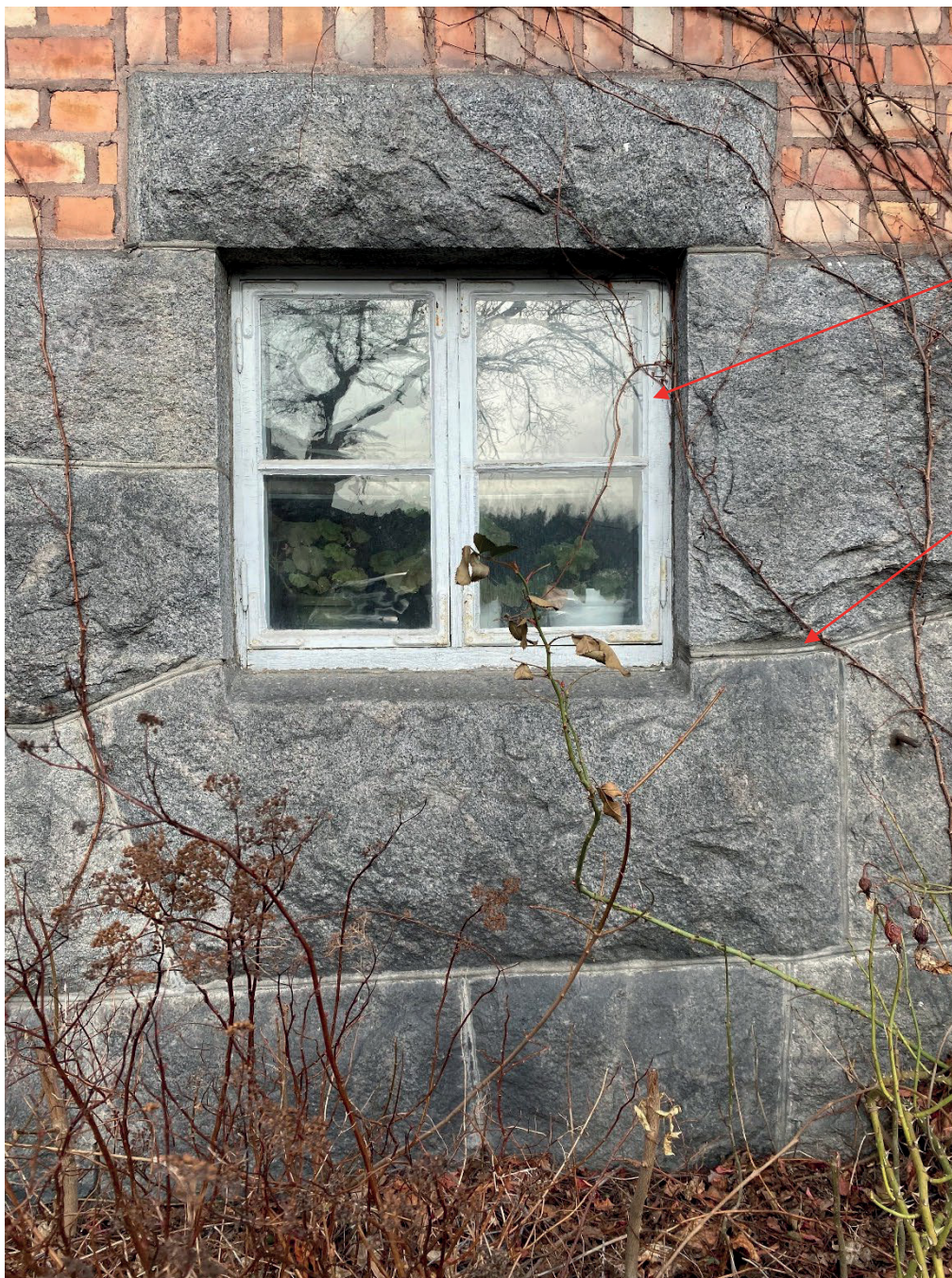
Figur 26. Detalj på sockel med källarfönster. Foto: 2022-03-07.
