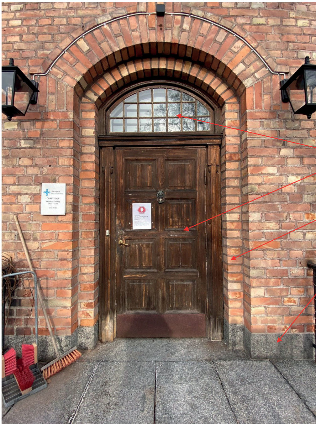
Figur 23. Huvudentré mot söder. Foto: 2022-03-07.
