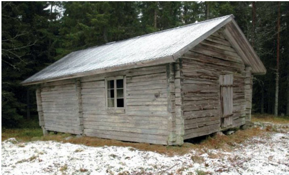
Figur 4. Källarboden från väster innan renoveringen. Foto: Daniel Olsson 2017-10-25.
