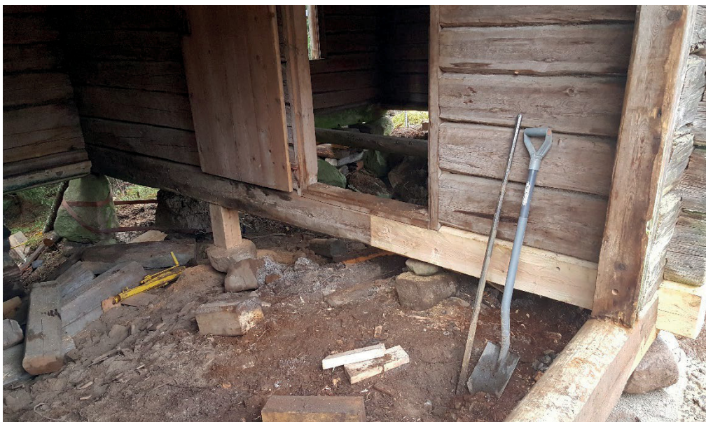
Figur 19. Skarvning av syllstock under mellanvägg F samt ett nytt stöd under stocken. Foto: Lars Olofsson 2018-11-02.
