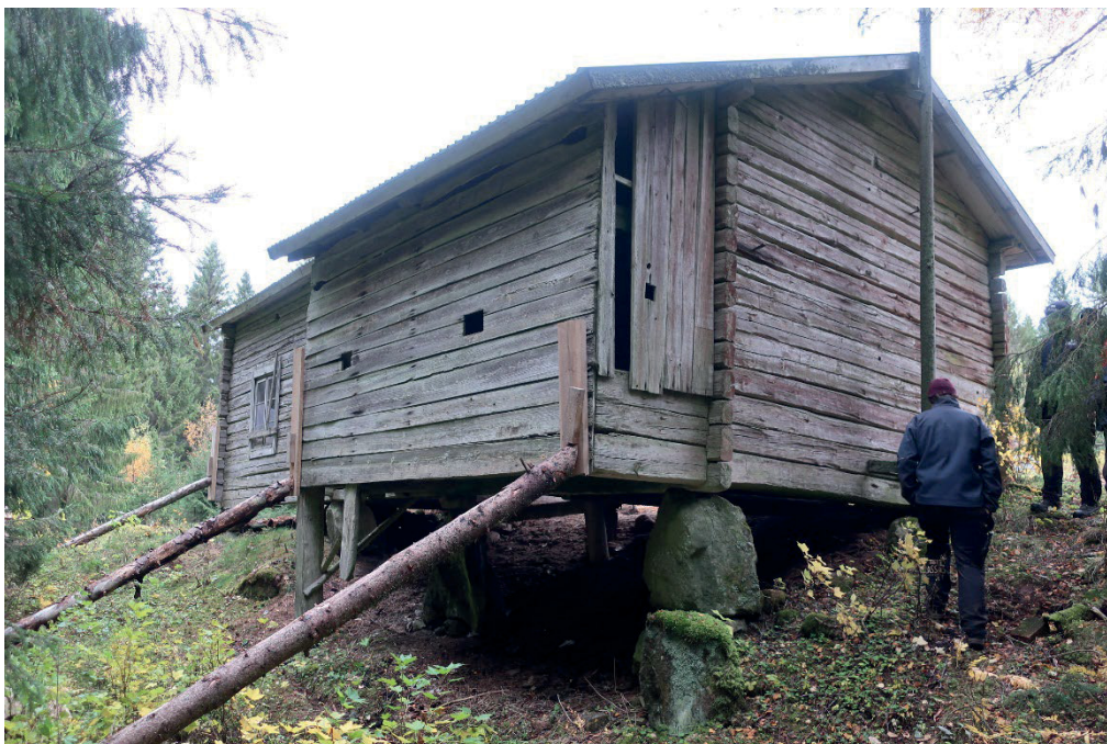
Figur 9. Stallet från söder med stockar som stöttor innan renoveringen. Foto: Daniel Olsson 2018-10-09.
