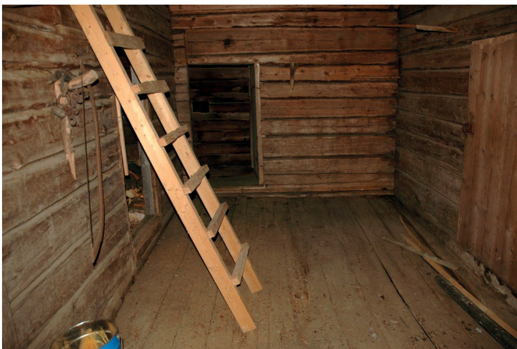
Figur 7. Stallslidrets interiör från nordöst. Foto: Daniel Olsson 2017-10-25.
