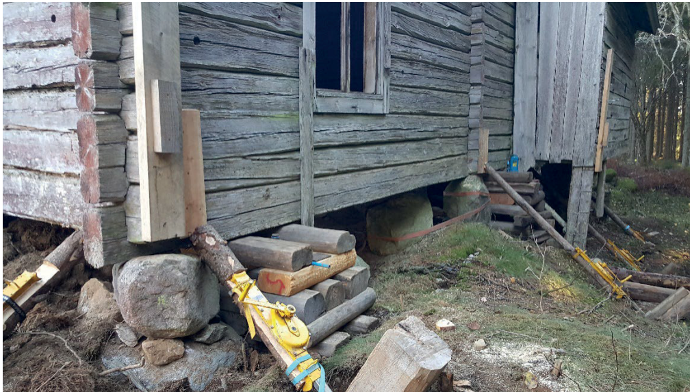
Figur 16. Stallet från norr under pågående lyftningsarbete. Foto: Lars Olofsson 2018-10-19.
