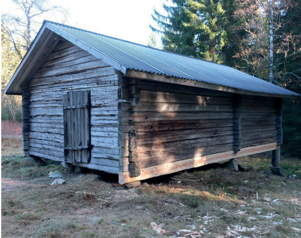
Figur 13. Källarboden från söder efter byte av syllstock. Foto: Daniel Olsson 2018-10-25.
