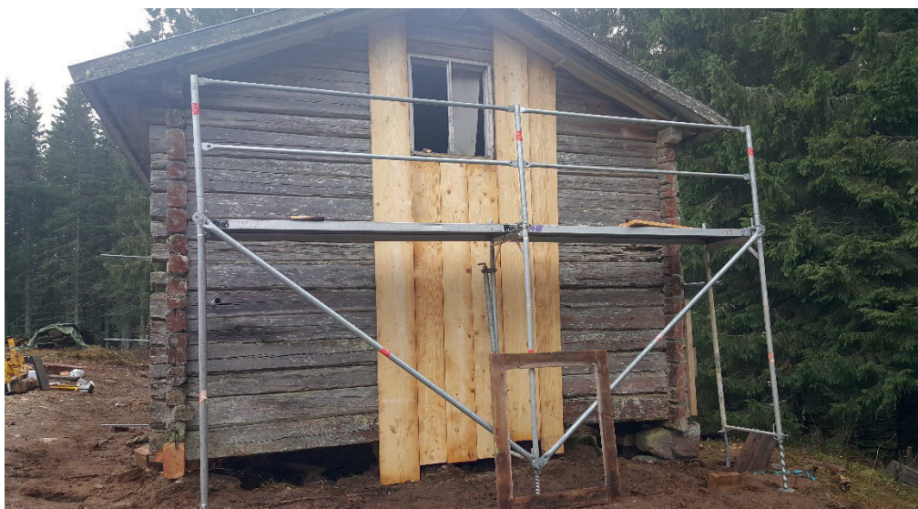
Figur 25. Uppsättning av panel på stalllets nordvästra panel. Foto: Lars Olofsson 2018-11-01.
