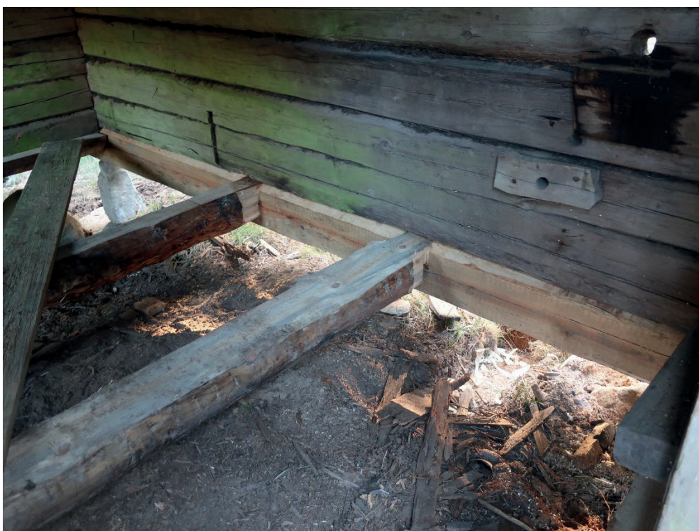
Figur 15. Källarbodens interiör med golvåsar inlaxade i den nya syllstocken. Foto: Daniel Olsson 2018-10-25.
