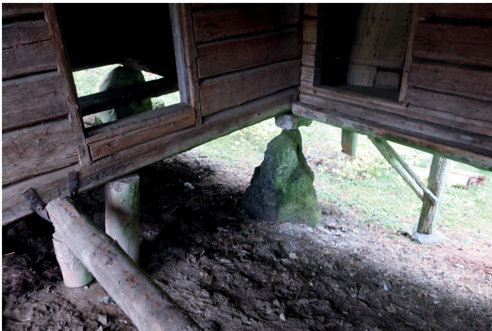
Figur 17. Stallslidret från norr efter bortplockning av golv och vissa golvåsar. Dörröppningen till vänster i bild leder in till stallet och till höger in till utedasset. Foto: Daniel Olsson 2018-10-25.
