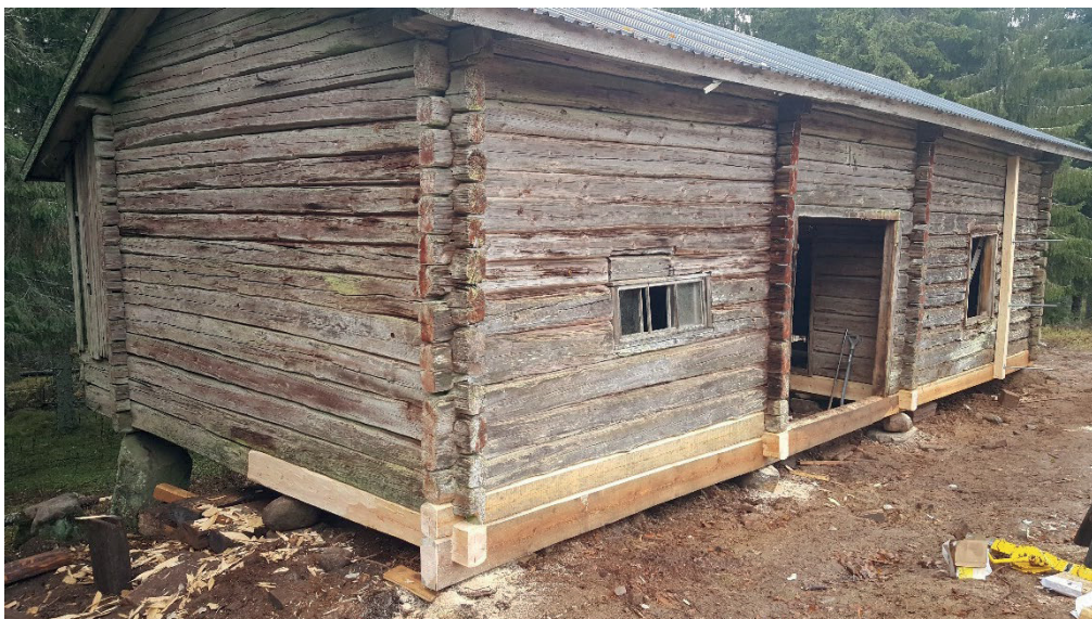
Figur 21. Stallet från öster efter avslutat timmerarbete. Foto: Lars Olofsson 2018-11-02.
