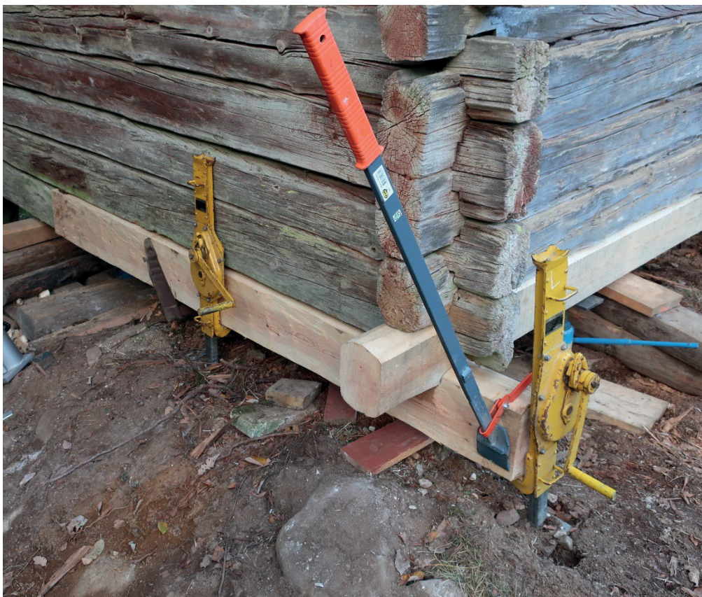
Figur 20. Detalj av utbytta stockar vid byggnadens östra hörn. Foto: Daniel Olsson 2018-10-09.
