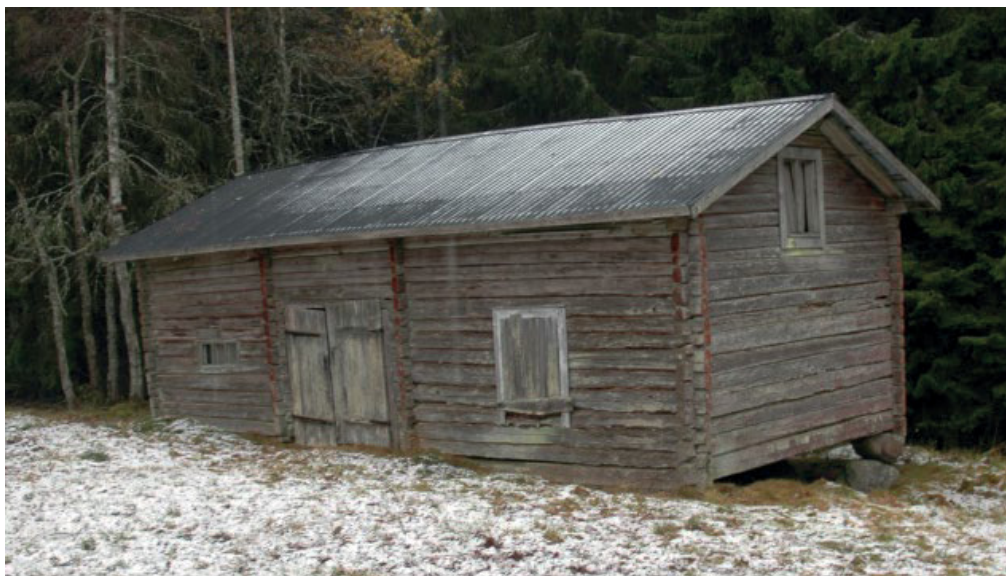
Figur 6. Stallet från nordöst innan renoveringen. Foto: Daniel Olsson 2017-10-25.
