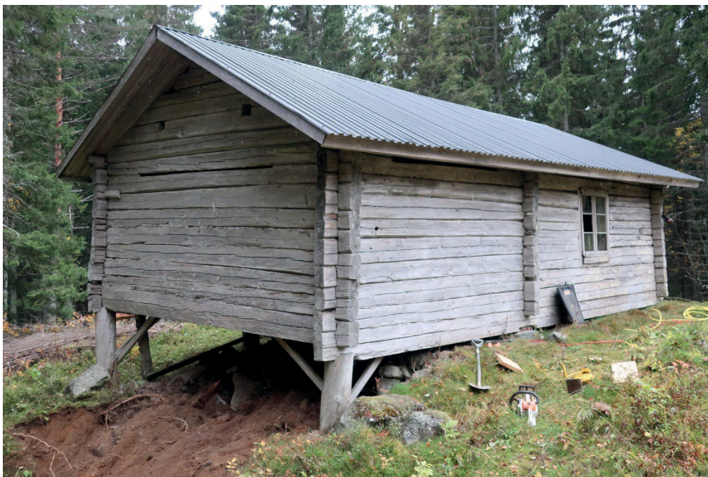
Figur 14. Källarboden från norr efter rivning av den delvis raserade stenkällaren. Foto: Daniel Olsson 2018-10-25.
