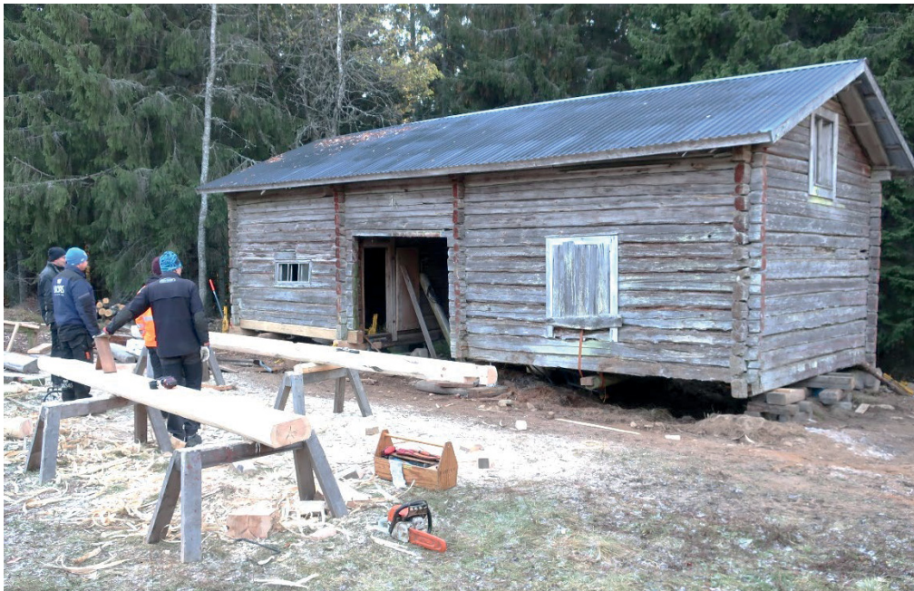
Figur 18. Huggning av nya timmerstockar till stallet. Foto: Daniel Olsson 2018-10-25.
