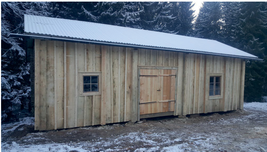
Figur 26. Stallet efter avslutad renovering. Foto: Lars Olofsson 2018-11-20.
