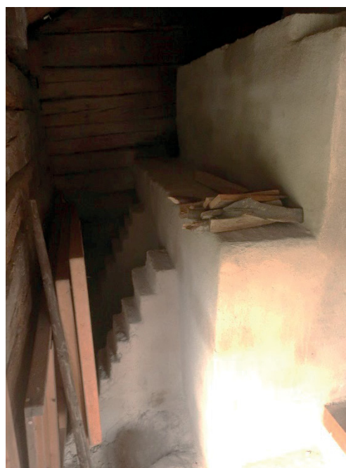
Figur 13. Detalj av sidostöden efter putsning. Foto: Daniel Olsson 2021-10-08.
