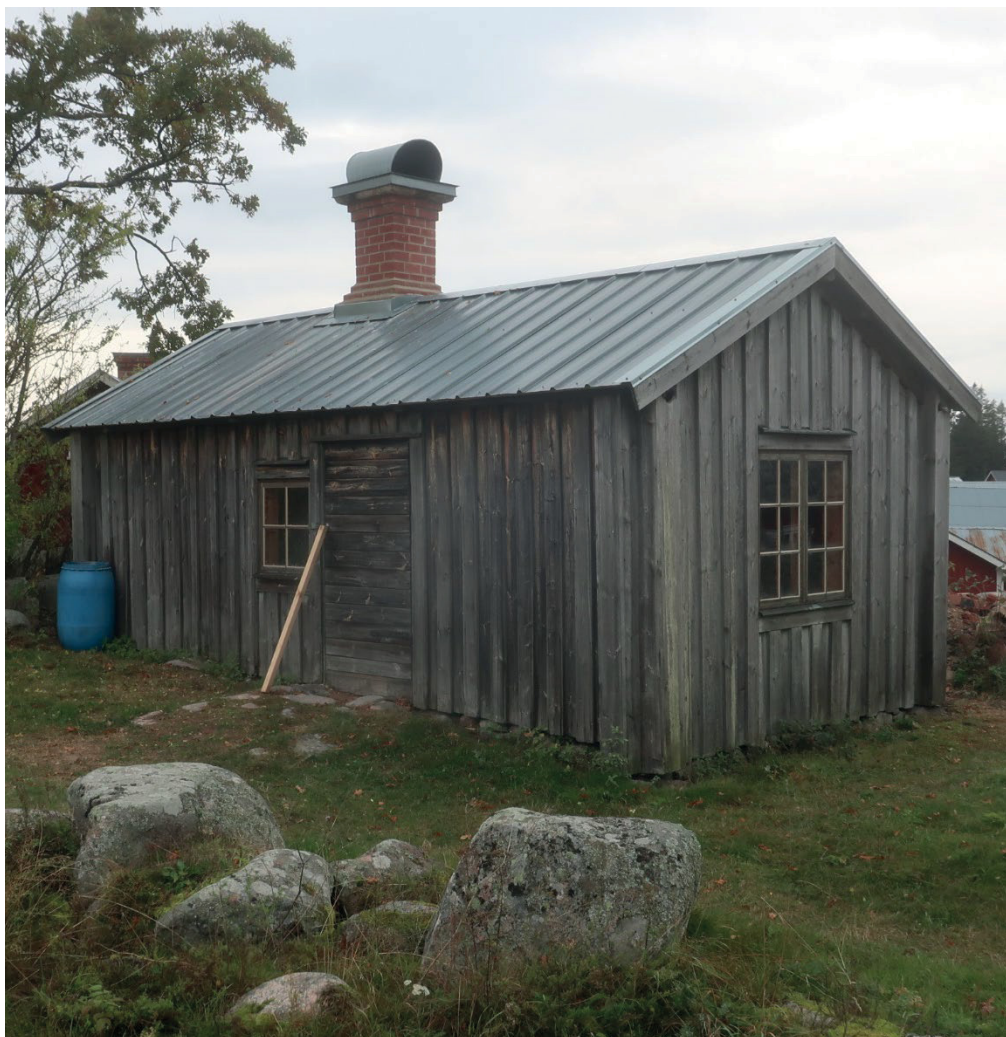
Figur16. Bagarstugan efter renoveringen med den återuppförda skorstenen. Foto: Daniel Olsson 2021-10-08.
