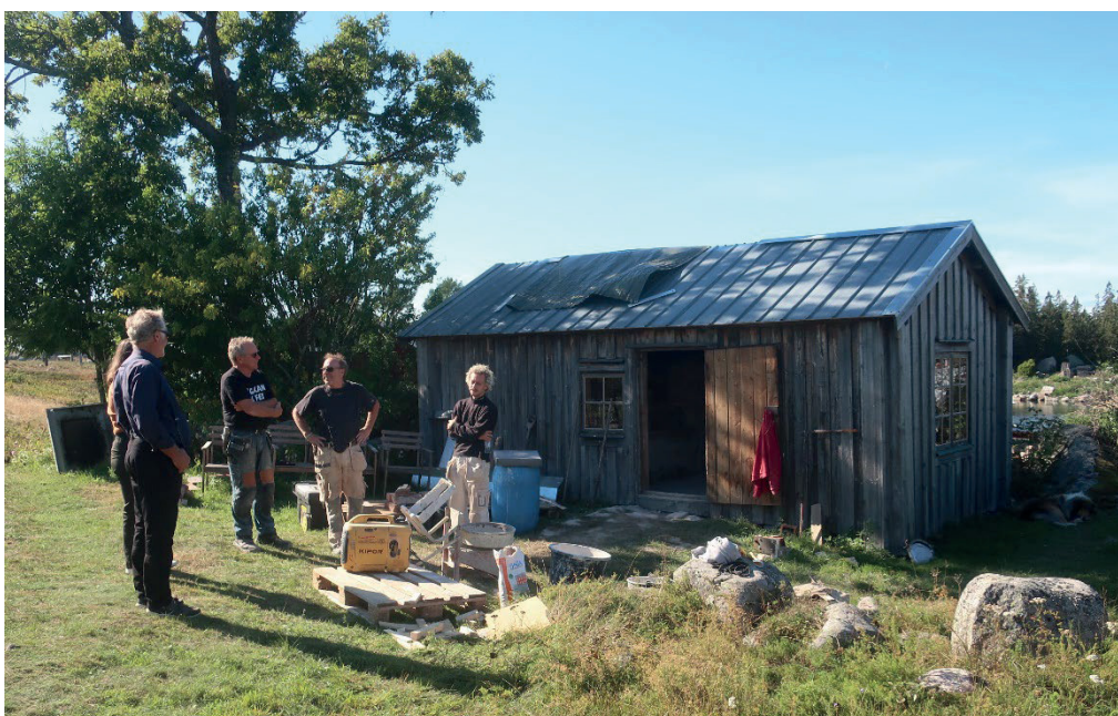
Figur 15. Bagarstugan från öster under renoveringen. Foto: Daniel Olsson 2021-08-31.
