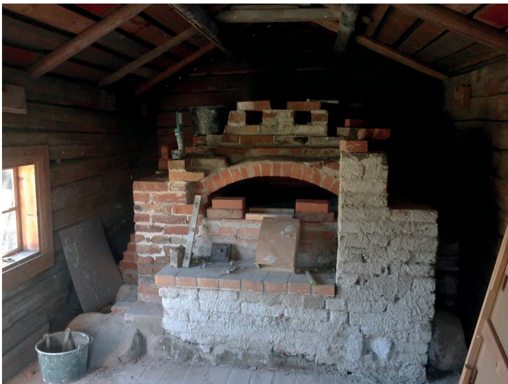
Figur 11. Bakugnen från öster under återuppförandet. Foto: Daniel Olsson 2021-08-31.
