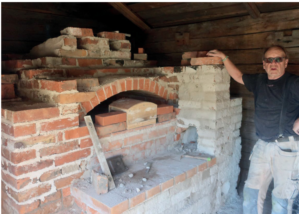
Figur 8. Bakugnen under återuppförande. Till höger i bild muraren Kjell Herlin. Foto: Daniel Olsson 2021-08-31.
