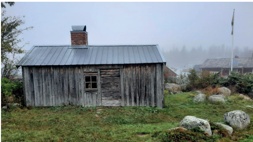
Figur 4. Bagarstugan från sydöst med den dåvarande skorstenen innan renoveringen. Foto: Anders Eklind, 2020-10-01.
