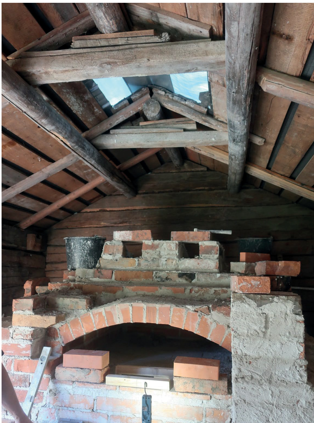
Figur 10. Bakugnen från öster under återuppförandet. Foto: Daniel Olsson 2021-08-31.
