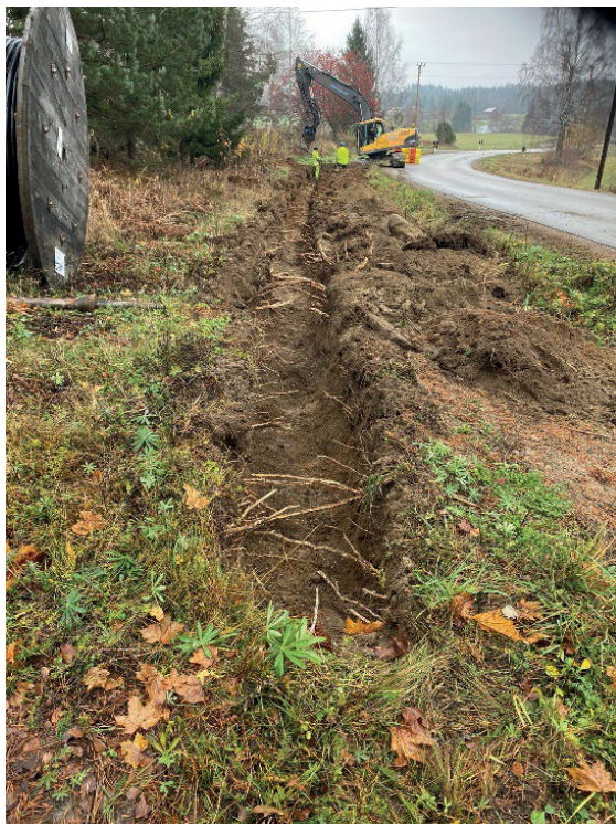
Figur 8. Schakt 2. Schaktet grävdes i det som tolkades vara omrörda massor. Foto från sydsydväst: Kerstin Westrin.
