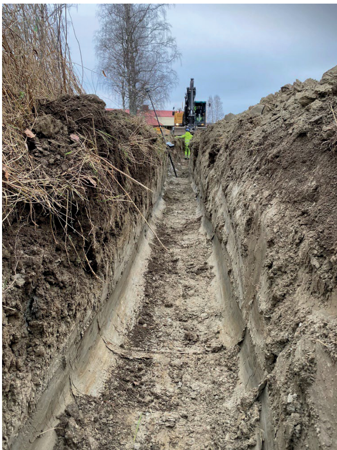
Figur 12. Schaktet på den västra sidan om vägen. Foto från söder: Kerstin Westrin.
