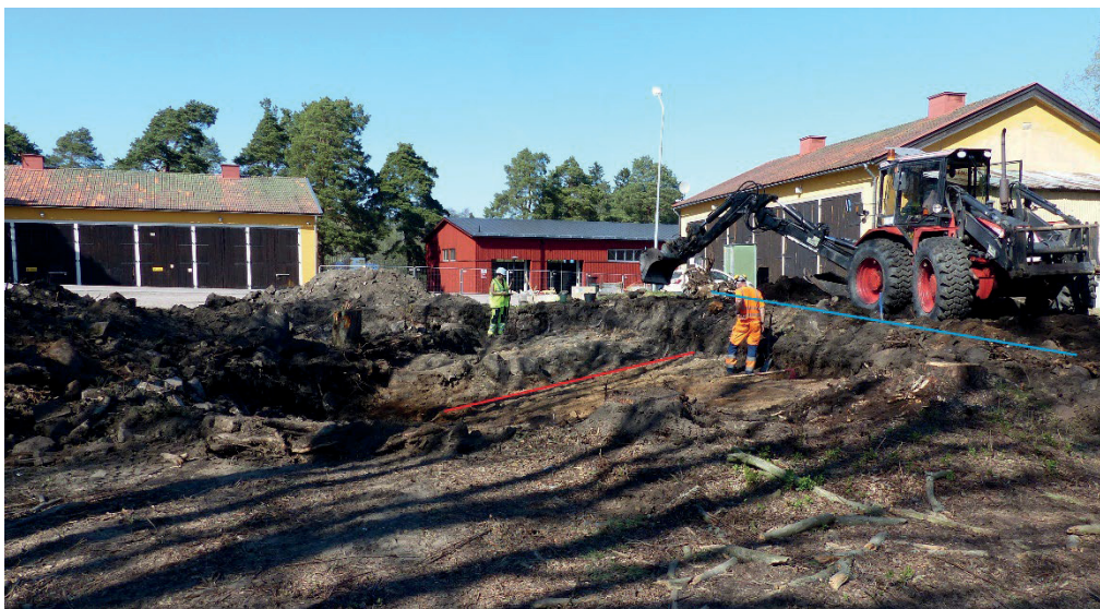
Figur 11. Schakt 5. Här framgår det tydligt att marken sluttar (se röd linje) ner mot väster (vänster i bild) där marken var blötare. Den röda linjen markerar även läget för stigen A1. Blå linje markerar kabeldiket. Foto från söder: Maria Björck.
