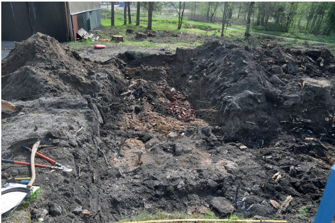
Figur 6. I schakt 2 påträffades enstaka slaggbitar utan kontext tillsammans med tegel och annat skräp. Foto från väster: Maria Björck.
