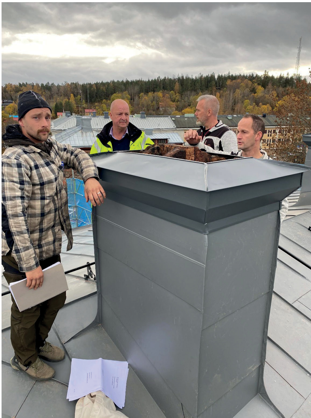
Figur 6. Slutbesiktning av plåt, 2021-10-21. På bilden syns Bo Villysson från WB Plåt och Tak, besiktningsman Åke Jonsson, ByggKonsulten AB och Pär Södergren och Thomas Wiklund från Bygg Bengt. Diskussion fördes här om behov av huvar på ventilationsskorstenarna.
