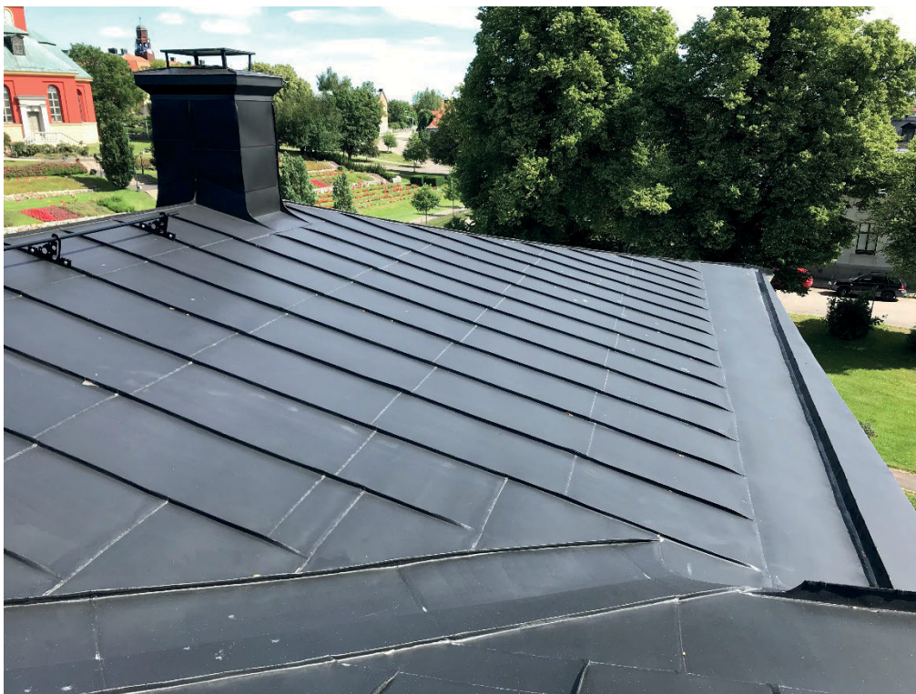
Figur 7. Foto från slutbesiktning av nylagt plåttak och målningsdelen. Notera den diskreta skorstenshuven. Foto: Fredrik Engren, Söderhamns kommun, 2022-07-07.
