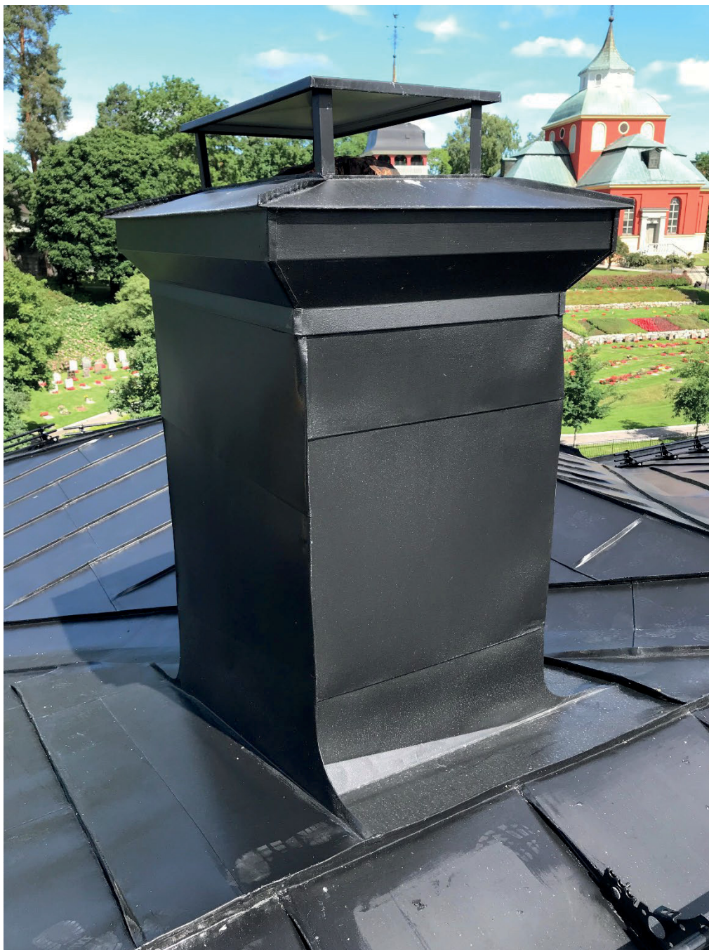
Figur 9. Foto från slutbesiktning av nylagt plåttak och målningsdelen. Alla fyra skorstenar har försetts med nya skorstenshuvar. Foto: Fredrik Engren, Söderhamns kommun, 2022-07-07.
