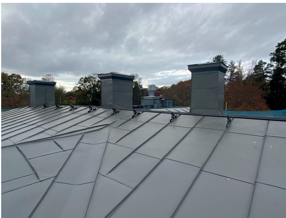
Figur 5. Slutbesiktning av plåt, 2021-10-21. Målning återstår och skorstenarna saknar ännu huvar.
