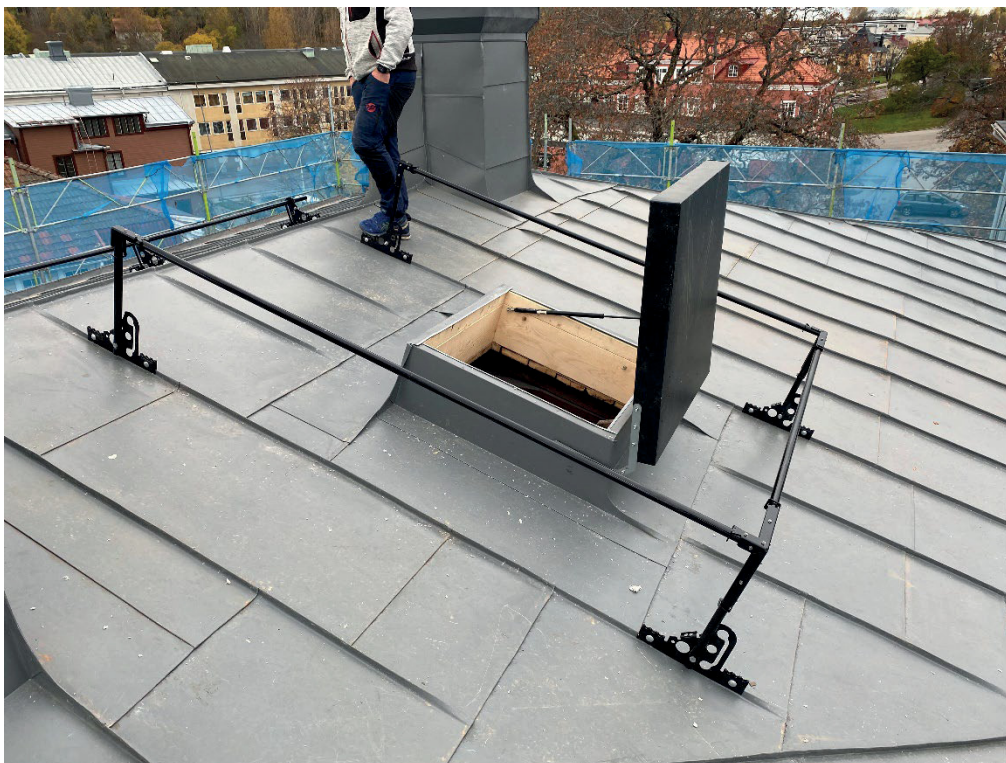
Figur 4. Slutbesiktning av plåt, 2022-10-21. Här syns den ombyggda takluckan, räcket kring denna samt röret för livlinefästen vidnocken.
