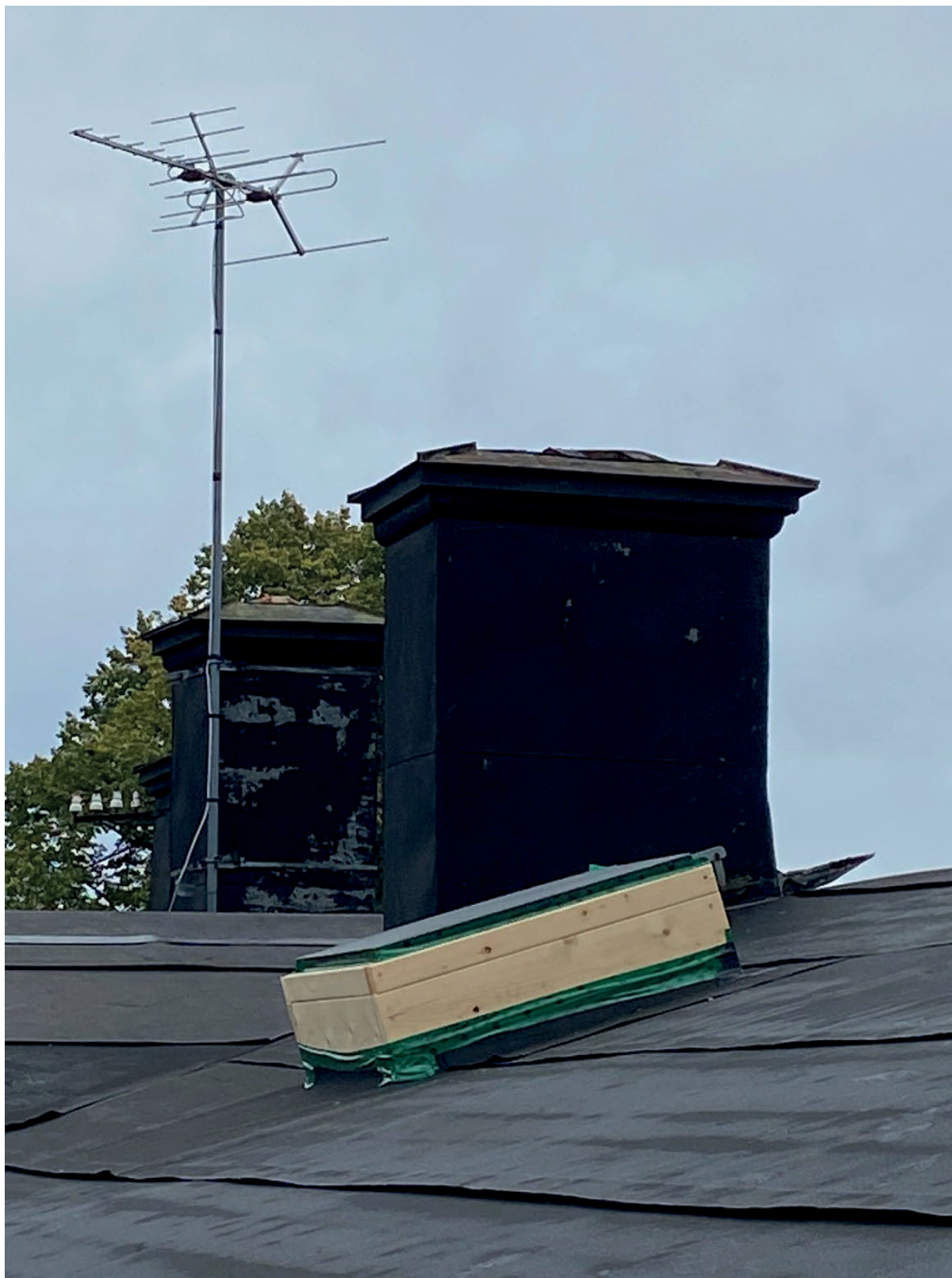
Figur 3. Under pågående arbeten. Taket är täckt med papp och den nya luckan är tillverkad. Ytorna väntar på plåtinklädnad. Skorstenarnas gamla plåt är ännu inte riven. Foto: 2021-09-07.
