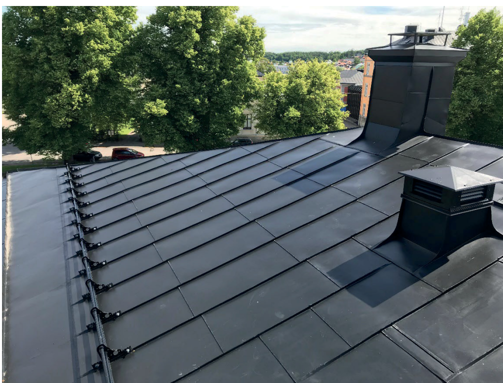
Figur 8. Foto från slutbesiktning av nylagt plåttak och målningsdelen. Notera den diskreta skorstenshuven. Här syns även snörasskyddet ovanför cykelställen, nordöstra sidan. Foto: Fredrik Engren, Söderhamns kommun, 2022-07-07.
