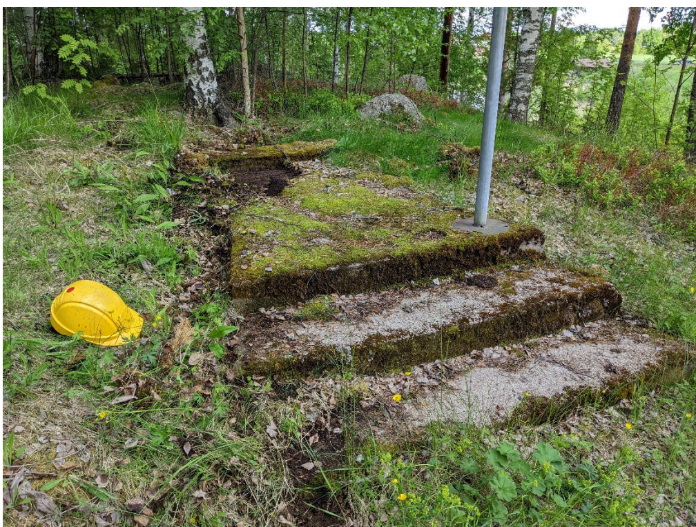
Figur 7. Betongtrappa upp till lägenhetsbebyggelse, objekt 7. Foto från sydöst: Olof Håkansson.
