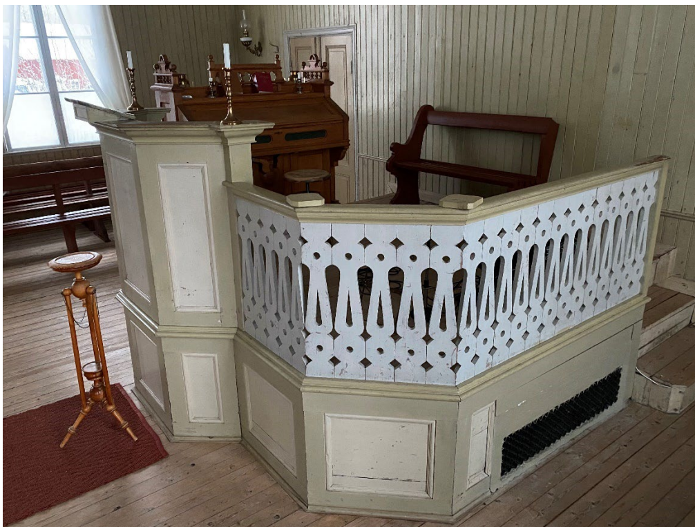
Figur 17. Podiet med predikstol. Notera den gallerförsedda öppningen i basen. Genom denna leddes värmen ut från pannan i källaren. Foto: Ulrika Olsson, 2022-11-24.
