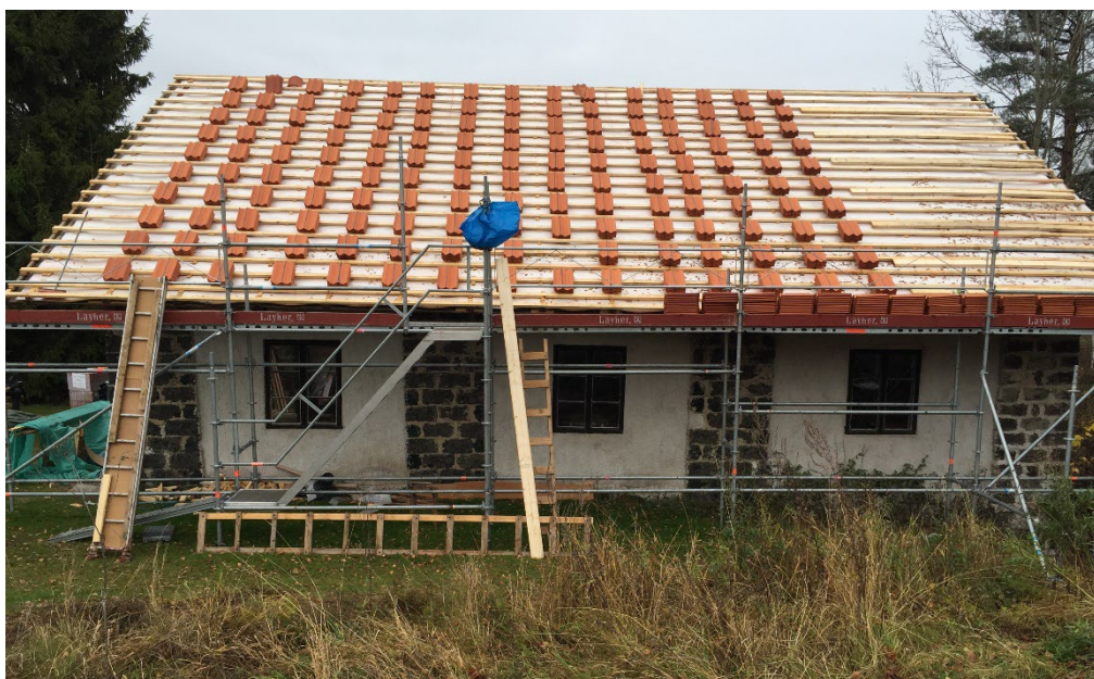
Figur 7. Underarbetet är utfört. Panel är lagad, skivor och väv monterad. Takpannorna är redo att läggas på den nya läkten. Foto: Kalvsnäs byalag hösten 2022.
