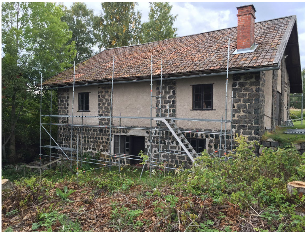
Figur 5. Under uppstart. Ställningsbygge pågår. Foto: Kalvsnäs byalag hösten 2022.
