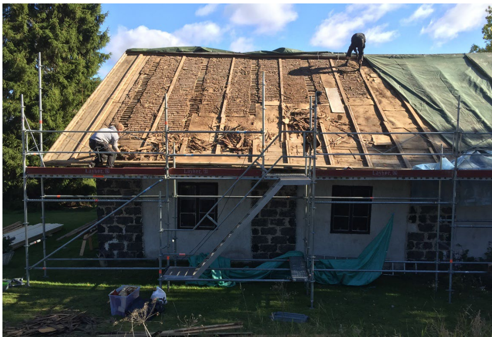
Figur 6. Rivning av taktäckning pågår. Foto: Kalvsnäs byalag hösten 2022.
