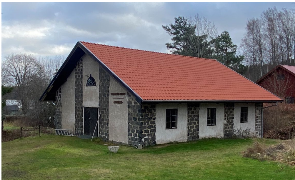
Figur 9. Slutbesiktning av takomläggningen på Kalvsnäs kvarn. Kvarnen sedd från nordväst. Foto: Ulrika Olsson, 2022-11-11.
