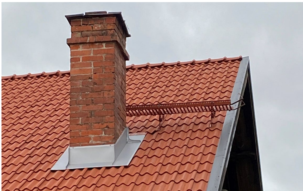
Figur 11. Takbryggan på det östra takfallet. Foto: Ulrika Olsson, 2022-11-11.
