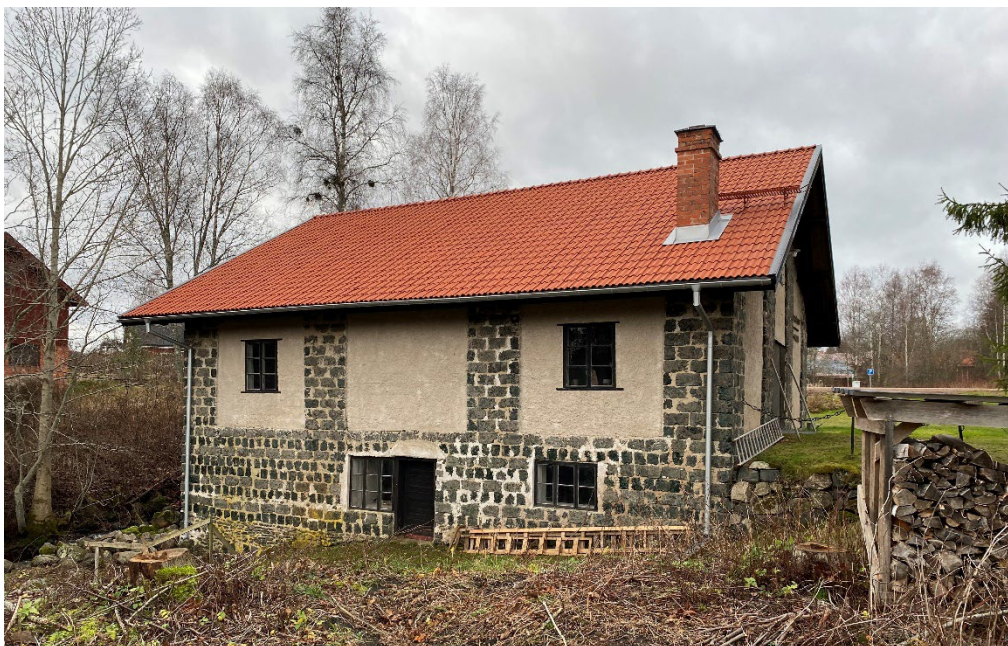
Figur 8. Slutbesiktning av takomläggningen på Kalvsnäs kvarn. Kvarnen sedd från öster. Foto: Ulrika Olsson, 2022-11-11.
