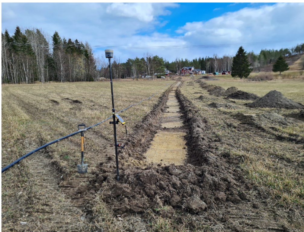
Figur 4. Schaktet OS204 fotat mot sydöst. Foto: Frida Löjdström.
