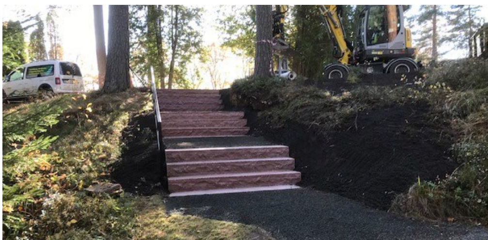
Figur 1. Den nyanlagda stentrappan i läget för en tidigare trappa av slipers. Trappan leder upp från minneslundens och kvarter U till skogsområdet i kvarter 8 och kvarter Gamla. Foto: Pirab Markservice, hösten 2022.
