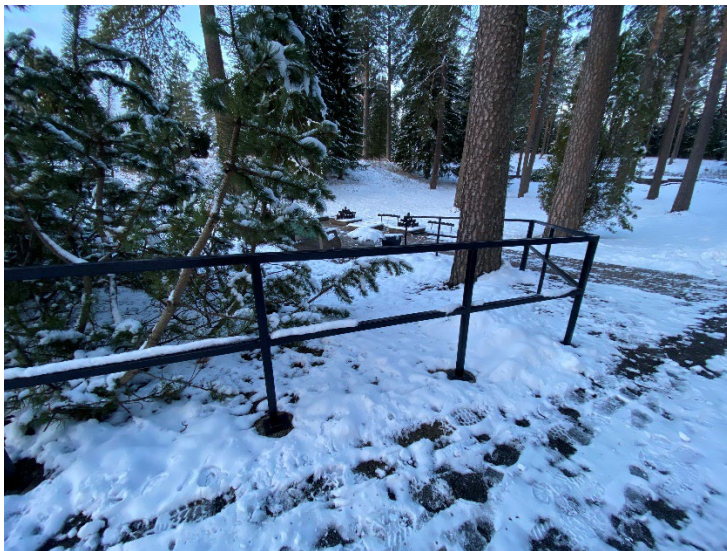
Figur 22. Ledstången från kvarter Gamla ner till minneslundens smyckningsplats följer den svängda vägen och består av sex sektioner. Foto: Ulrika Olsson, 2022-11-27.
