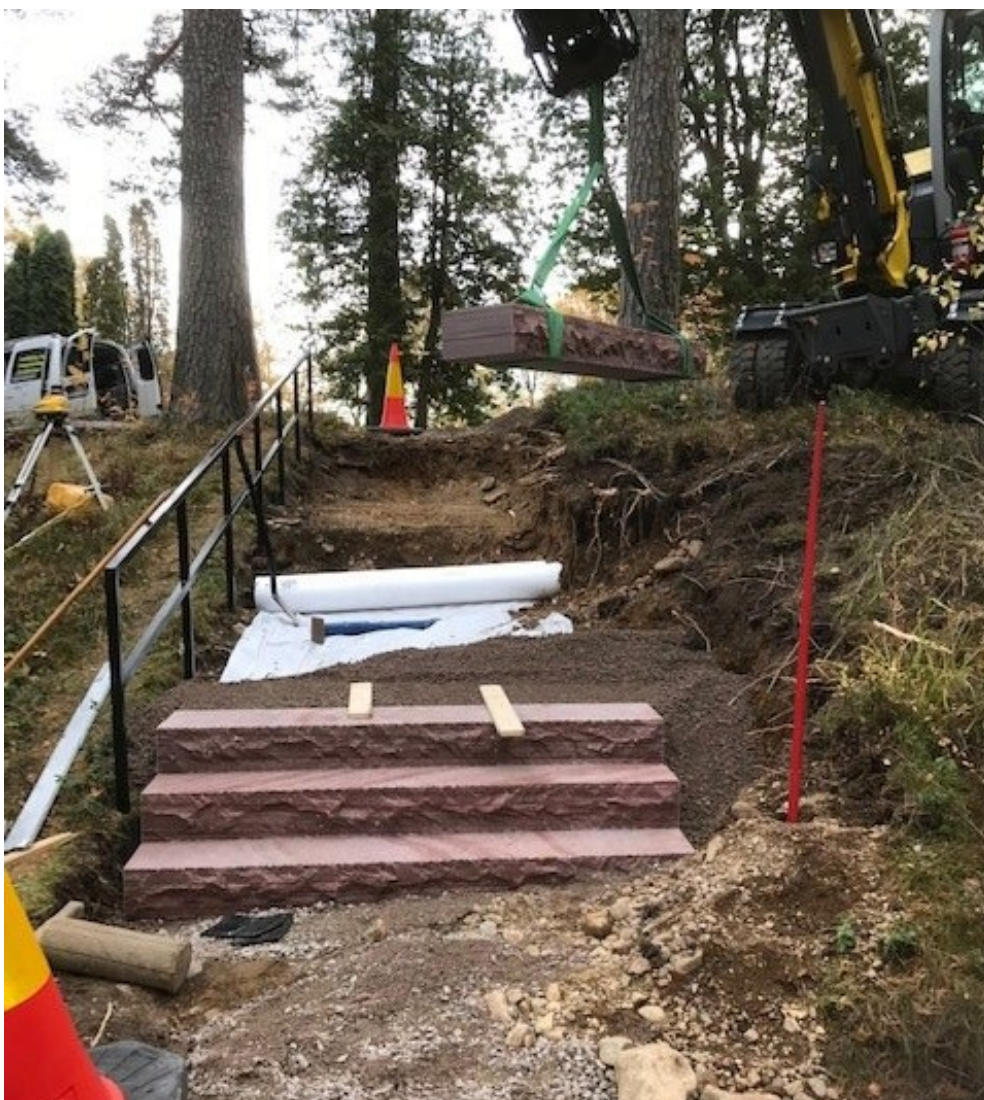
Figur 30. Den nya trappan av Älvdalssten/ Älvdalskvartsit växer fram i tre terrasser. Foto: Pirab Markservice, hösten 2022.
