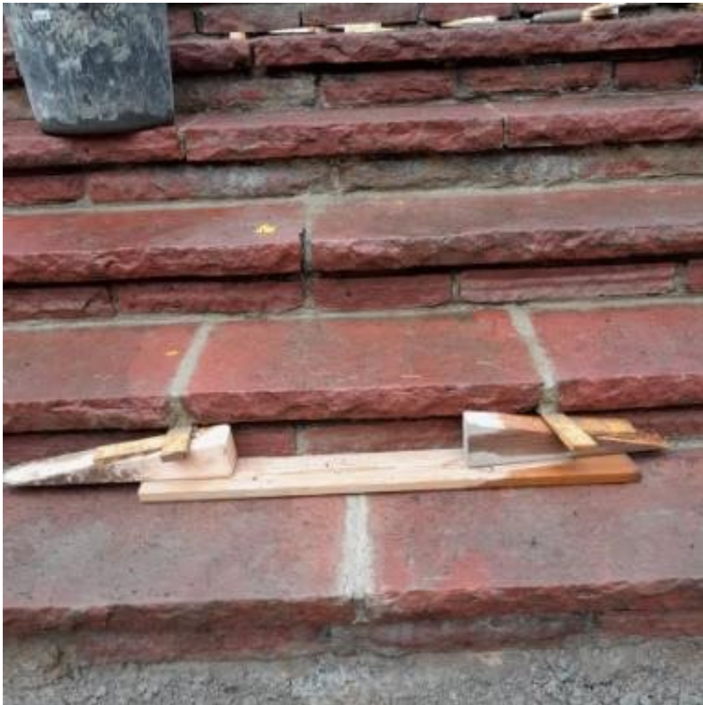
Figur 26. Stentrappa under arbetets gång. Foto: Pirab Markservice, hösten 2022.
