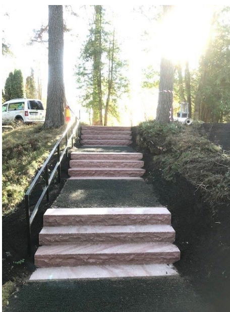
Figur 33 och figur 34. Den nya trappan är färdig och har nu en rak sträckning utefter ledstängen som hela tiden har bibehållits i sitt ursprungliga läge. Foto: Pirab Markservice, hösten 2022.
