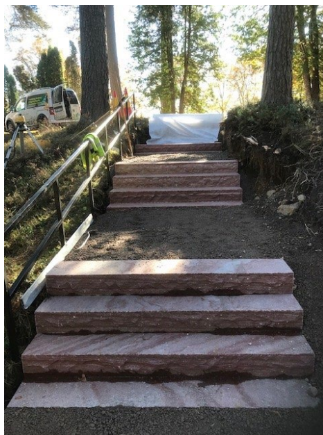
Figur 31 och figur 32. Den nya trappan av Älvdalssten/ Älvdalskvartsit växer fram i tre terrasser. Foto: Pirab Markservice, hösten 2022.
