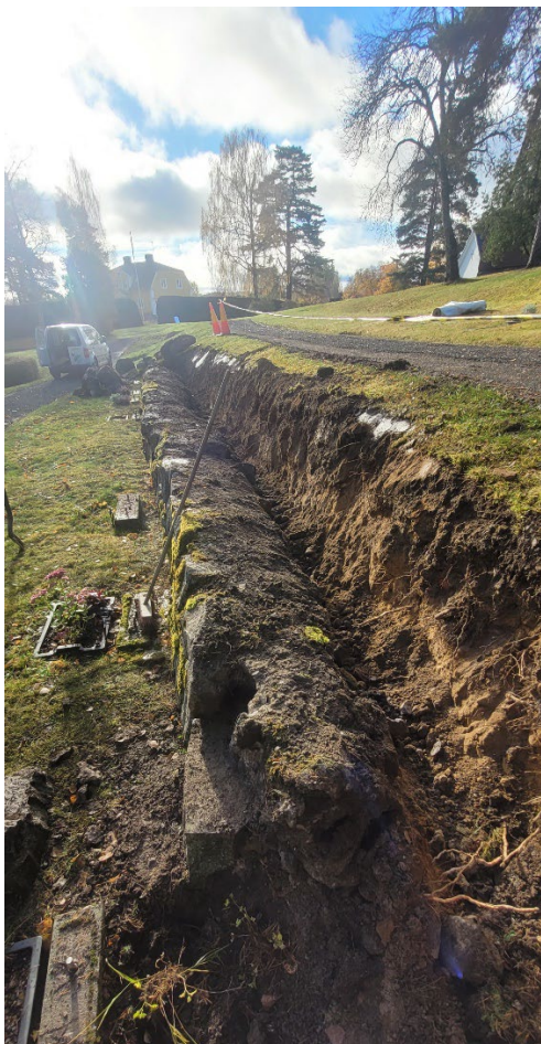
Figur 16 och figur 17. Den norra muren under arbetets gång. Stenarna i murens mitt var hopgjutna på baksidan och stenarna var därmed inte möjliga att helt demontera. Foto: Pirab Markservice, hösten 2022.
