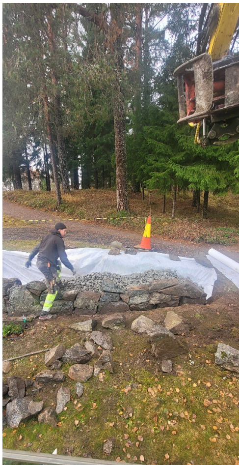
Figur 16 och figur 17. Den norra muren under arbetets gång. Stenarna i murens mitt var hopgjutna på baksidan och stenarna var därmed inte möjliga att helt demontera. Foto: Pirab Markservice, hösten 2022.
