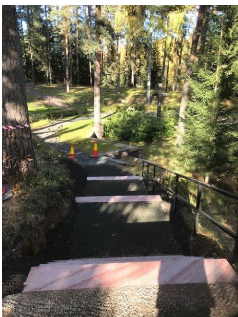
Figur 33 och figur 34. Den nya trappan är färdig och har nu en rak sträckning utefter ledstängen som hela tiden har bibehållits i sitt ursprungliga läge. Foto: Pirab Markservice, hösten 2022.
