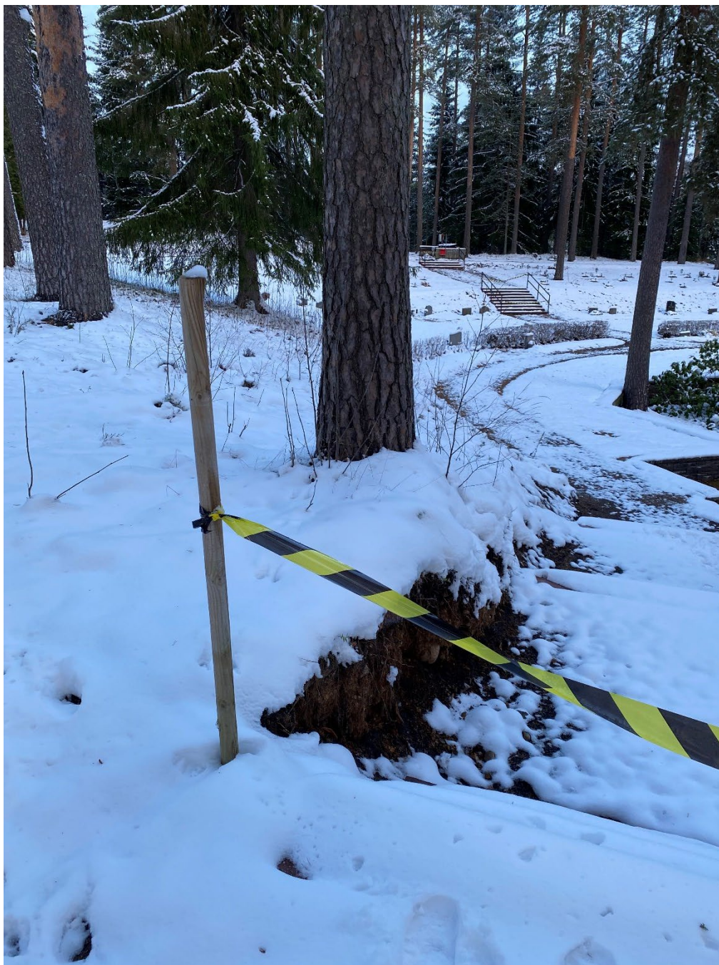
Figur 35. Här syns hur det bildats en skarp kant vid den nya trappan samt hur nära trappan som tallen växer. I bakgrunden skymtar de två åtgärdade stentrapporna. Foto: Ulrika Olsson, 2022-11-27.
