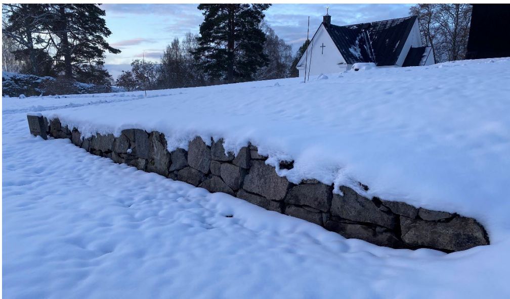
Figur 15. Den södra muren vid slutbesiktningen. Foto: Ulrika Olsson, 2022-11-27.
