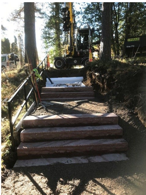
Figur 31 och figur 32. Den nya trappan av Älvdalssten/ Älvdalskvartsit växer fram i tre terrasser. Foto: Pirab Markservice, hösten 2022.
