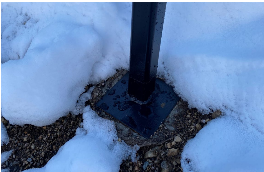
Figur 20. Förankringen av stolparna är i gjutna plintar. Stolparnas konstruktion har en del som är ingjuten i plinten. Foto: Ulrika Olsson, 2022-11-27.
