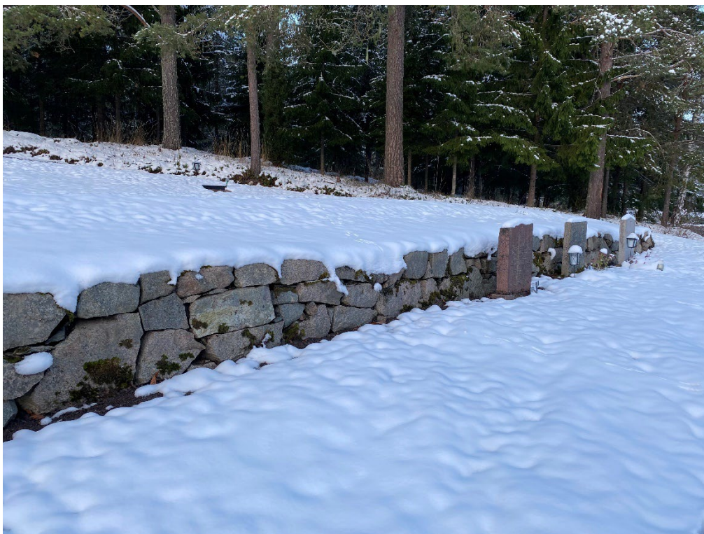
Figur 18. Den norra muren vid slutbesiktningen. Foto: Ulrika Olsson, 2022-11-27.
