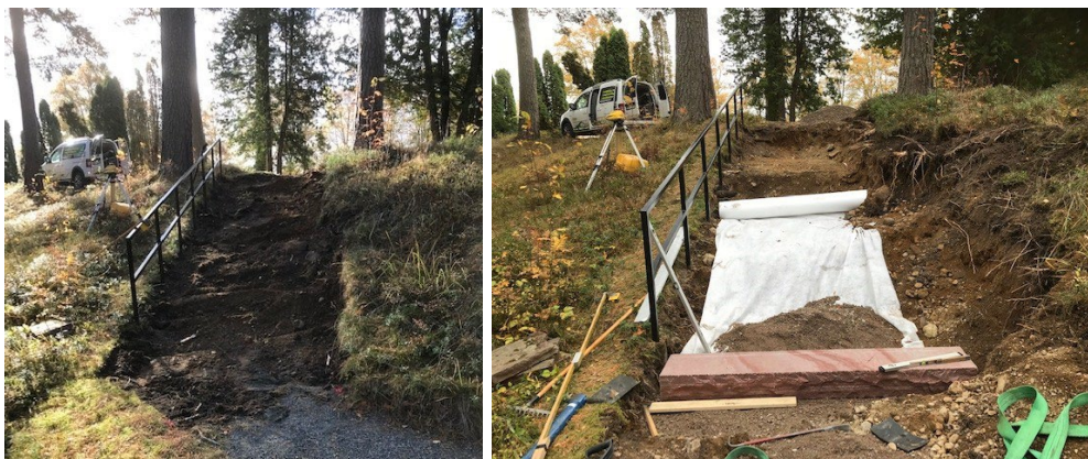
Figur 28 och figur 29. Den gamla trappan av slipers är bortgrävd och anläggandet av den nya trappan har påbörjats. Foto: Pirab Markservice, hösten 2022.
