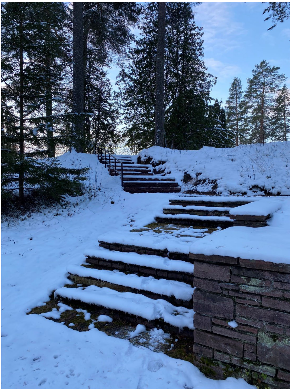
Figur 35. Högst upp syns den nyanlagda trappan och närmast kameran trappan som leder upp från altaret i minneslunden. Den nyanlagda trappan harmonierar nu med den nedre trappan. Foto: Ulrika Olsson, 2022-11-27.
