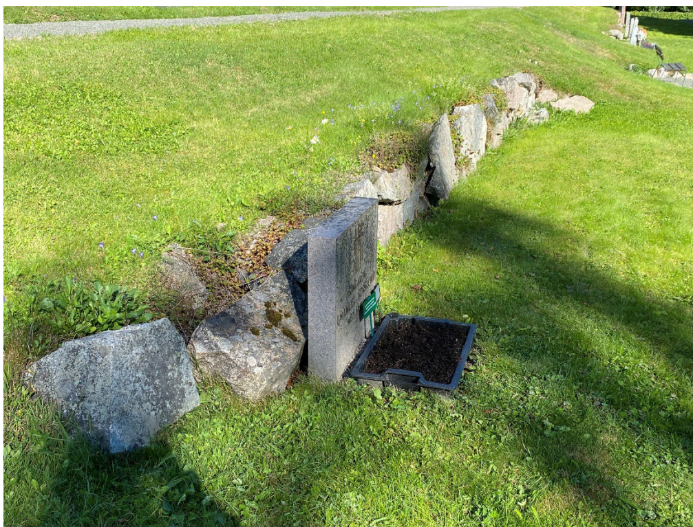
Figur 3. Den södra muren innan påbörjade arbeten. Foto: Ulrika Olsson, 2022-09-01.
