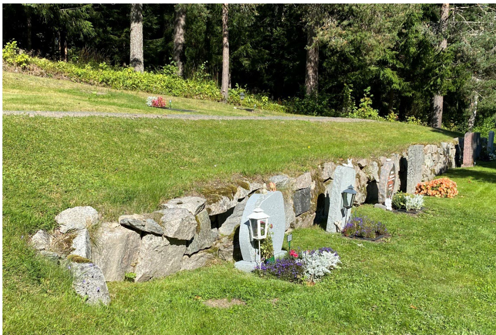
Figur 4. Den norra muren innan påbörjade arbeten. Foto: Ulrika Olsson, 2022-09-01.
