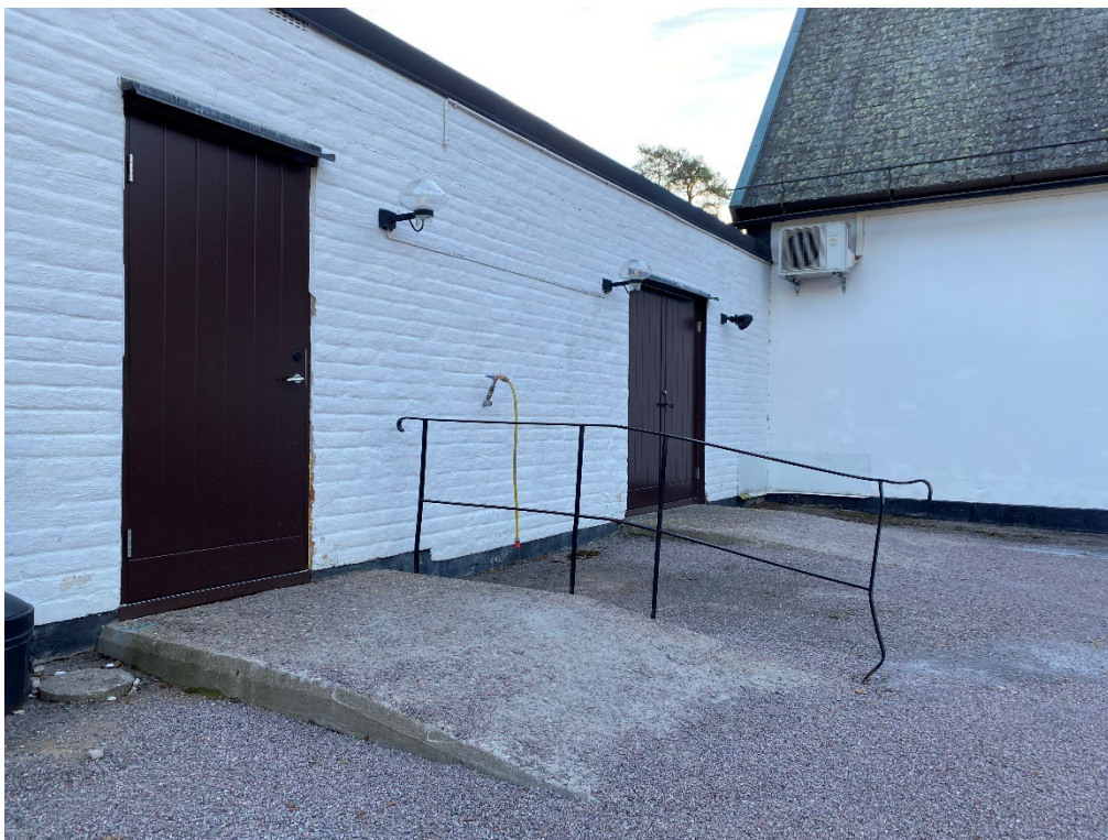
Figur 10. Två befintliga entréer på den västra fasaden har försetts med nya dörrar. Foto: Ulrika Olsson, 2023-01-31.
