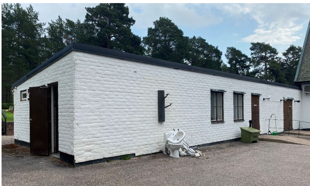
Figur 3. Den låga tillbyggnaden sedd från nordväst precis i uppstart av arbetena. Den öppna dörren på gaveln leder in till ett litet toalettutrymme. Foto: Ulrika Olsson, 2022-08-19.
