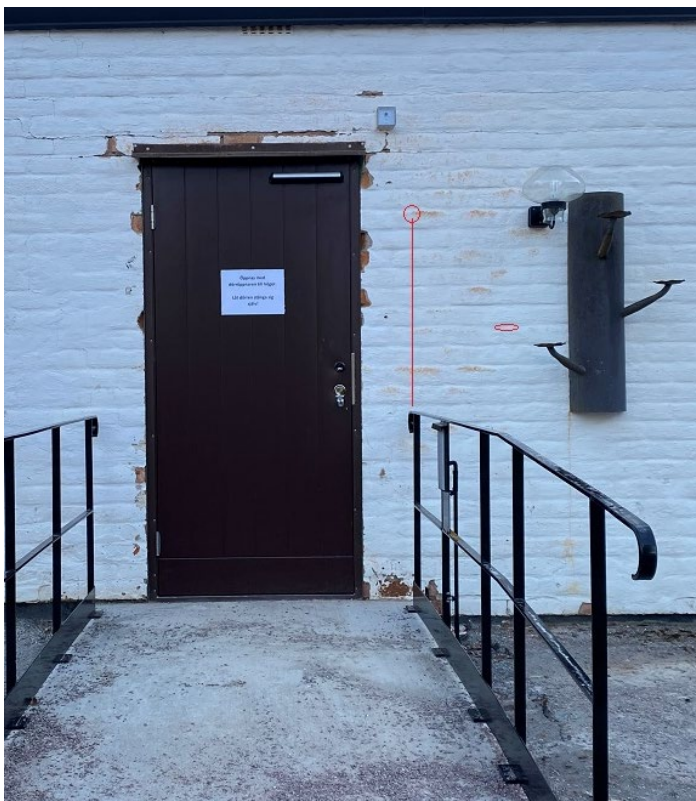
Figur 11. Den vägghängda armaturen ska flyttas närmare dörren och sättas på samma linje som räcket. Foto: Ulrika Olsson, 2023-01-31.
