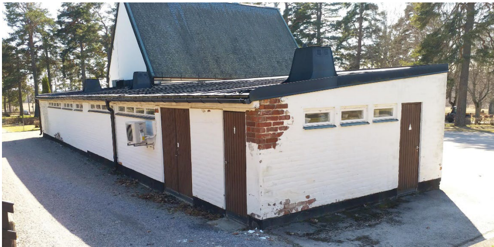
Figur 5. Tillbyggnaden fotad vid ett tidigare rådgivningsbesök, 2018-05-03. Foto: Ulrika Olsson.
