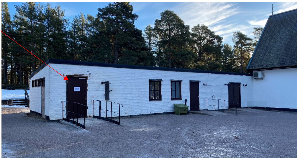
Figur 1. Den låga längan uppfördes 1958 och är hopbyggd med Österheds kapell, uppfört 1925. Den röda pilen markerar dörren in till den nya RWC'n. Foto: Ulrika Olsson, 2023-01-31.
