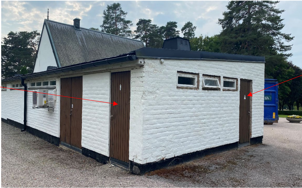
Figur 4. Tillbyggnaden sedd från nordöst, precis i uppstart av arbetena. Pilarna markerar de båda små toalettutrymmena. Vid detta besök hade rivning påbörjats kring de låga gavelfönstren. Foto: Ulrika Olsson, 2022-09-19.
