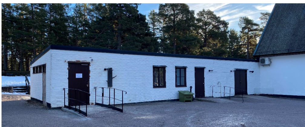
Figur 7. De två högra dörrarna på den västra fasaden är bytta. Den vänstra dörren vid gaveln är nyupptagen och leder in till ett ny RWC. Foto: Ulrika Olsson, 2023-01-31.
