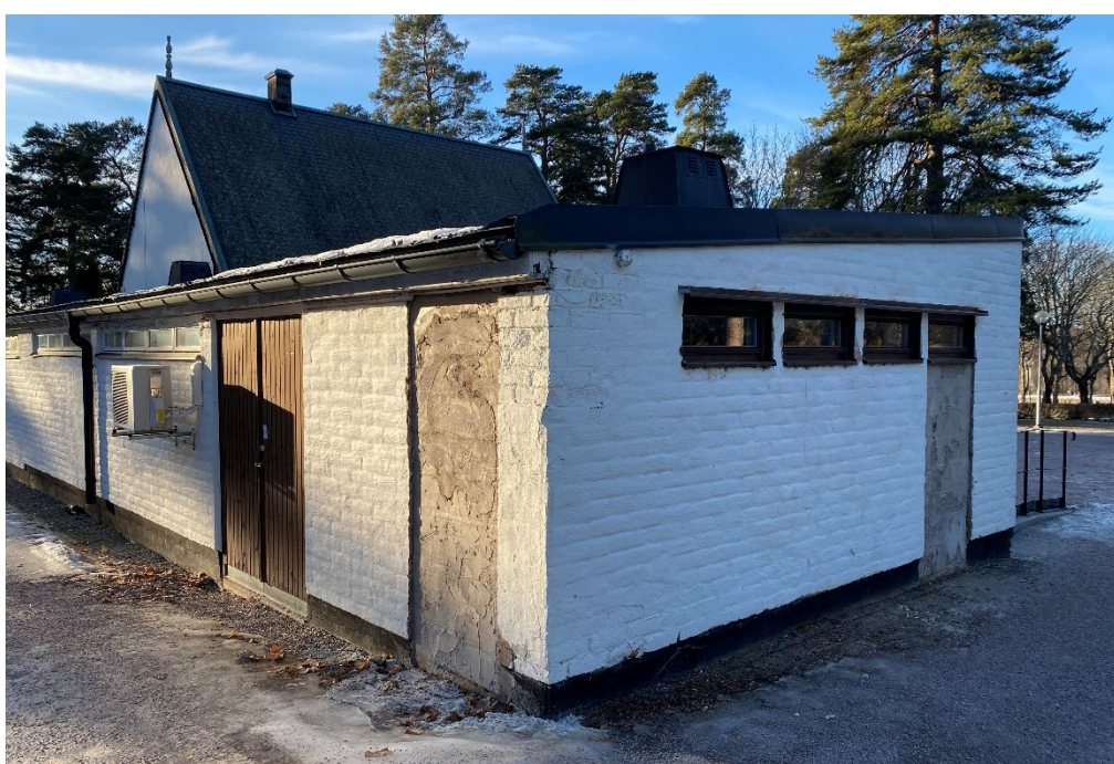
Figur 6. Efter avslutade arbeten. Foto från nordöst. De två dörröppningarna som tidigare ledde in till de två små toalettutrymmena, har satts igen. Foto: Ulrika Olsson, 2023-01-31.
