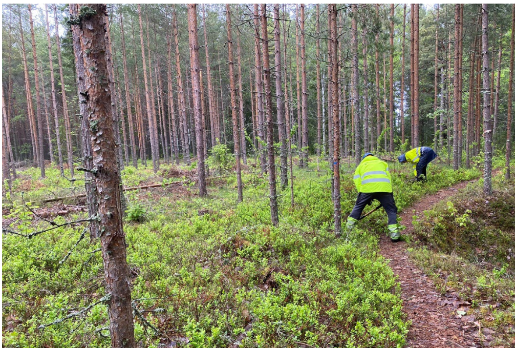
Figur 11. Olof Håkansson och Frida Löjdström gräver provgropar i området som det inte gick att schakta på grund av stubbar och kvarlämnad gallringsved. Foto från öster: Kerstin Westrin.
