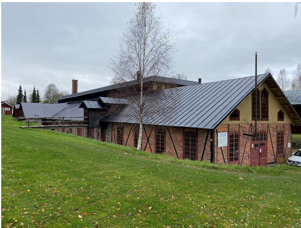
Figur 32. Plåttaket mot sydöst efter färdigställt målningsarbete. Foto: 2021-10-12.
