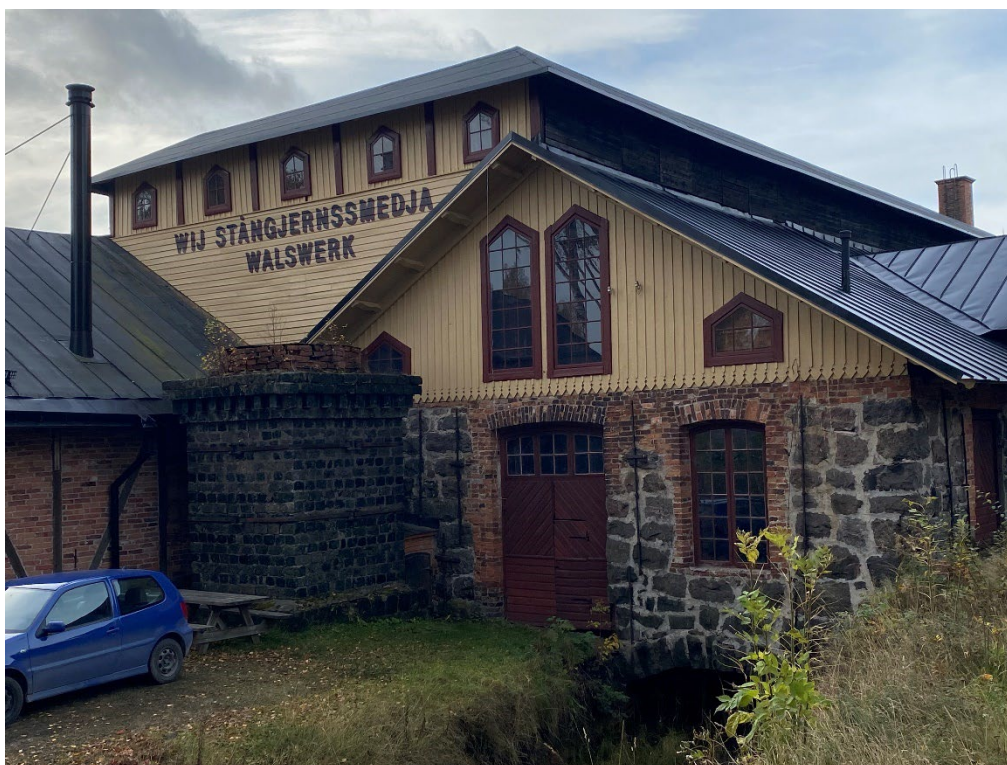
Figur 34. De panelklädda fasaderna efter avslutade arbeten. Foto: 2022-10-11.
