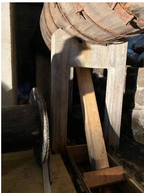
Figur 24. Regnvatten leds ner och in i valsverket via trätrumman och vidare ner till en befintlig ränna. Foto: 2021-05-18.
