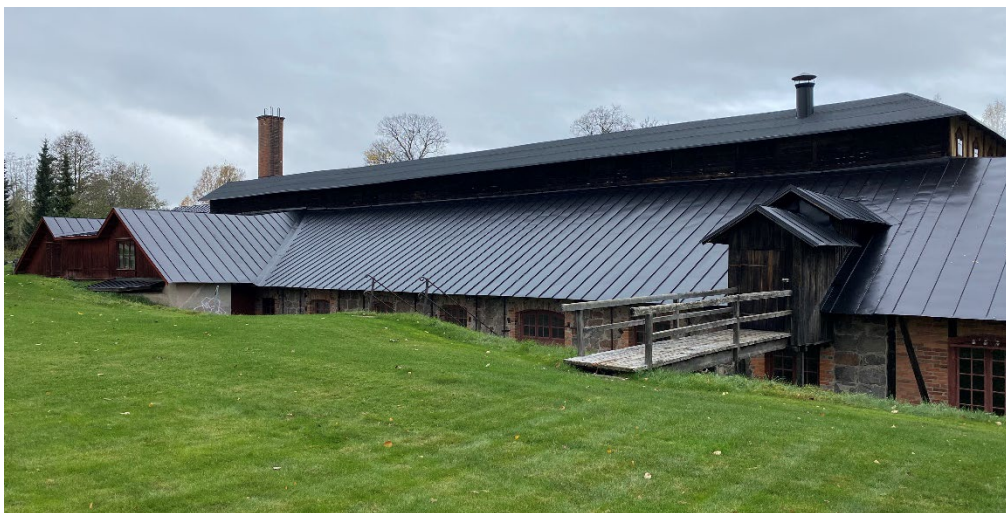
Figur 29. Lanterninernas tak efter avslutade arbeten. Foto: 2021-10-12.
