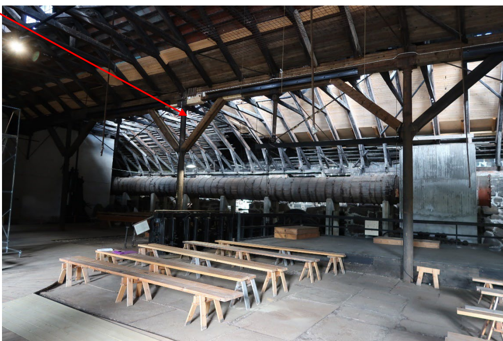
Figur 11. Den flyttade pelarens läge i valsverket. Foto: 2020-08-13.
