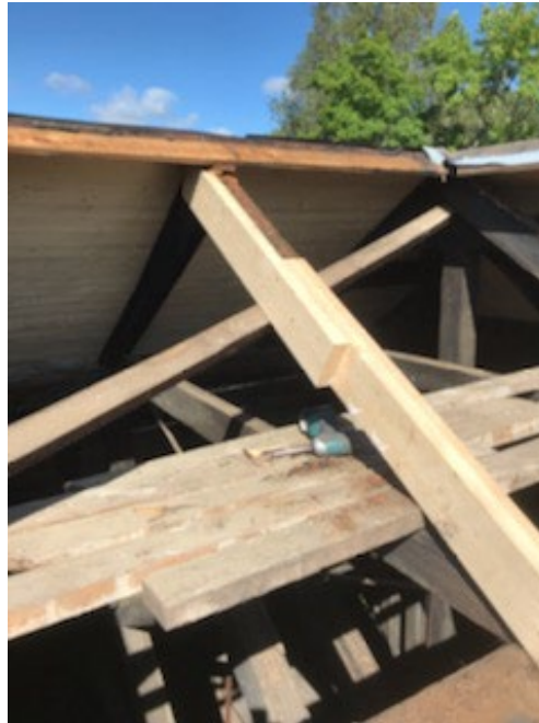
Figur 28. Ilagning av takstol på lanternin. Foto: Rodab Plåtslageri, 2021-09-11.
