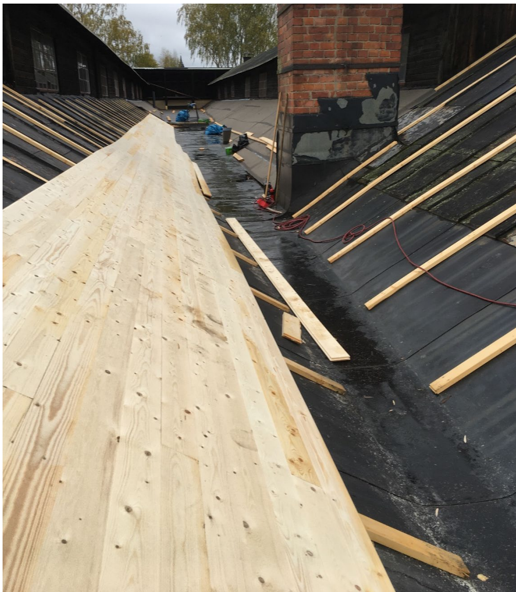
Figur 15. Under pågående arbeten med ränndalen. Rännans lutning är under uppbyggnad. Foto: Sune Lang, Stiftelsen Wij valsverk, hösten 2020.
