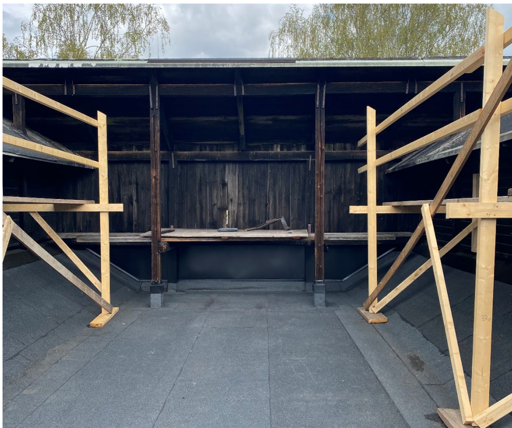
Figur 17. Under pågående arbeten. Fotot är taget mot den nya rännans högsta punkt, den som vetter mot nordöst. Tidigare leddes vatten ner även mot denna sida, efter arbetena sker avrinning endast mot valsverkets baksida. Foto: 2021-05-18.
