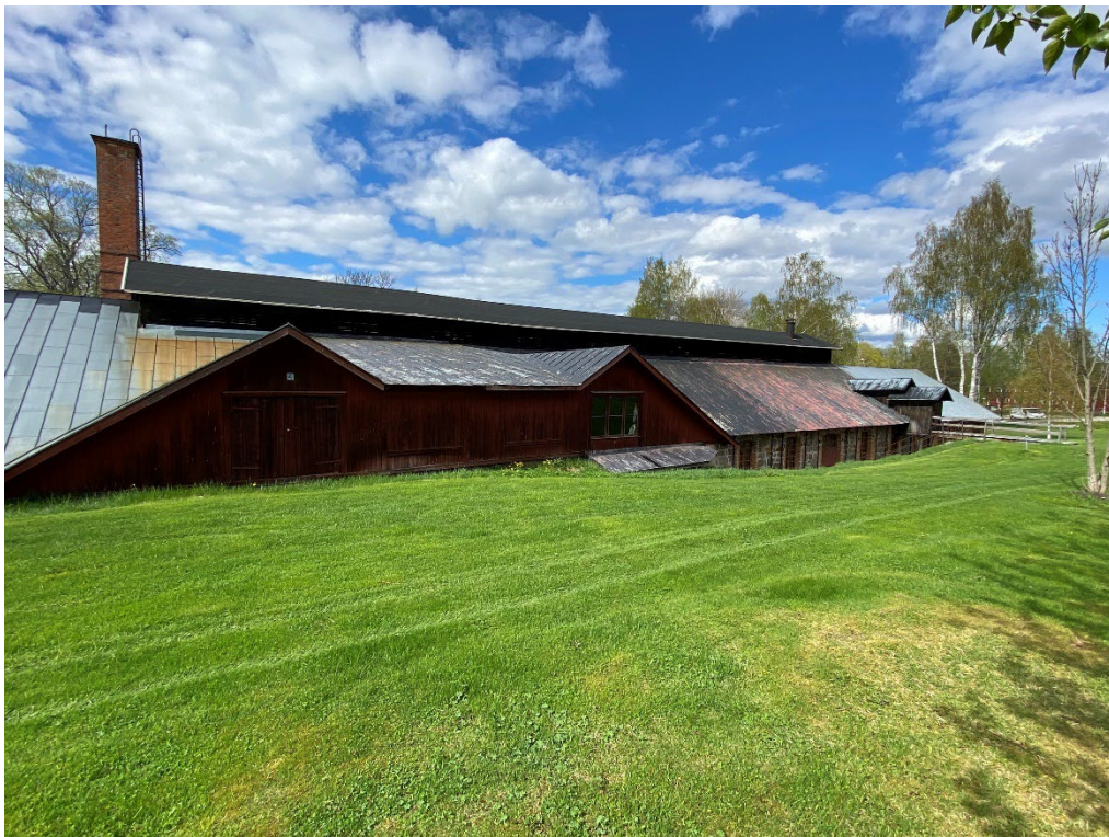
Figur 31. Takfallen mot sydöst innan påbörjade målningsarbeten. Foto: 2021-08-13.
