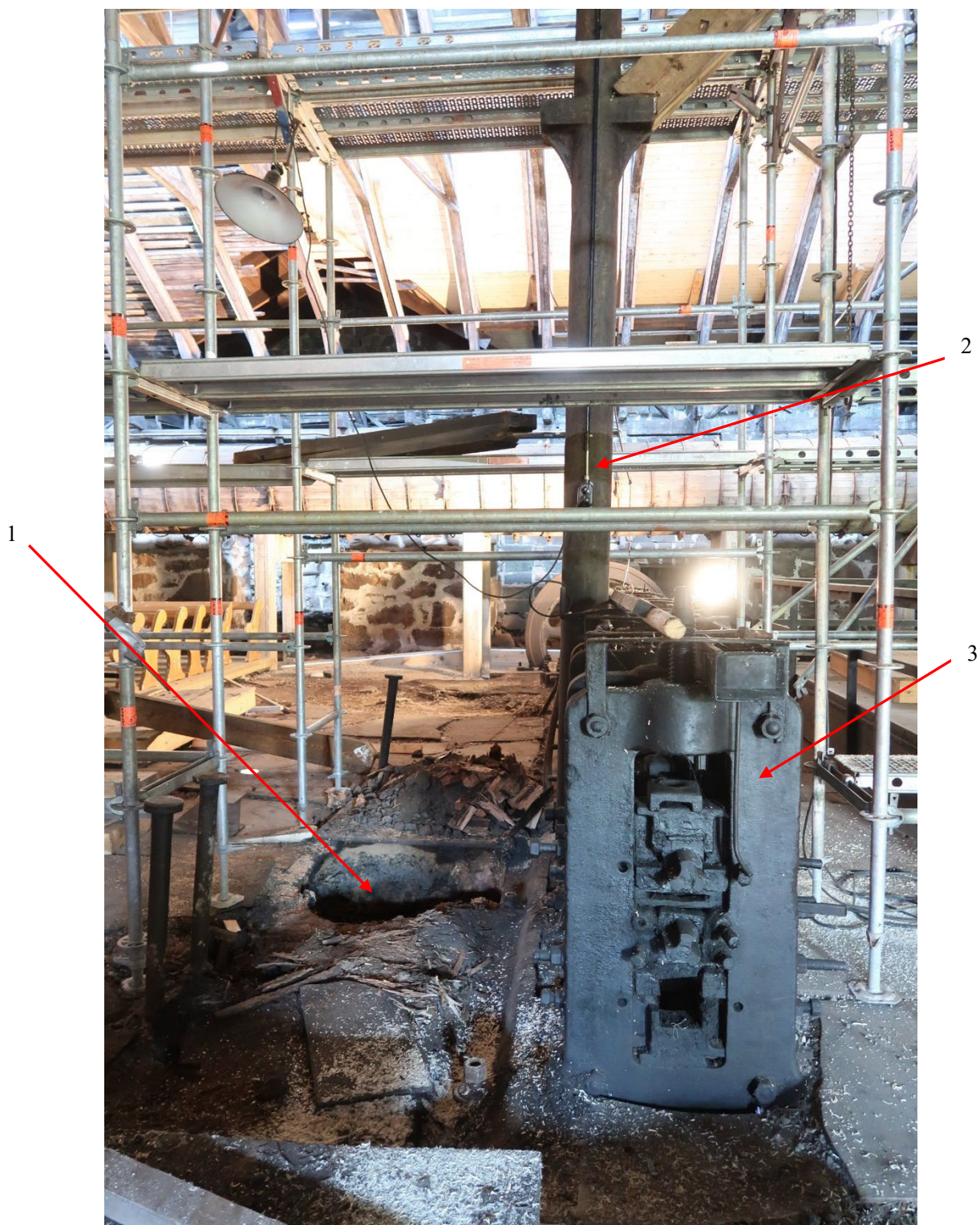
Figur 9. Flytten av stolpen är förberedd. 1 markerar hålet i vilket det nya fundamentet ska gjutas innan flytten av stolpen. 2 markerar stolpen som ska flyttas. 3 markerar maskineri för valsning. Foto: 2020-06-16.
