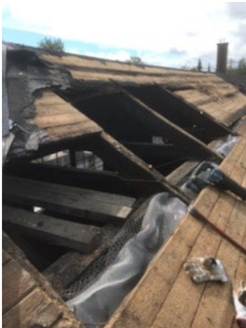
Figur 27. Arbeten med panel och takstolar pågår på lanterninerna. Foto: Rodab Plåtslageri, 2021-09-11.
