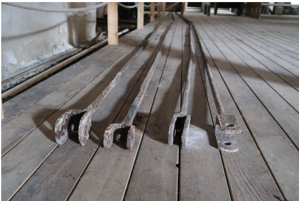
Figur 12. Dragstagen innan återmontering. Foto: 2020-04-27.
