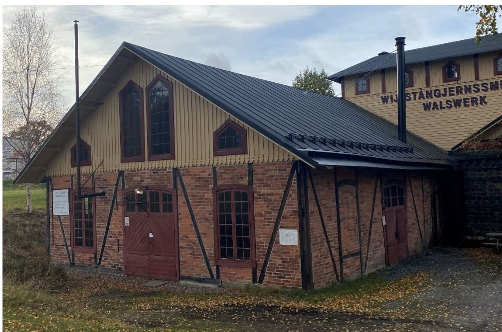
Figur 35. De panelklädda fasaderna efter avslutade arbeten. Foto: 2022-10-13.
