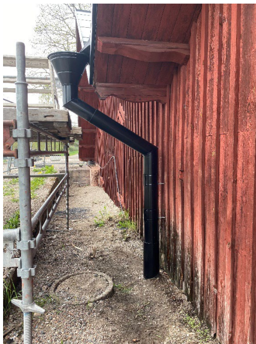
Figur 23. Via stupröret leds vattnet ner i en betongtrumma. Foto: 2021-05-18.
