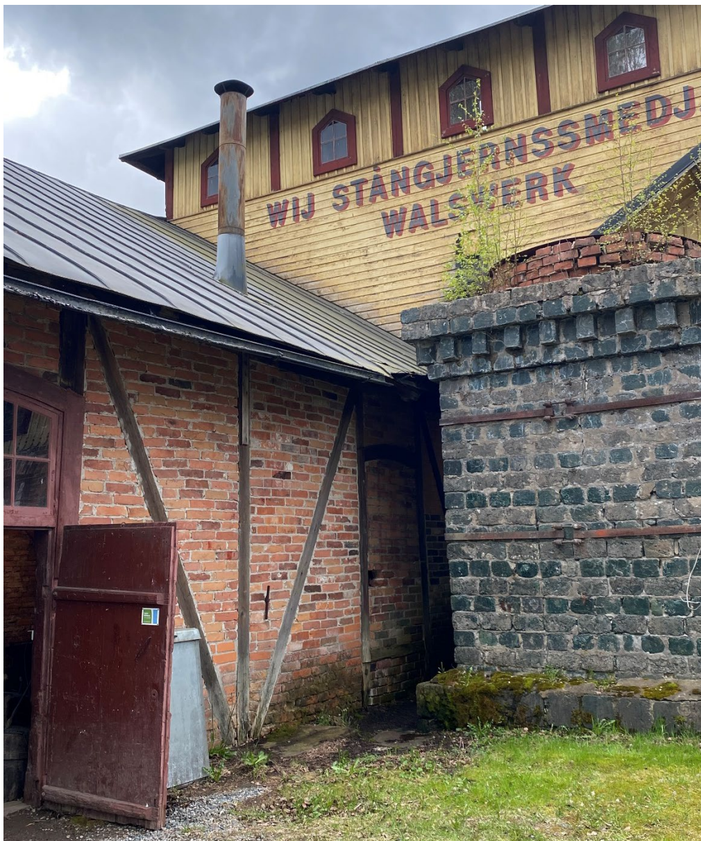
Figur 33. Den panelklädda fasaden innan påbörjade målningsarbeten, se även figur 14. Foto: 2020-08-13.
