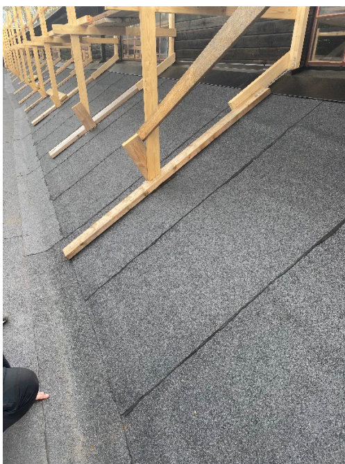
Figur 18. Underlagsduken är uppdragen ända upp till lanterninerna för att så långt som möjligt säkerställa ett tätt skick i rännan. Ännu återstår plåt på sidorna. Foto. 2021-05-18.
