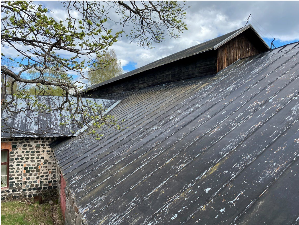
Figur 30. Valsverkets plåttak innan påbörjade arbeten. Färgen flagade kraftigt. Foto: 2021-05-18.
