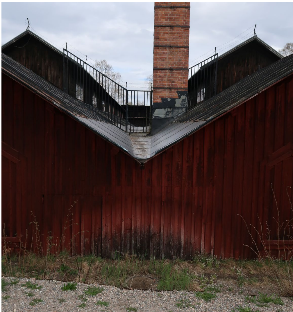
Figur 13. Rännan innan påbörjade arbeten. Notera att vattnet kastades ut och ner i en brunn nedanför. Foto: 2020-04-27.
