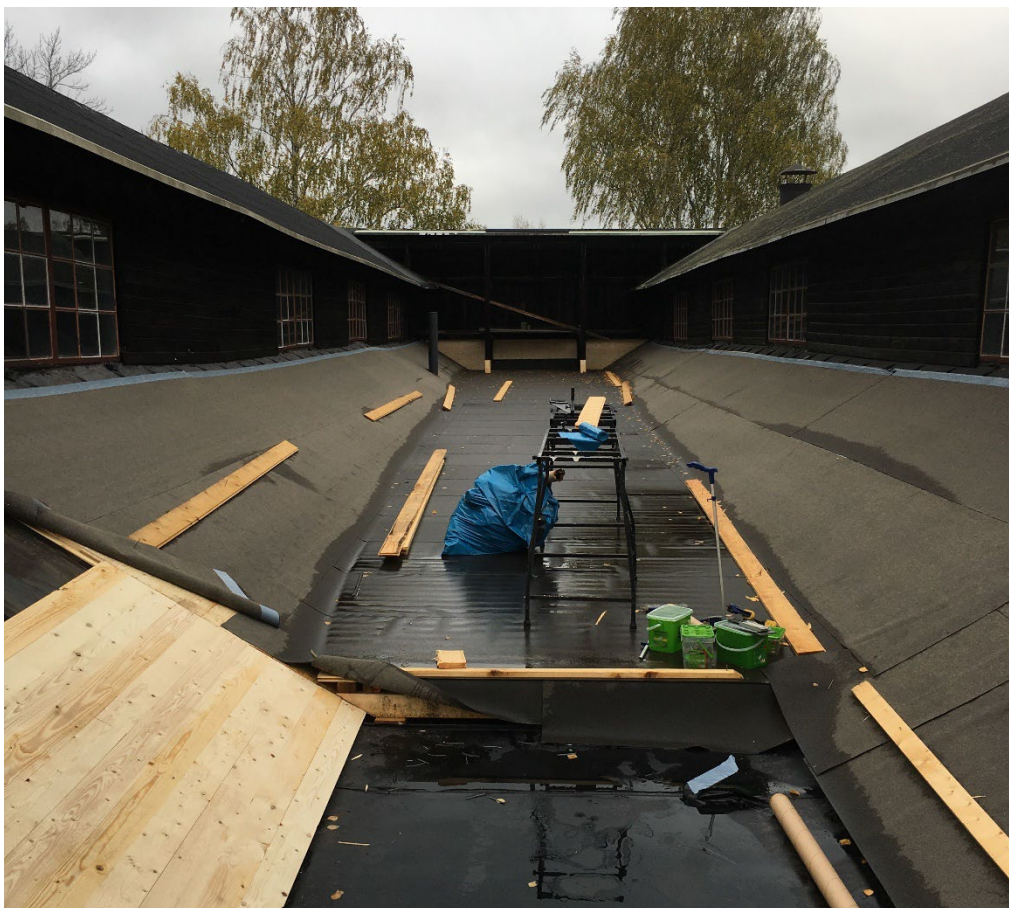
Figur 16. Fotot visar hur ränn dalens övre del har byggts upp och hur arbetet med den främre delen pågår. Foto: Sune Lang, Stiftelsen Wij valsverk, hösten 2020.
