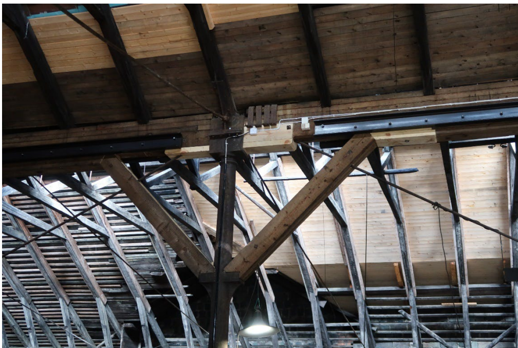
Figur 10. Stålpelaren är flyttad till sitt ursprungliga läge. Bärlinan är förstärkt med trälagningar, kilar och u-balk. Foto: 2020-08-13.
