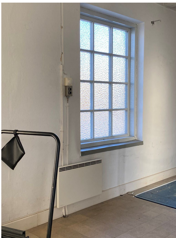
Figur 7. Fönster, nischer och vägg innan påbörjade arbeten. Notera den asymmetriska placeringen av radiatorm. Foto: 2022-01-25.
