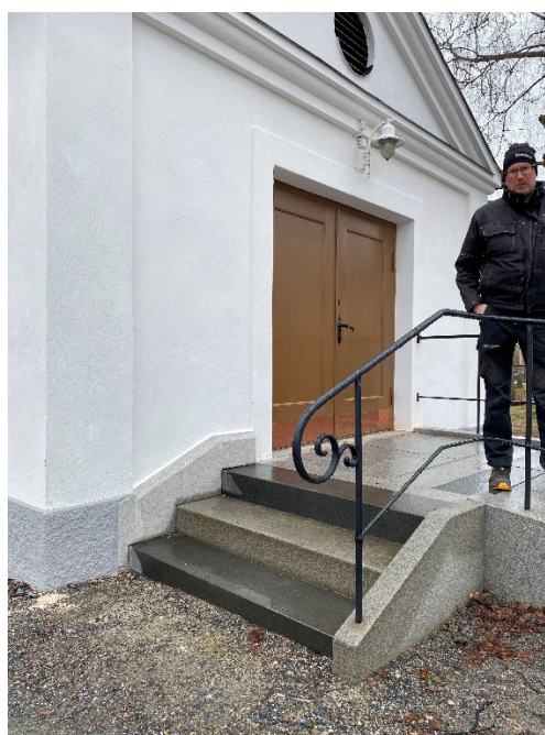
Figur 10 och figur 11. Rampen upp till entrén har försetts med räcken på båda sidor. Också trappan har försetts med ett räck. Foto: 2023-04-26.
