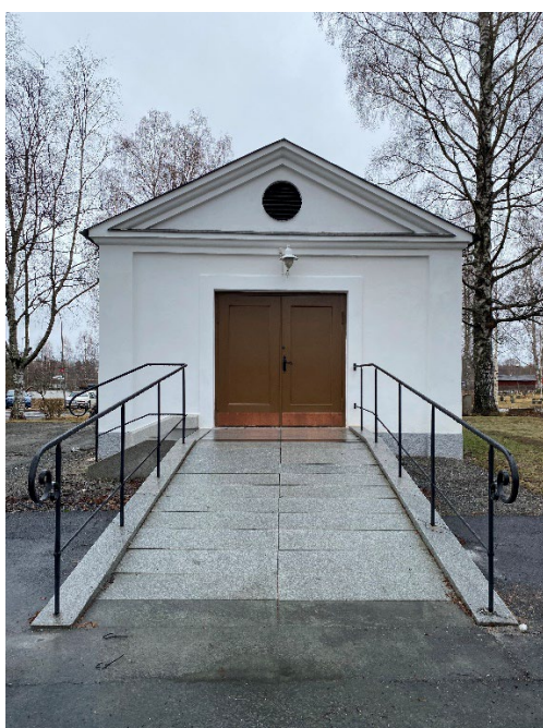
Figur 10 och figur 11. Rampen upp till entrén har försetts med räcken på båda sidor. Också trappan har försetts med ett räck. Foto: 2023-04-26.
