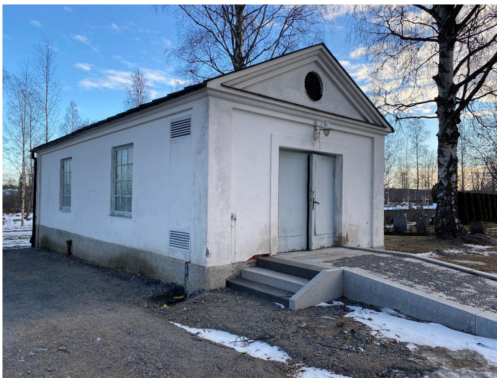
Figur 2. Bisättningshuset sett från nordväst innan påbörjade arbeten, foto 2022-01-25.
