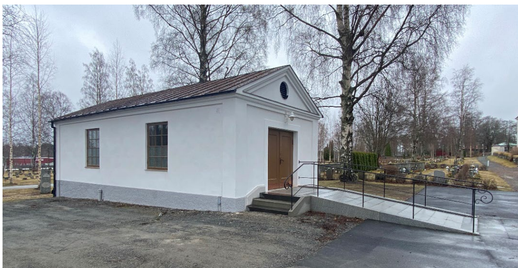
Figur 8. Bisättningshuset sett från nordväst efter avslutade arbeten. Foto: 2023-04-26.
