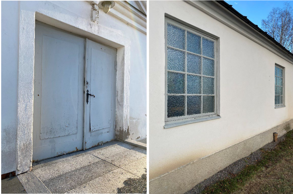
Figur 3 och figur 4. Entréporten samt fönstren på bisättningshuset, innan påbörjade arbeten, foto: 2022-01-25.
