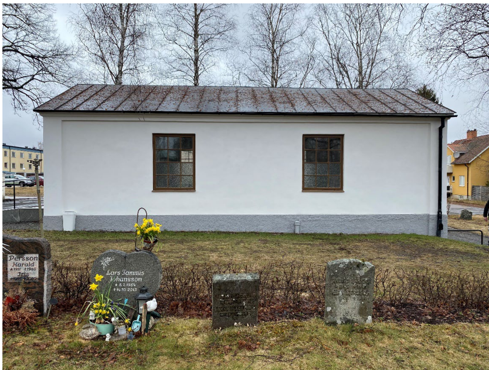
Figur 9. Bisättningshuset sett från söder efter avslutade arbeten. Notera klarglas i de två övre spröjsraderna. Notera även löv på taket. Foto: 2023-04-26.
