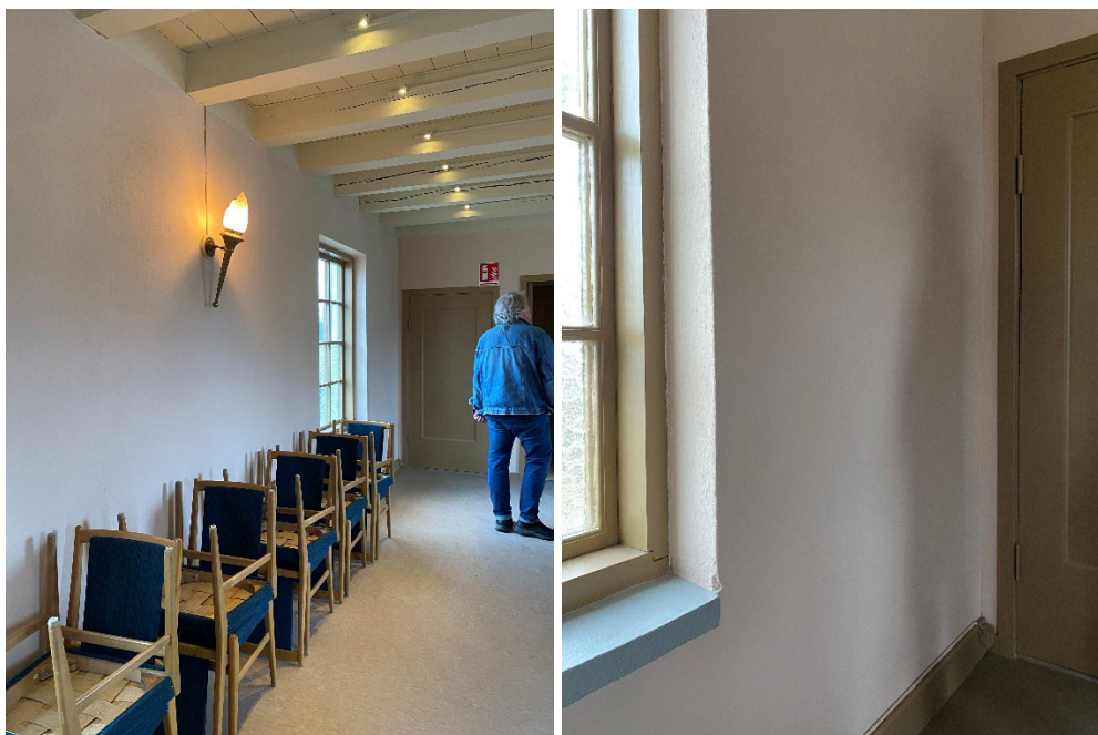
Figur 4. Samtliga ytskikt har återfått de kulörer som påträffats underst i kulördokumentationen. Foto: 2023-04-26.
