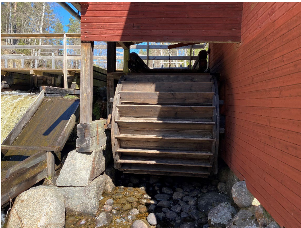
Figur 5. Till vänster om vattenhjulet syns stödpallen innan påbörjade arbeten. Foto: 2023-05-08.
