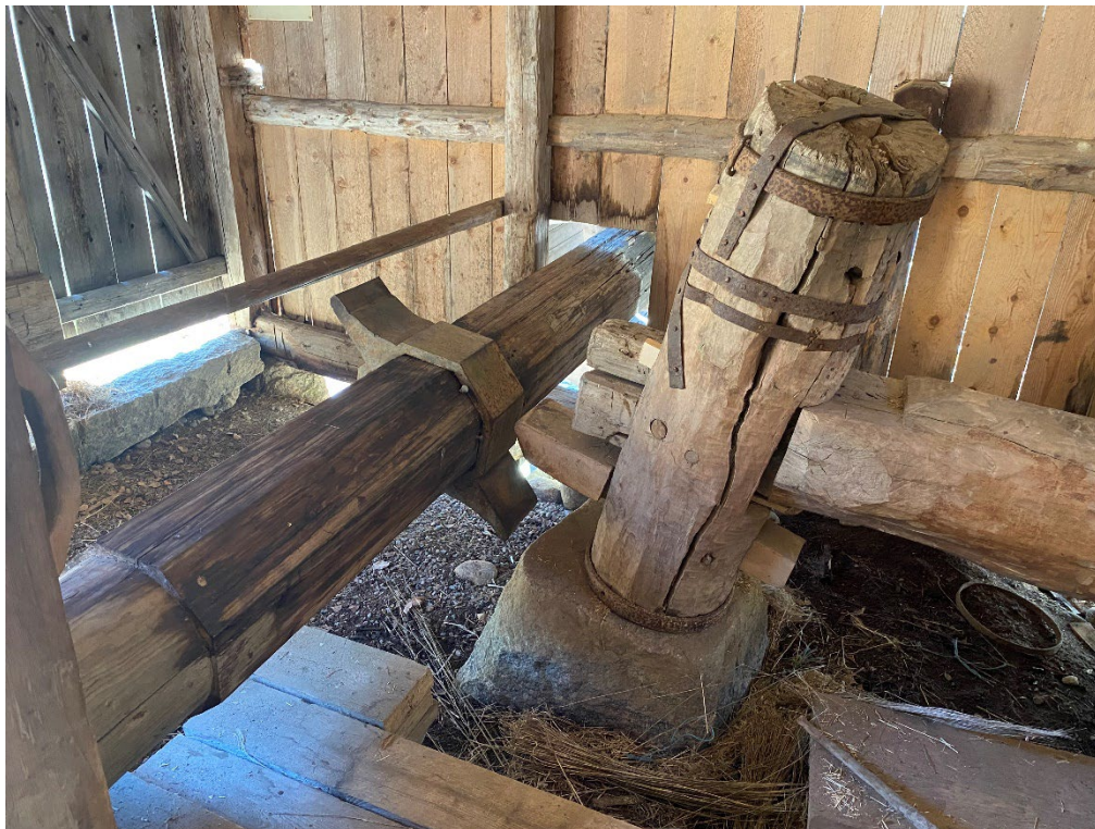
Figur 2. Axel och hammarhuvud i linsläppen innan påbörjade arbeten. Foto: 2023-05-08.
