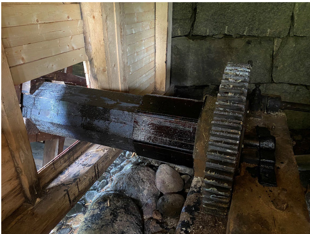
Figur 10. Den nya axeln i linskäkten är tjärstruken till sin helhet. Foto: 2023-08-22.
