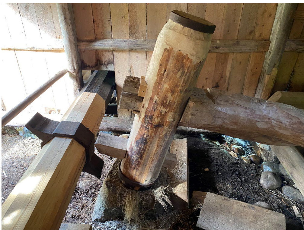
Figur 7. Ny axel och nytt hammarhuvud i linklappen. Samtliga äldre smidesbeslag och infästningar på dessa delar är värmda på plats. Notera att tjärstrykningen på axeln är indragen in i byggnaden. Foto: 2023-08-22.
