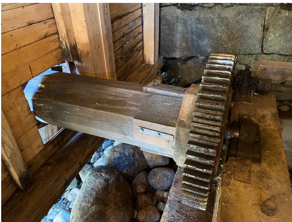
Figur 4. Linklappens axel innan påbörjade arbeten. Foto: 2023-08-08.
