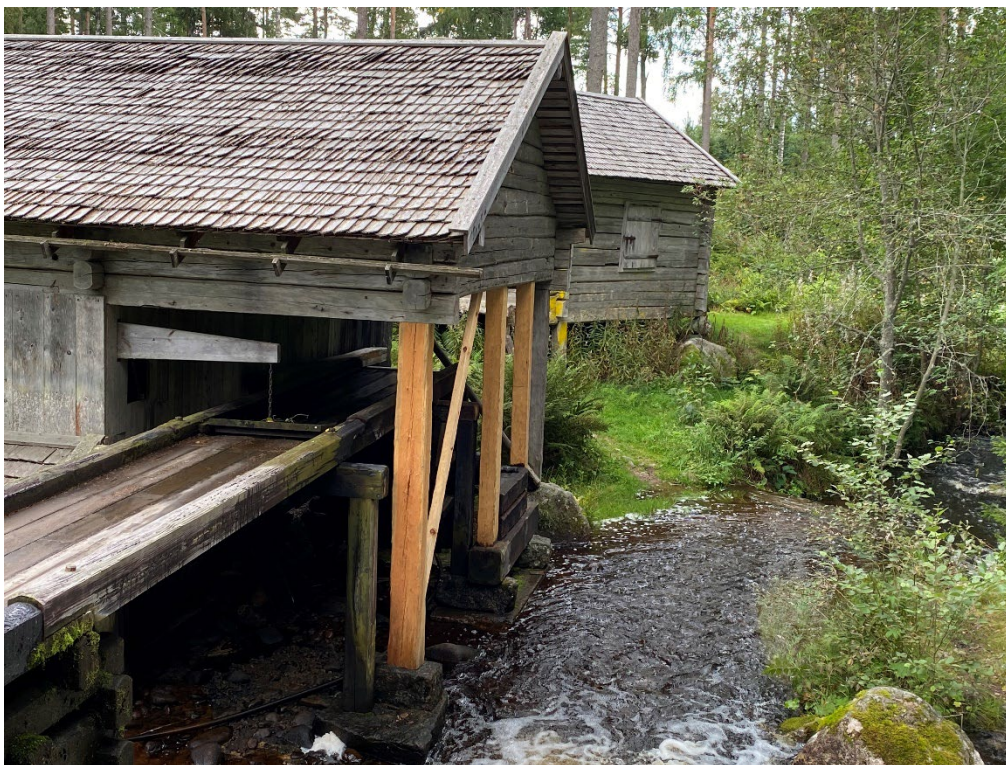
Figur 9. Vid linklappen har tre stolpar och en snedsträva nyttilverkats, den fjärde utbytta stolpen fanns i lager i Trollöden. Foto: 2023-08-22.
