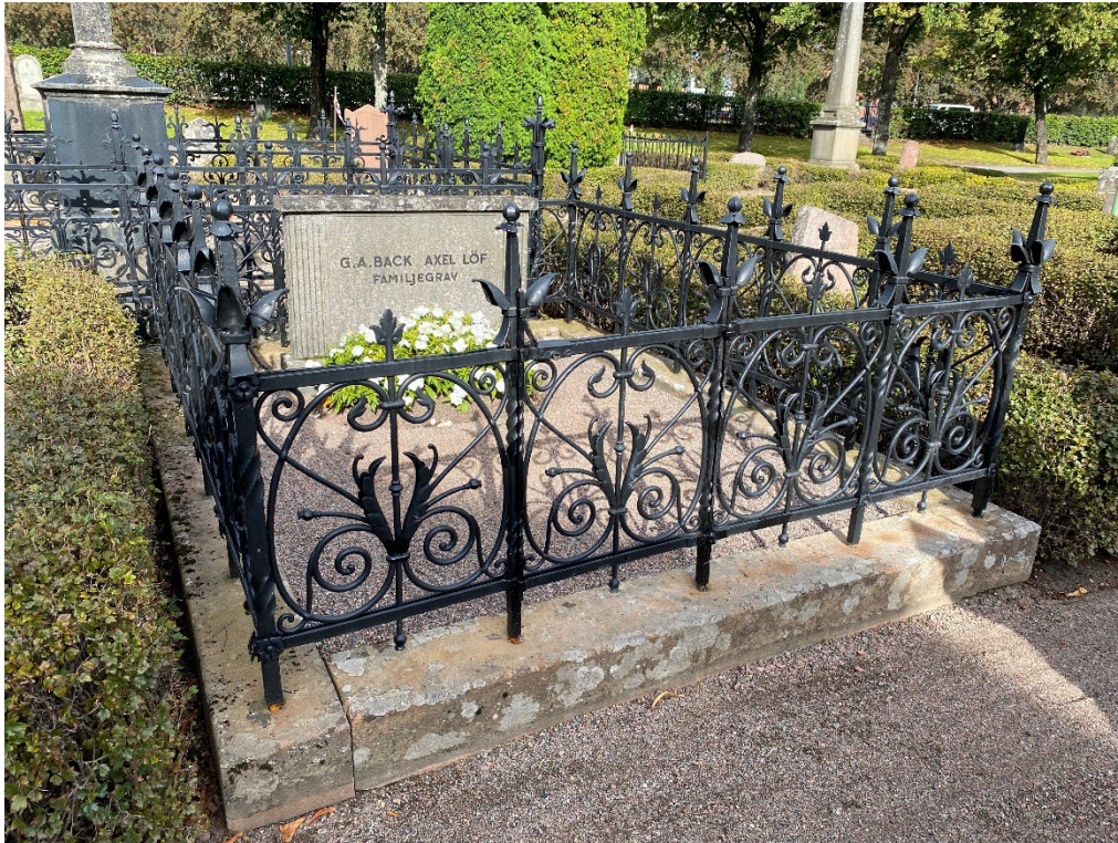
Figur 18. K03 0253 efter avslutade arbeten. Riktad stenram och justerat och renoverat smidesstaket. Stängningsfunktionen på grinden är åtgärdad. Foto: Ulrika Olsson, 2023-09-18.
