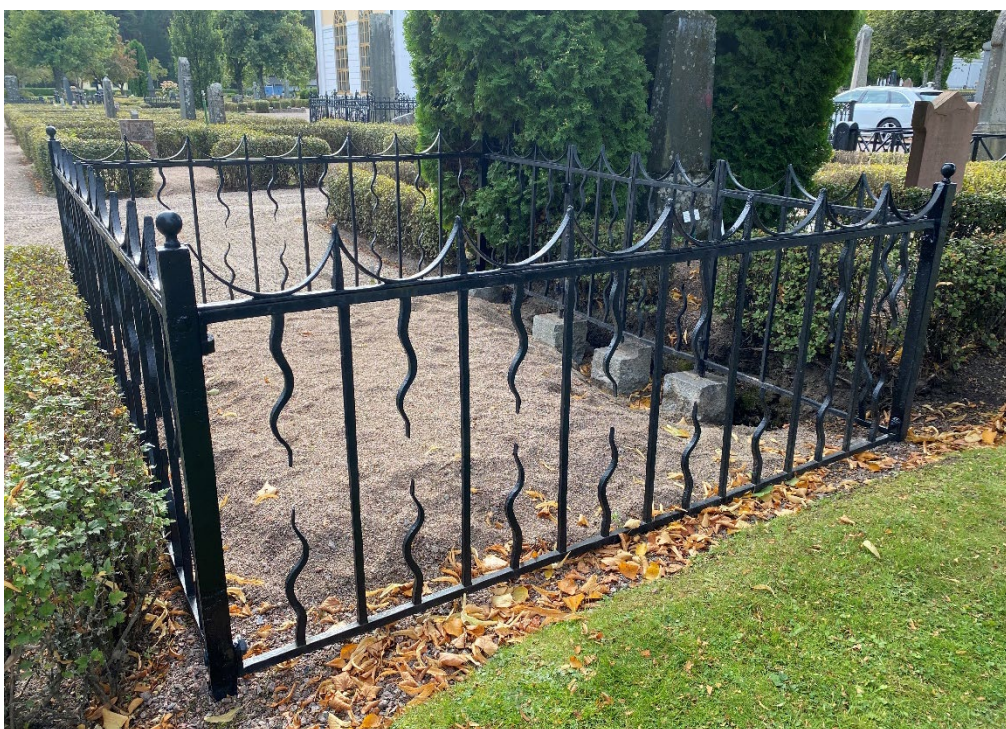
Figur 3. K03 0077 efter åtgärd. Ännu är marken inte uppfylld. Grinden öppnas inåt graven. Stenen som grinden stängs mot har en liten klack för att grinden inte ska kunna glida upp utåt. Foto: Ulrika Olsson, 2023-09-18.
