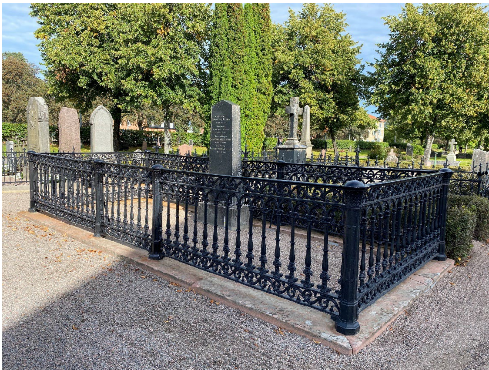
Figur 14. K03 0248 efter avslutade arbeten. Gjutjärnsstaketet är åtgärdat och stenramen riktad. Staketsektionerna är återmonterade i dess rätta lägen. Foto: Ulrika Olsson, 2023-09-18.
