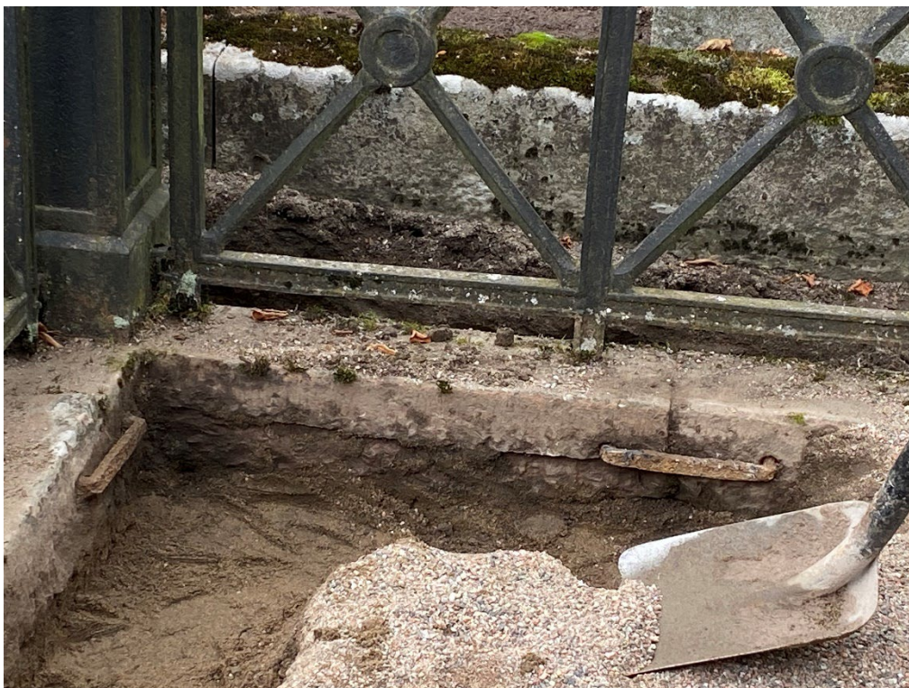
Figur 8. K03 0246 under pågående arbeten med stenramen. Äldre kramlor blev synliga. Foto: Ulrika Olsson, 2021-09-28.
