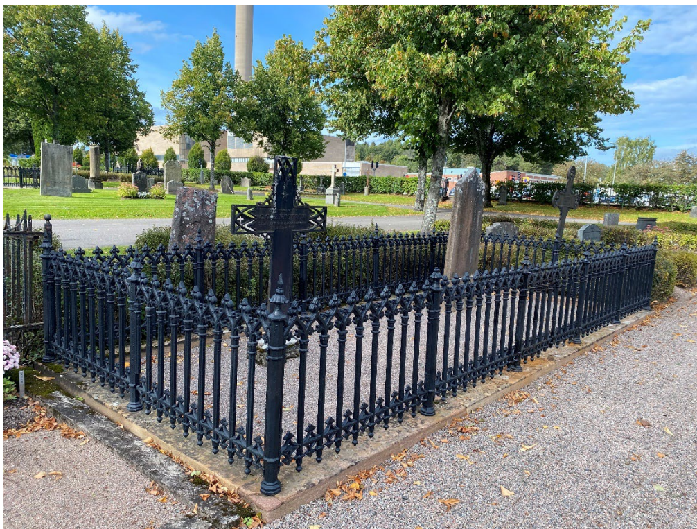
Figur 6. K03 0187 efter avslutade arbeten. Foto: Ulrika Olsson, 2023-09-18.
