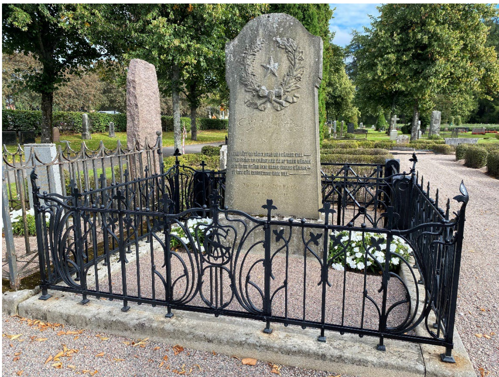
Figur 11. K03 0247 efter avslutade arbeten. Riktad stenram och renoverat smidesstaket. Foto: Ulrika Olsson, 2023-09-18.
