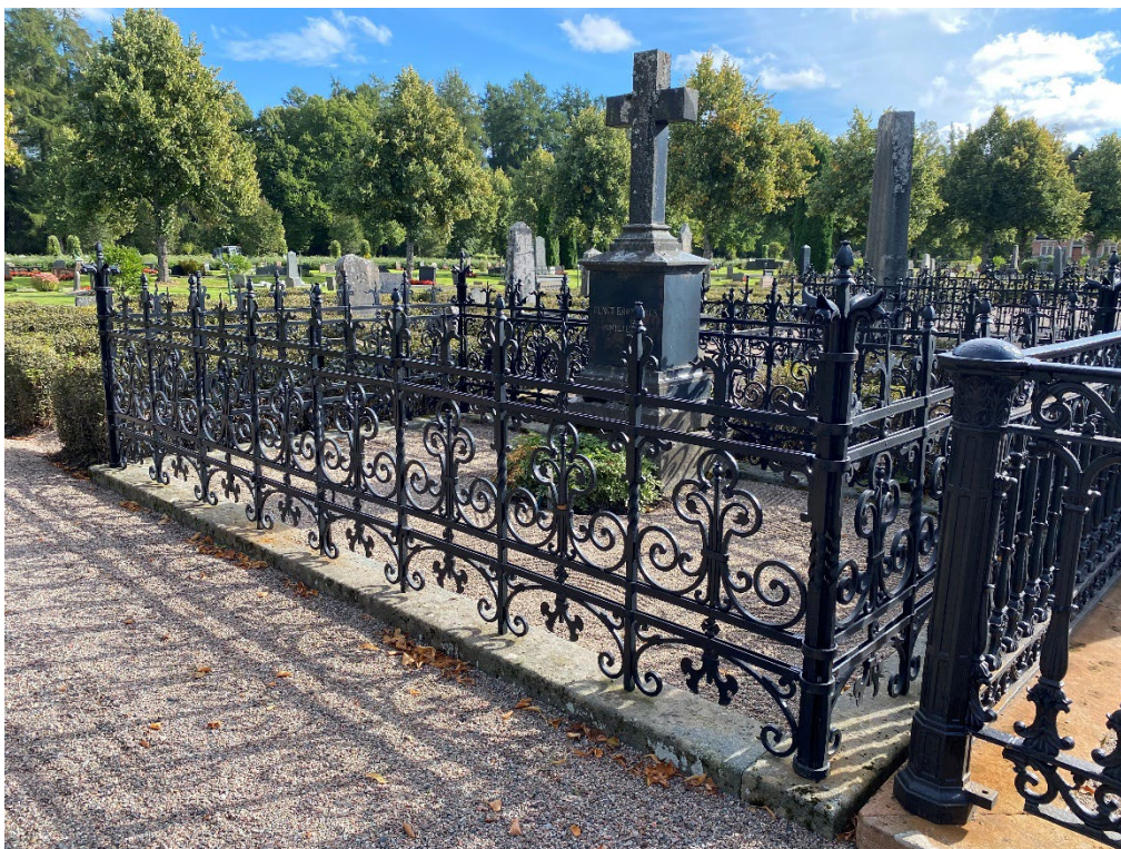
Figur 16. K03 0250 efter avslutade arbeten. Stensockeln är riktad och smidesstaketet renoverat. Foto: Ulrika Olsson, 2023-09-18.
