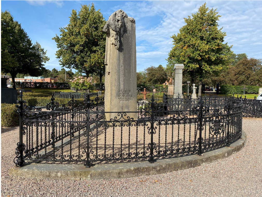
Figur 24. K03 0344 efter avslutade arbeten. Stenramen är justerad och staketet är renoverat. Staketet är målat svart trots framtagen kulörkod. Foto: Ulrika Olsson, 2023-09-18.
