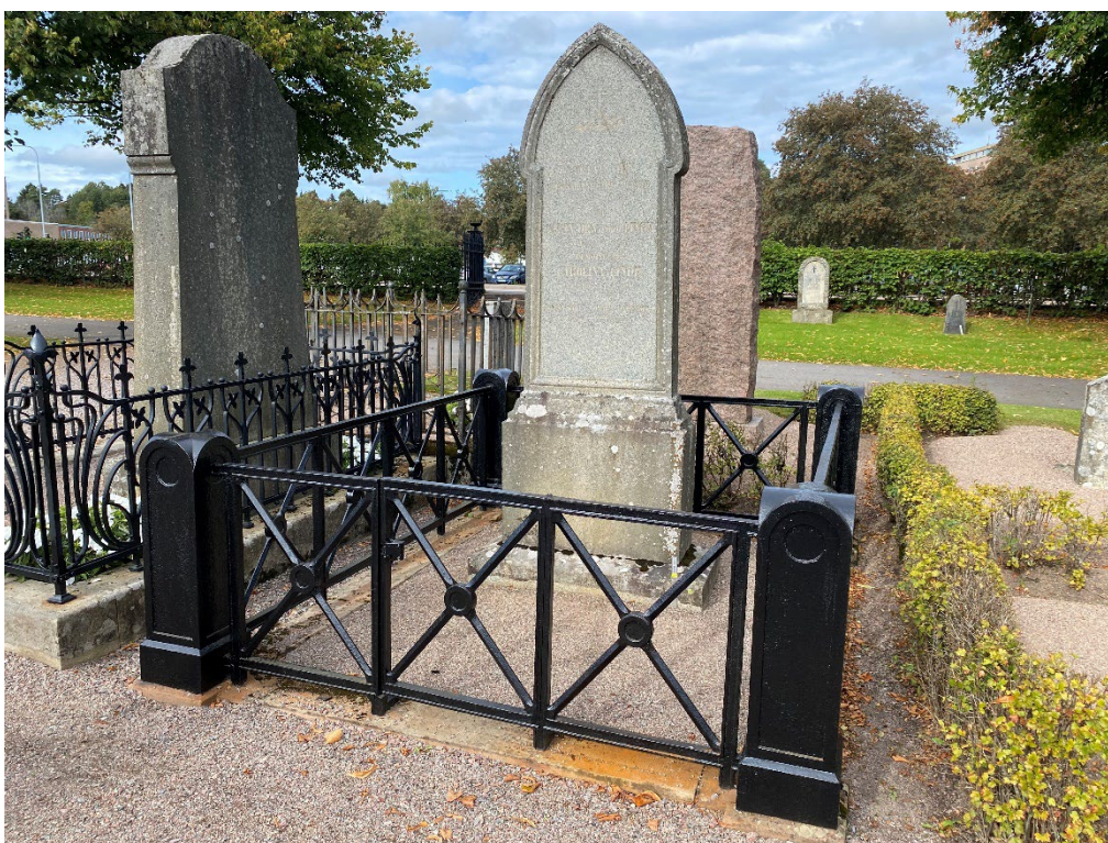
Figur 9. K03 0246 efter avslutade arbeten. Foto: Ulrika Olsson, 2023-09-18.
