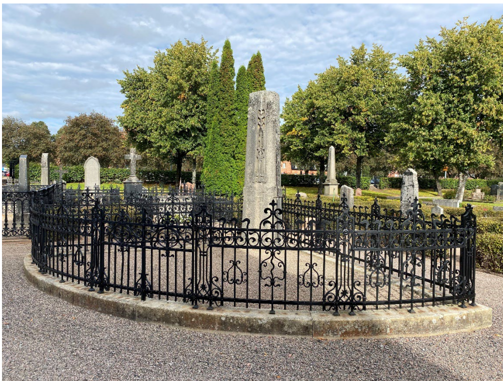
Figur 26. K03 0345 efter avslutade arbeten. Stenramen är justerad och staketet är renoverat. Staketet är målat svart trots framtagna kulörkod. Foto: Ulrika Olsson, 2023-09-18.
