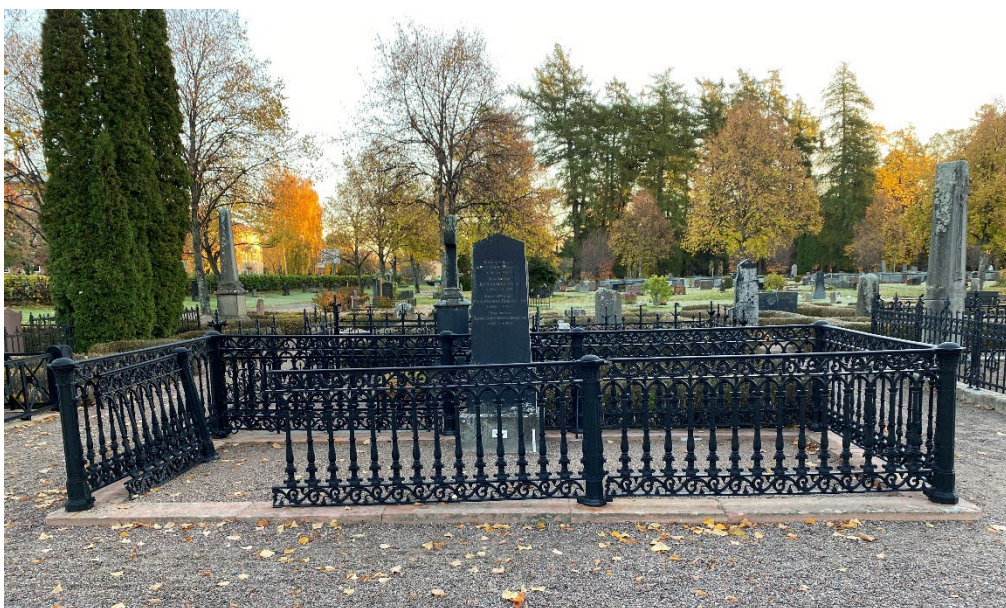
Figur 13. Arbetet med grav K03 0248 var en av orsakerna till att projektet drog ut på tiden. Vid en förväntad slutbesiktning 2022-10-20 såg staketet ut så här. Flera delar var återmonterade i fel läge eller inte återmonterade alls. Foto: Ulrika Olsson, 2022-10-20.
