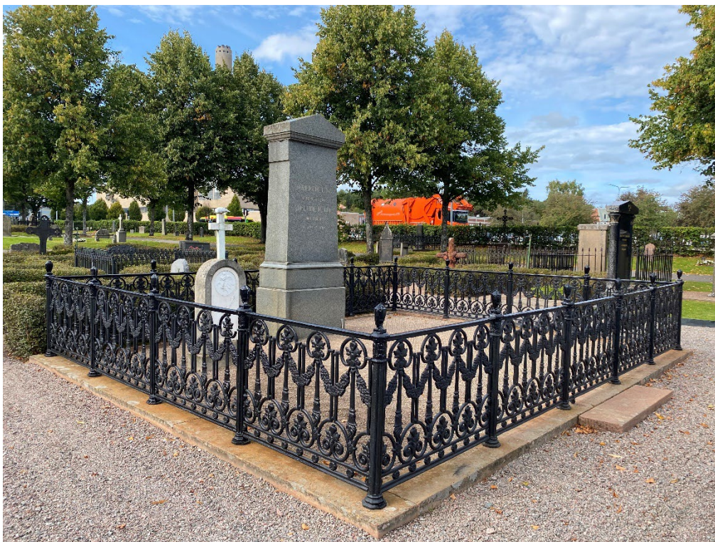
Figur 22. K03 0340 efter avslutade arbeten. Stensockeln har justerats och gjutjärnsstaketet har renoverats. Foto: Ulrika Olsson, 2023-09-18.
