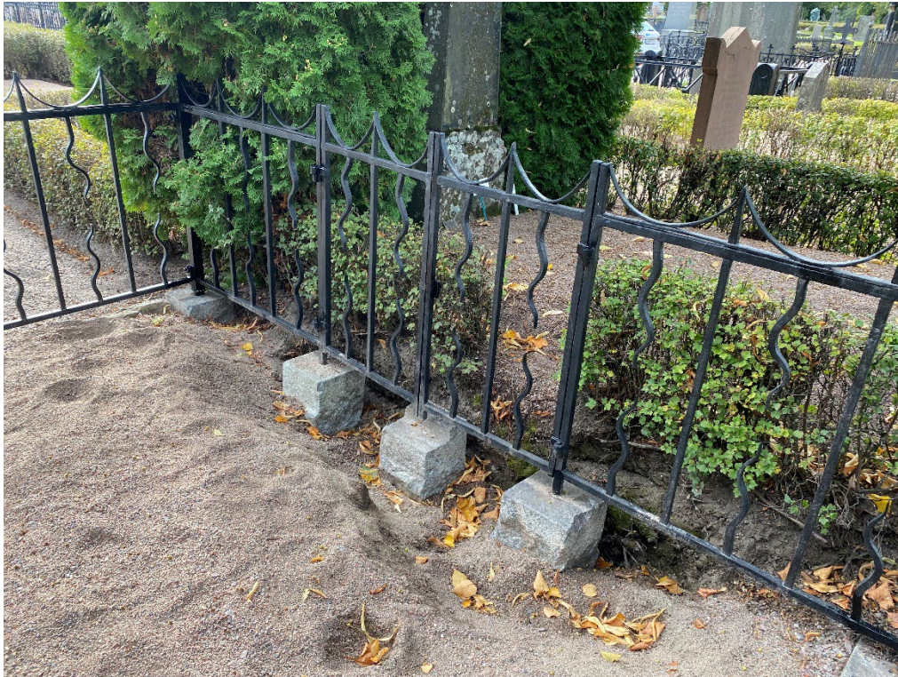
Figur 4. K03 0077 efter åtgärd. Ännu är marken inte uppfylld. Grinden öppnas inåt graven. Stenen som grinden stängs mot har en liten klack för att grinden inte ska kunna glida upp utåt. Foto: Ulrika Olsson, 2023-09-18.
