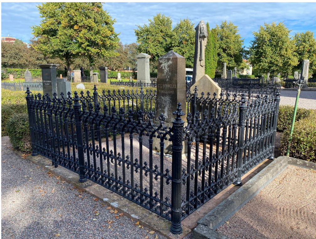
Figur 20. K03 0326 efter avslutade arbeten. Stensockeln har justerats och gjutjärnsstaketet har renoverats. Grinden går att stänga. Foto: Ulrika Olsson, 2023-09-18.
