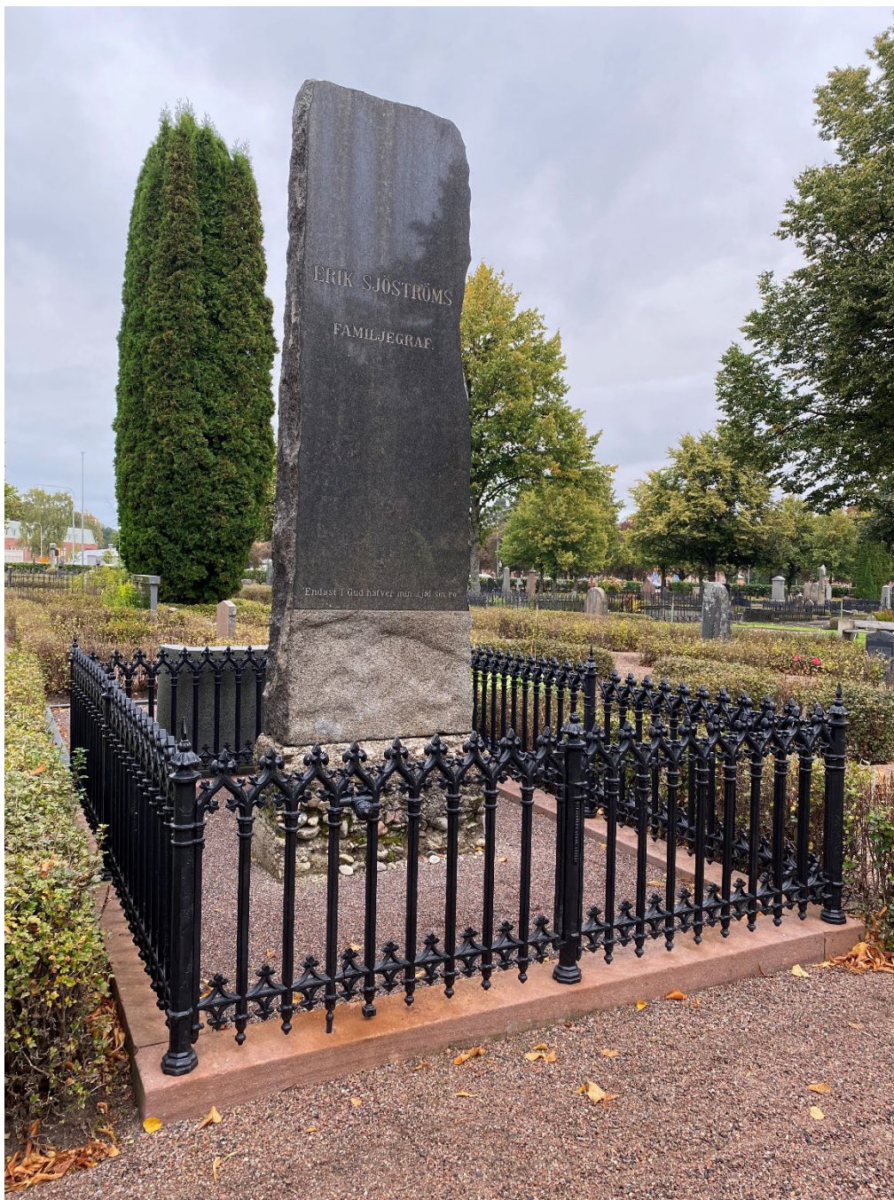
Figur 25. K05 0194 efter åtgärd. Åtgärd av gjutjärnsstaketet krävde mycket svetsarbeten. Stensockeln i sandsten har riktats. Gravplatsens ursprungliga markbeläggning med grus har återskapats. Foto: Ulrika Olsson, 2023-09-29.
