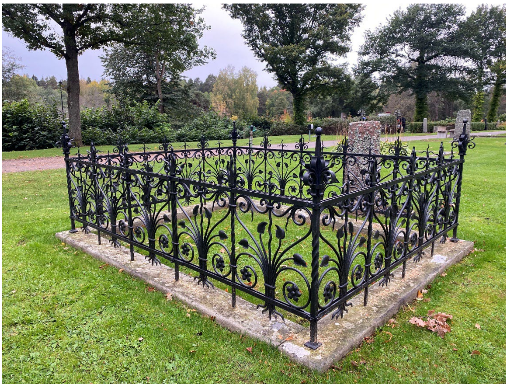
Figur 12. GK06 0390 efter åtgärd. Stensockeln har riktats och smidesstaketet har renoverats. Foto: Ulrika Olsson, 2023-09-29.
