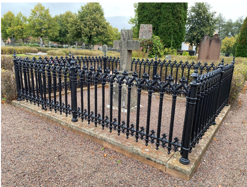
Figur 23. GK05 0283 efter åtgärd. Åtgärd av gjutjärnsstaketet krävde mycket svetsarbeten. Stensockeln har riktats. Gravvården har riktats. Foto: Ulrika Olsson, 2023-09-29.
