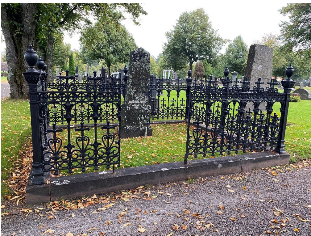
Figur 5. GK06 0089 efter åtgärd. Åtgärd av gjutjärnsstaketet krävde mycket svetsarbeten. Stensockeln var möjlig att åtgärda genom urgrävning precis invid sockeln. Foto: Ulrika Olsson, 2023-09-29.
