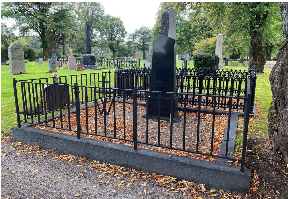
Figur 8. GK06 302 efter åtgärd. Beslut togs om att flytta in just den norra sockelstenen något. Eftersom staketet sitter monterat i västra och östra stensockeln så var denna lösning möjlig att göra. I framtiden när trädet ska tas ner blir det möjligt att flytta ut den norra sockeln igen. Stensockeln har riktats och gravplatsens ursprungliga markbeläggning med grus har återskapats. Foto: Ulrika Olsson, 2023-09-29.
