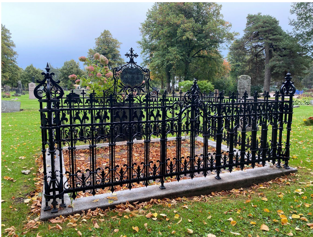
Figur 14. GK06 0450 efter åtgärd. Stensockeln har riktats och smidesstaketet har renoverats. Gravplatsens ursprungliga marktbeläggning med grus har återskapats. Foto: Ulrika Olsson, 2023-09-29.
