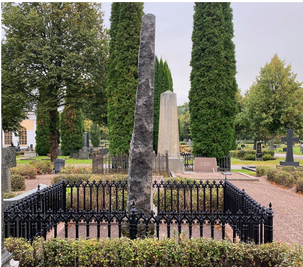
Figur 26. K05 0194 efter åtgärd. Åtgärd av gjutjärnsstaketet krävde mycket svetsarbeten. Stensockeln har riktats. Gravplatsens ursprungliga markbeläggning med grus har återskapats. Från sidan syns tydligt hur gravvården lutar framåt. Foto: Ulrika Olsson, 2023-09-29.
