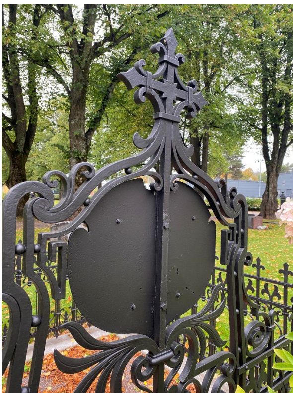
Figur 15. GK06 0450 efter åtgärd. Inskriptionsplattan är skruvad i en järnplåt. Vid renoveringen lossades plattan och plåten renoverades likt smidesstaketet. Foto: Ulrika Olsson, 2023-09-29.
