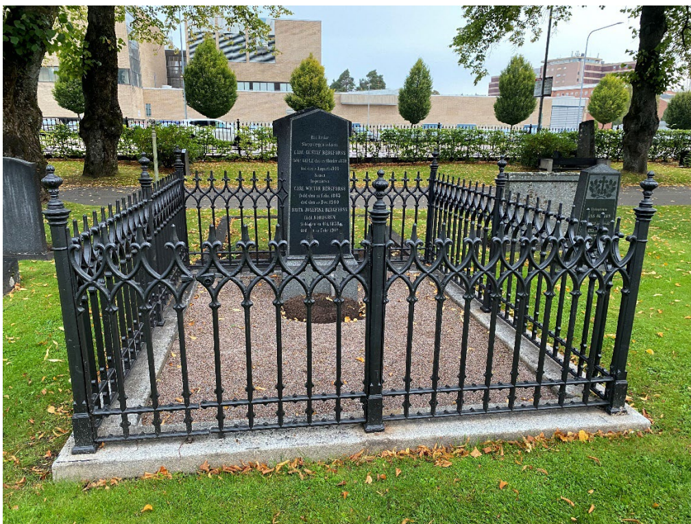
Figur 3. GK06 0150 efter åtgärd. Stensockeln har riktats och gravplatsens ursprungliga markbeläggning med grus har återskapats. Gjutjärnsstaketet har lagats och grunden har återmonterats. Foto: Ulrika Olsson, 2023-09-29.
