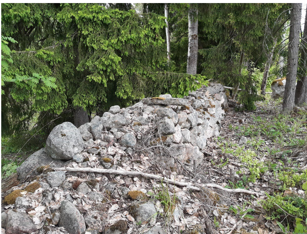
Figur 17. Stenmur L2023:3497 är av i skalmurskonstruktion. Foto: Anna Hellgren.
